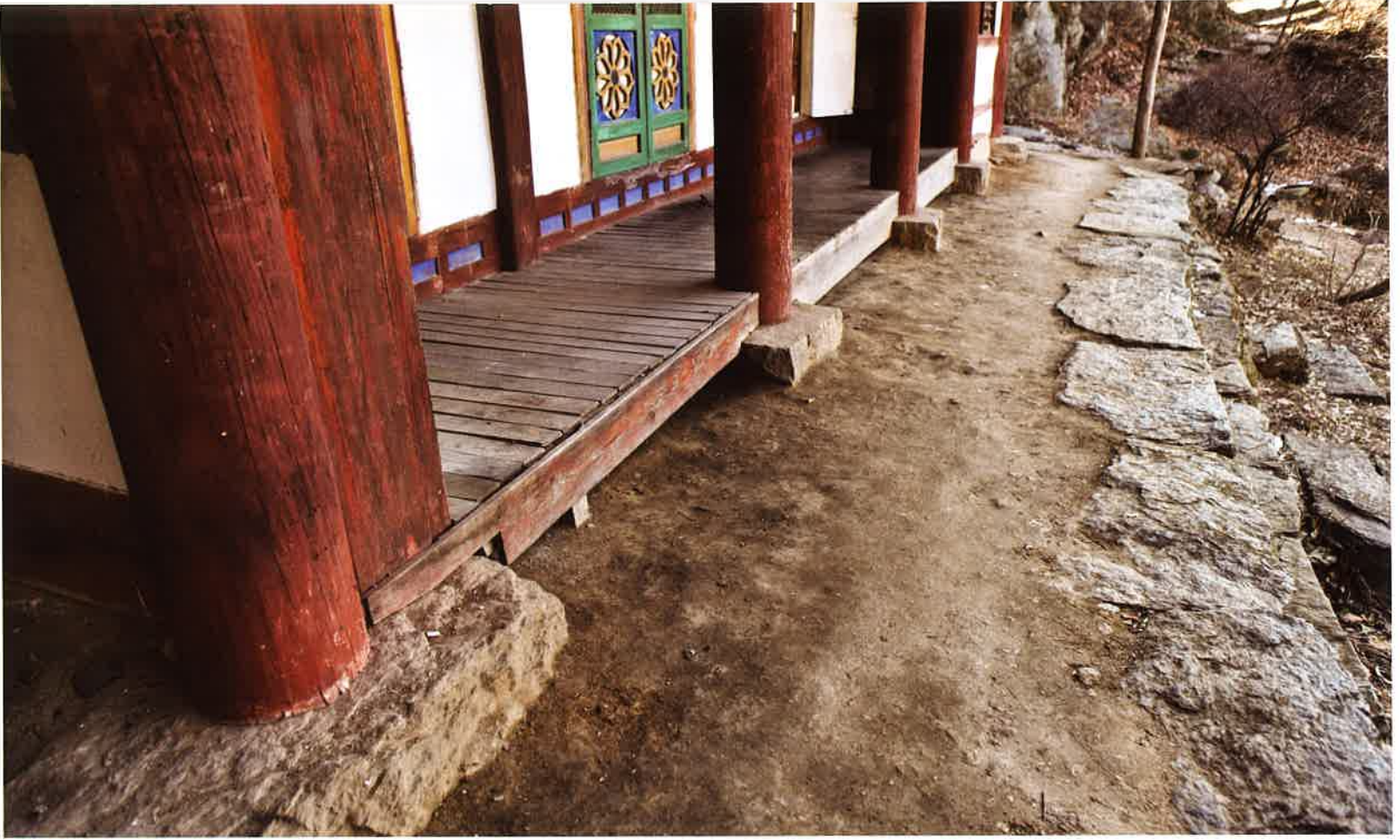
동금강암 앞면 주춧돌 / 東金剛庵 前面 礎石 / front plinths, Tonggümgangam
