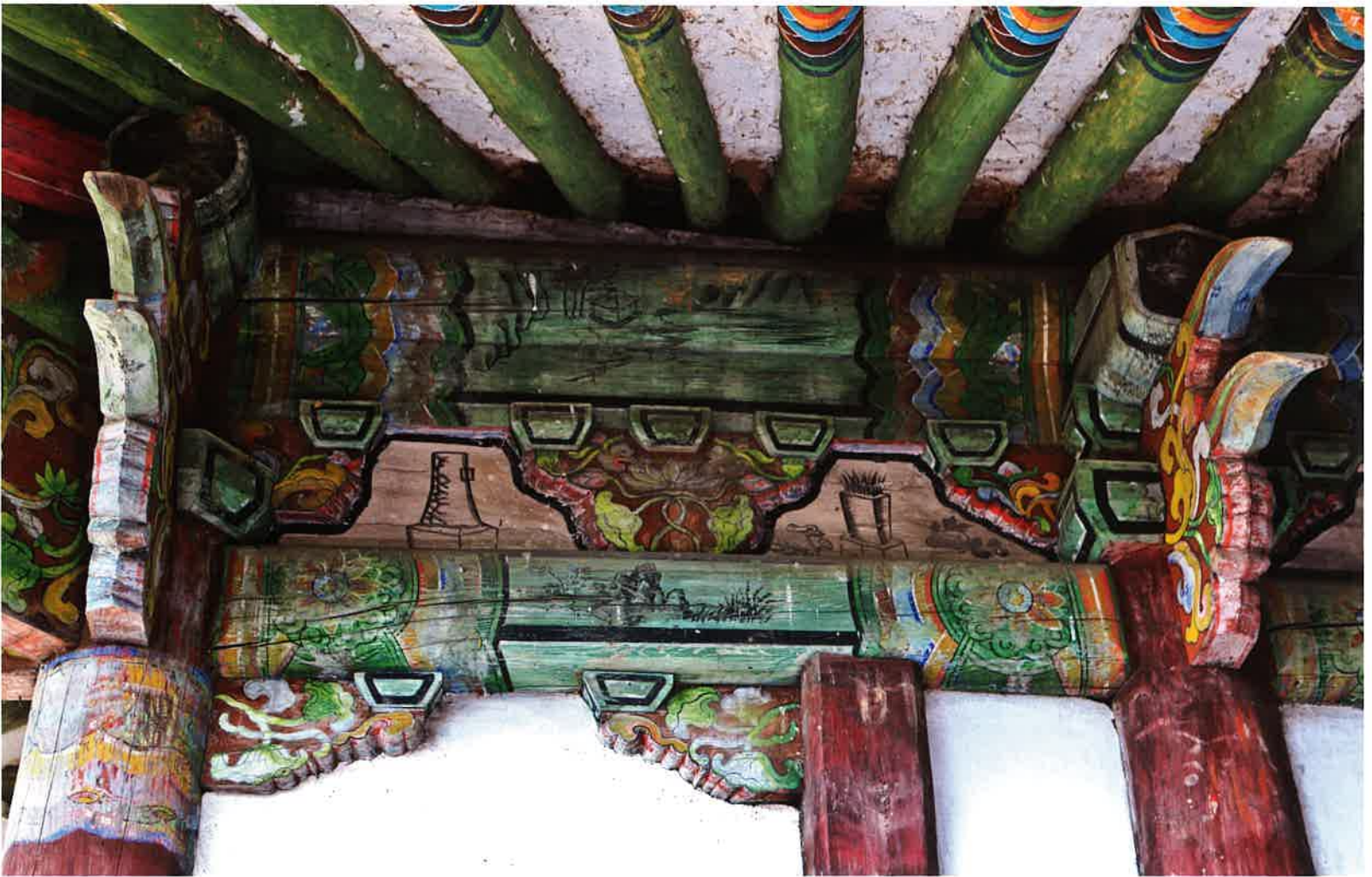
동금강암 동쪽 측면 주상포 / 東金剛庵 東側 柱上包 / brackets above eastern columns, Tonggümgangam
