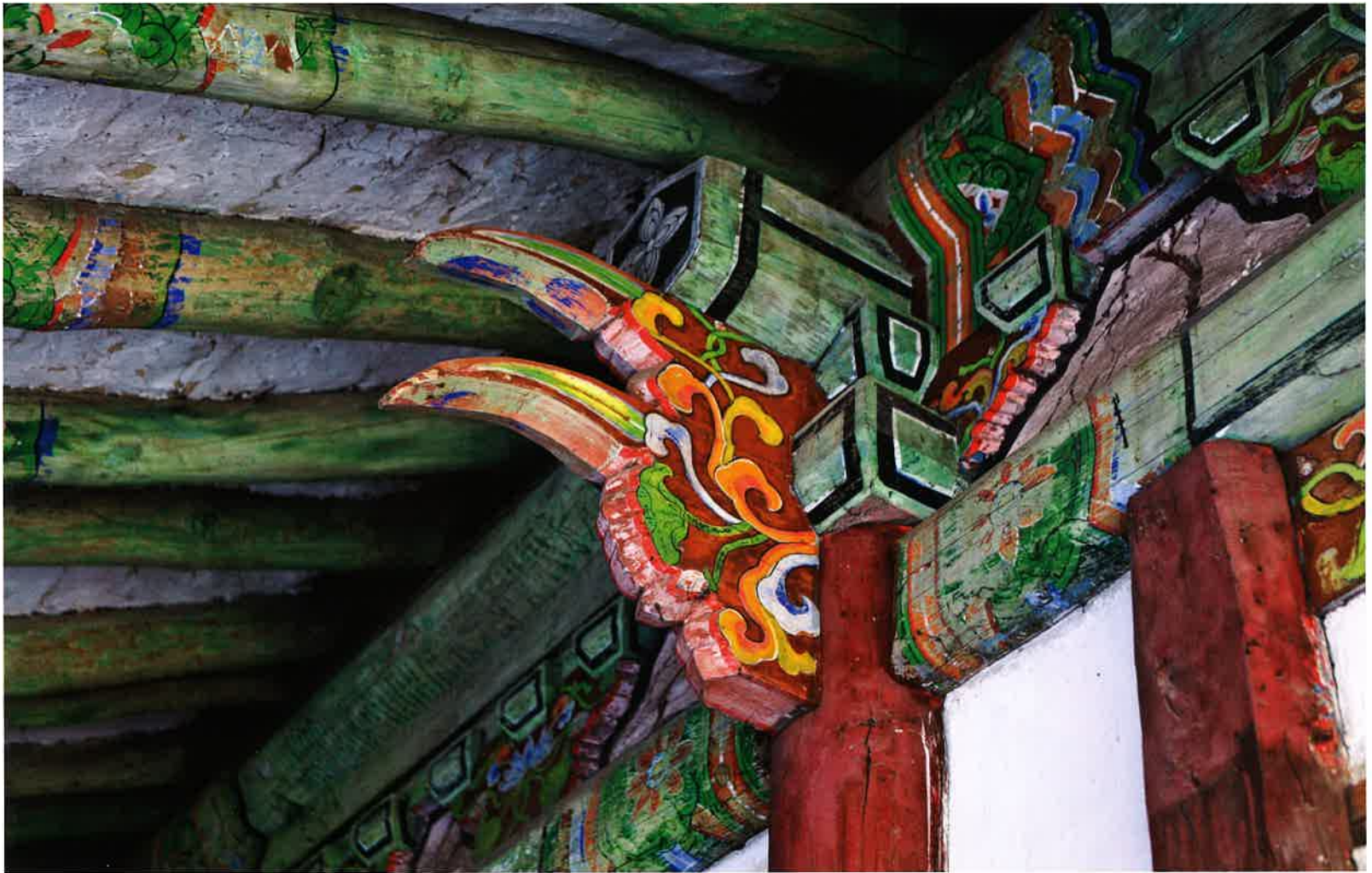
동금강암 서쪽 측면 주상포 / 東金剛庵 西側 柱上包 / brackets above western columns, Tonggūmgangam
