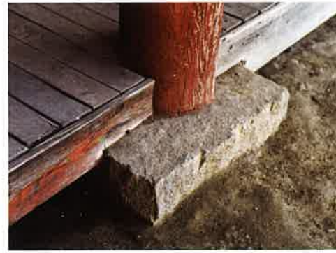
동금강암 앞면 가운데 기둥 주춧돌 1 東金剛庵 前面 平柱 礎石 1 plinth 1 for front middle column, Tonggümgangam
