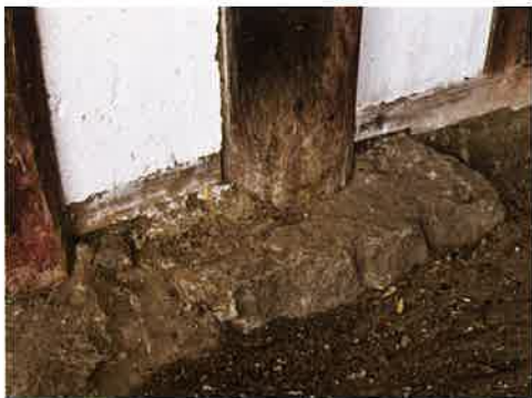
동금강암 동쪽 측면 앞면 귀기둥 주춧돌 東金剛庵 東側 前面 隅柱 礎石 plinth for eastern side front corner column, Tonggümgangam
