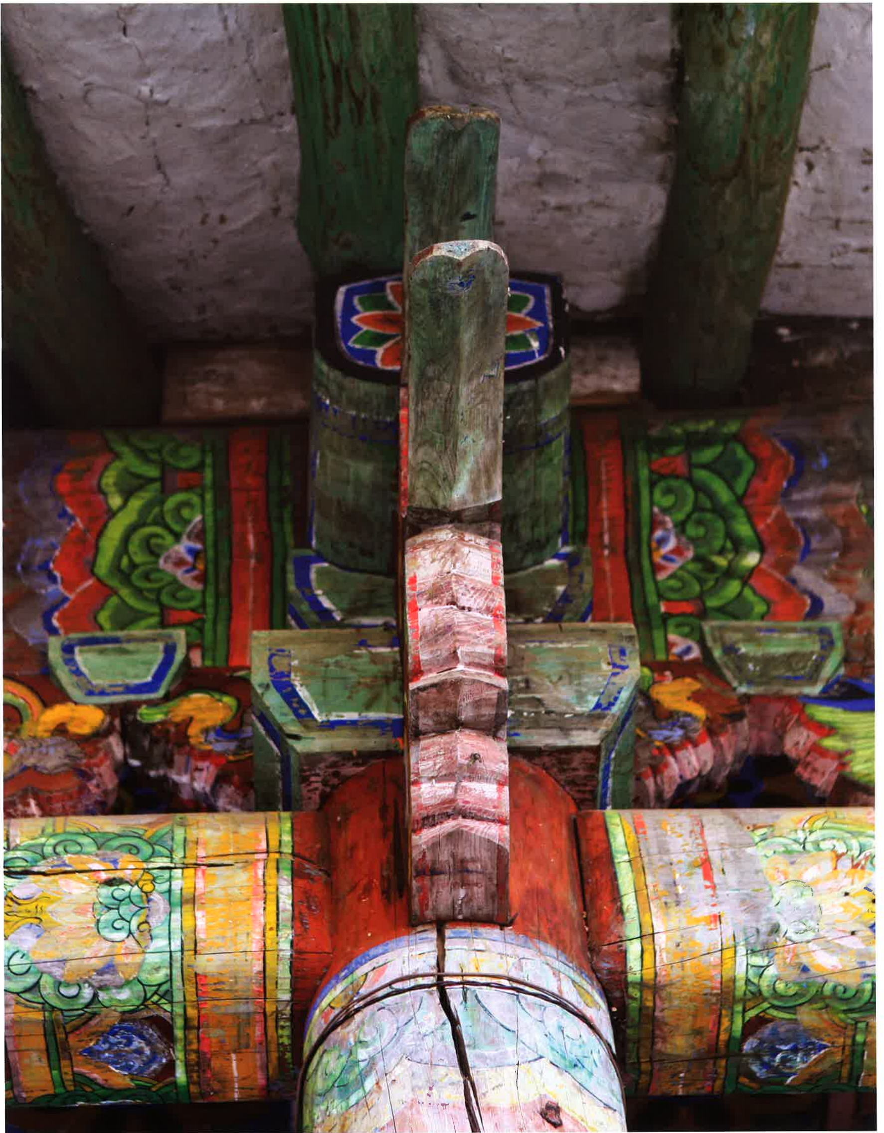
동금강암 앞면 가운데 주상포와 화반 / 東金剛庵 前面 柱上包·花盤 / brackets above front middle columns and Hwaban, Tonggūmgangam
