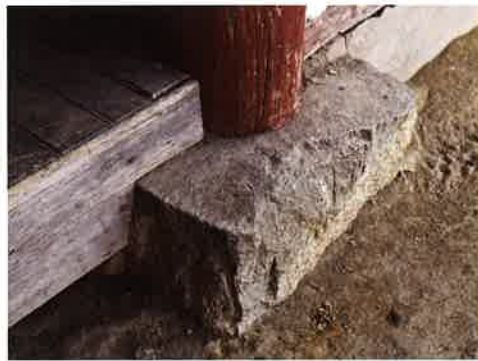
동금강암 앞면 가운데 기둥 주춧돌 3 東金剛庵 前面 平柱 礎石 3 plinth 3 for front middle column, Tonggümgangam
