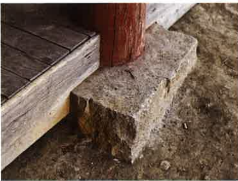
동금강암 앞면 가운데 기둥 주춧돌 2 東金剛庵 前面 平柱 礎石 2 plinth 2 for front middle column, Tonggümgangam
