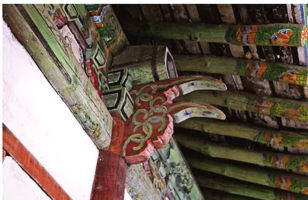
동금강암 뒷면 주상포 / 東金剛庵 後面 柱上包 brackets above backward columns, Tonggümgangam
