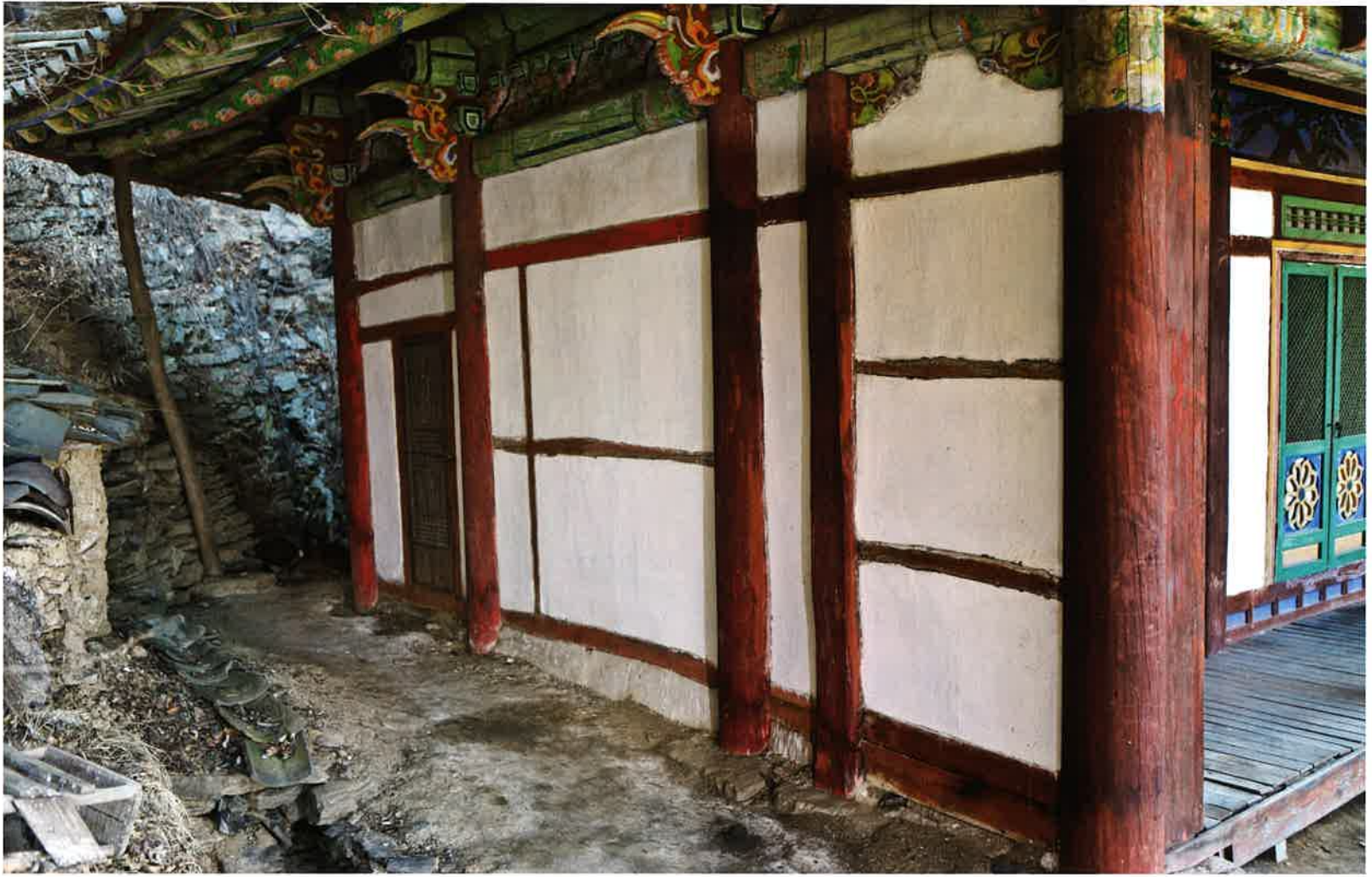
동금강암 서쪽 측면 벽체 / 東金剛庵 西側 壁體 / western wall, Tonggūmgangam
