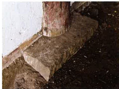
동금강암 동쪽 측면 가운데 기둥 주춧돌 東金剛庵 東側面 平柱 礎石 plinth for eastern side middle column, Tonggümgangam
