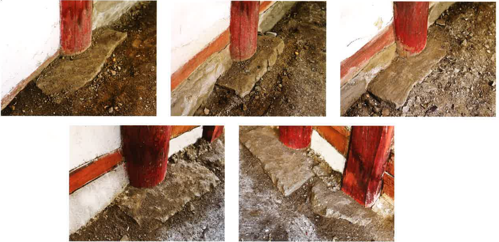
동금강암 뒷면 가운데 기둥 주춧돌 / 東金剛庵 後面 平柱 礎石 / backward middle plinths, Tonggūmgangam
