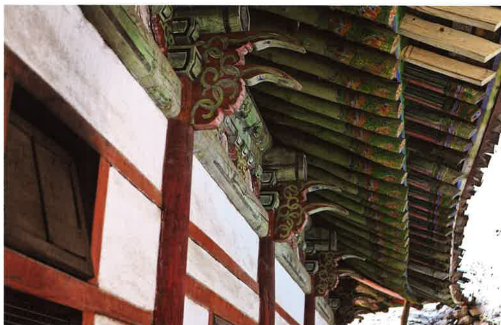
동금강암 뒷면 공포 / 東金剛庵 後面 栱包 backward brackets, Tonggümgangam
