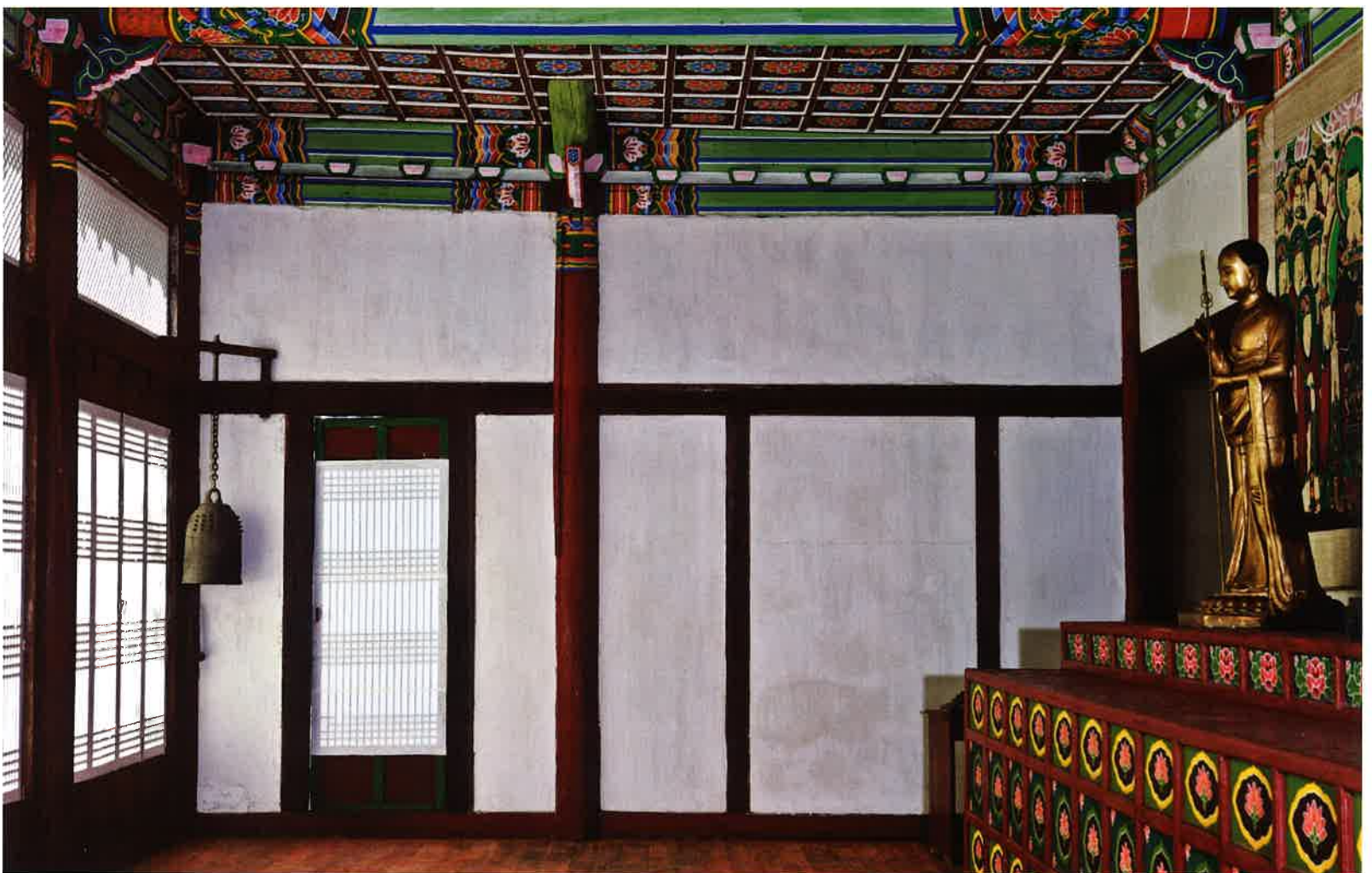
대웅전 내부 서쪽 벽체 / 大雄殿 內部 西側 壁體 / western wall, Taegungjon hall
