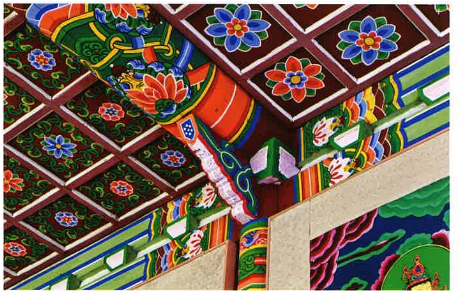
대웅전 내부 동쪽 측면 주상포 / 大雄殿 內部 東側 柱上包 brackets above eastern columns, Taegungjon hall
