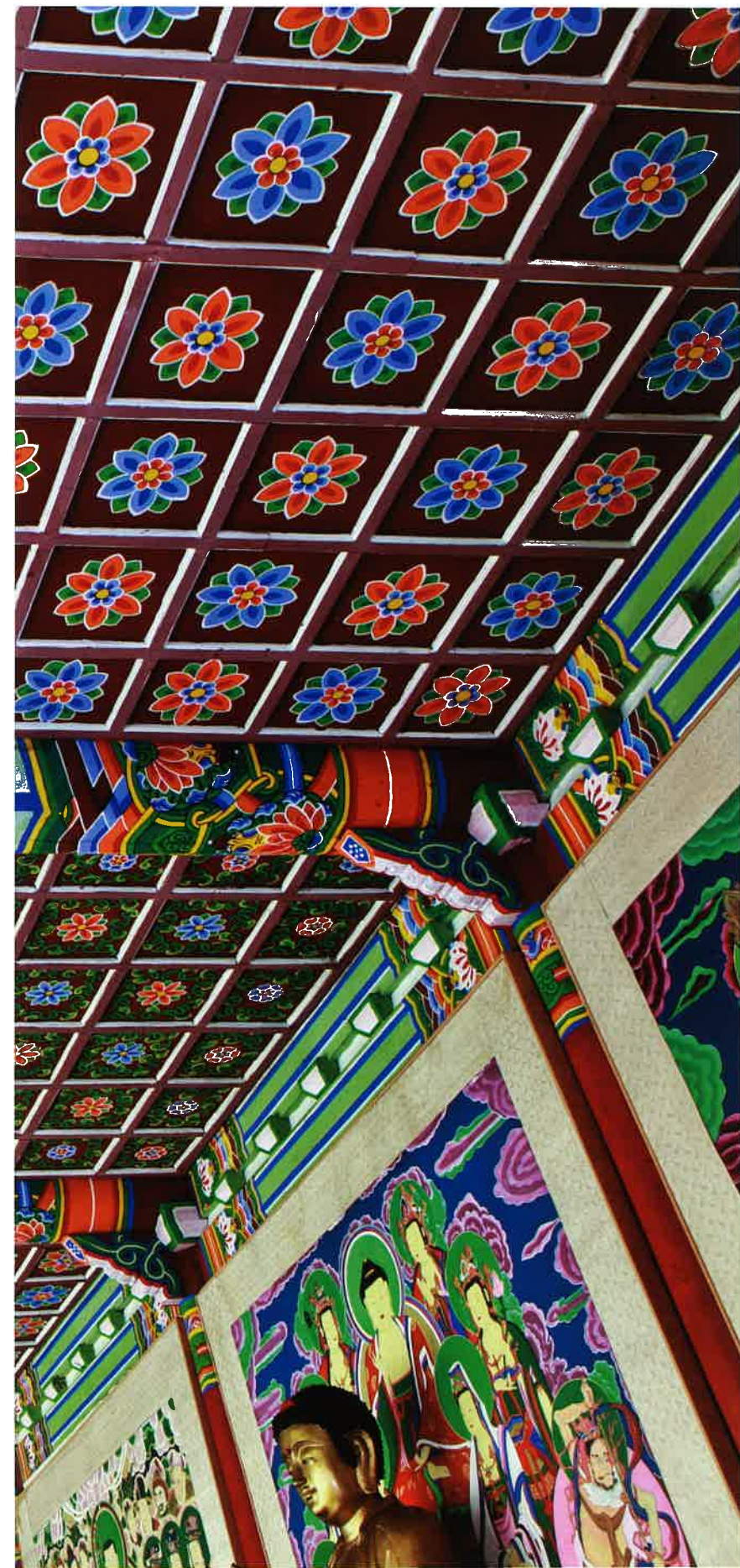
대웅전 내부 우물천장 / 大雄殿 內部 格子天障 / latticed ceiling, Taegungjon hall
