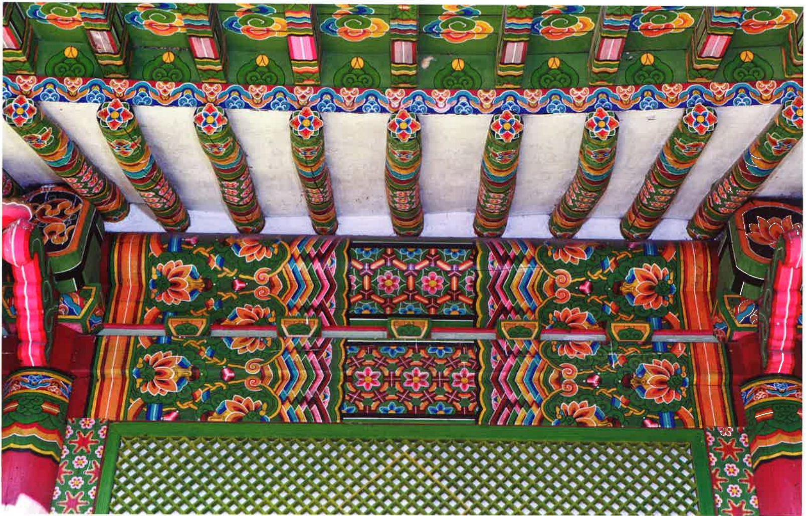
대웅전 앞면 액방과 도리, 장혀 / 大雄殿 前面 額枋·道里·長舌 / front lintel, girder and strip of wood supporting a beam, Taegungjon hall
