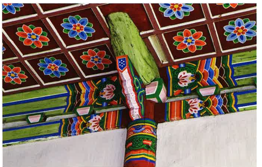
대웅전 내부 서쪽 측면 주상포 / 大雄殿 內部 西側 柱上包 brackets above western columns, Taegungjon hall
