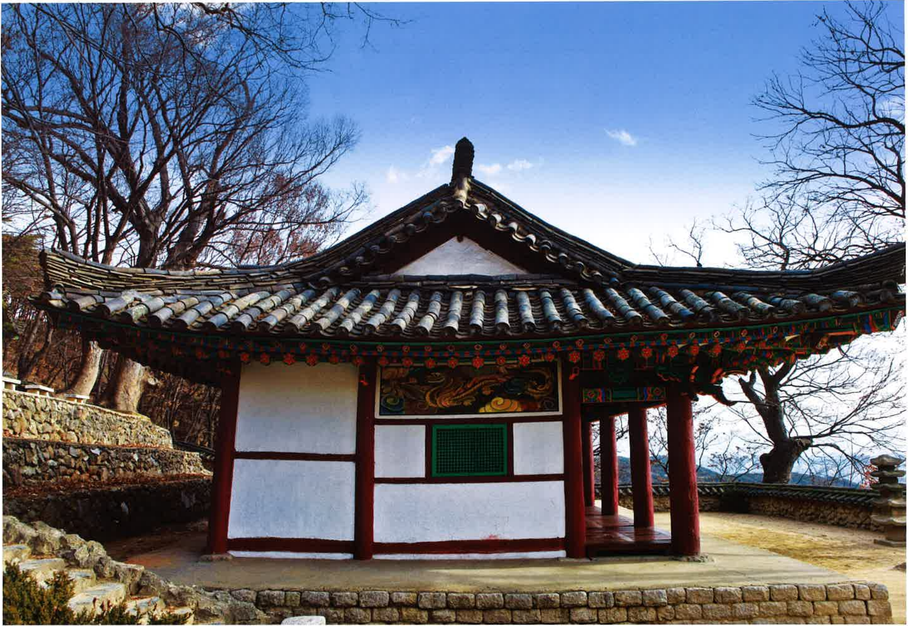
본전 서쪽 측면 / 本殿 西側面 / western side, Pöbunam
