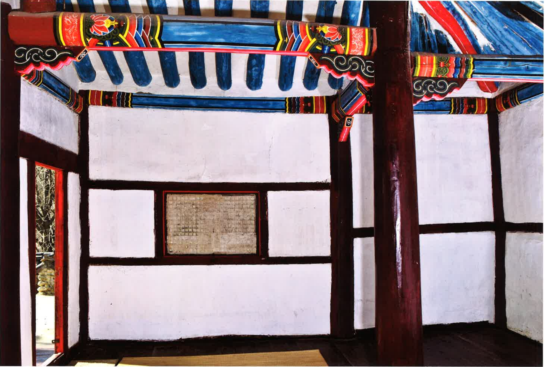
본전 내부 서쪽 벽체 / 本殿 內部 西側 壁體 / inside western wall, Pöbunam
