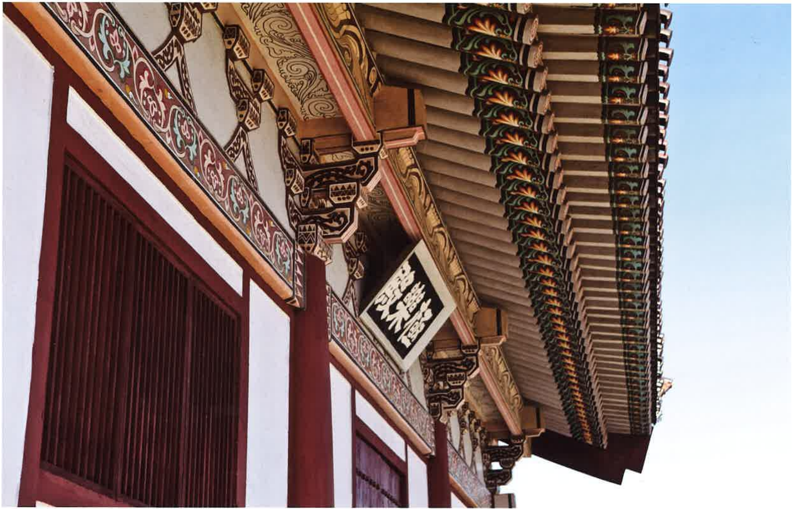
극락전 처마와 공포 / 極樂殿 軒·拱包 / eaves and bracket, Kungnakchön hall
