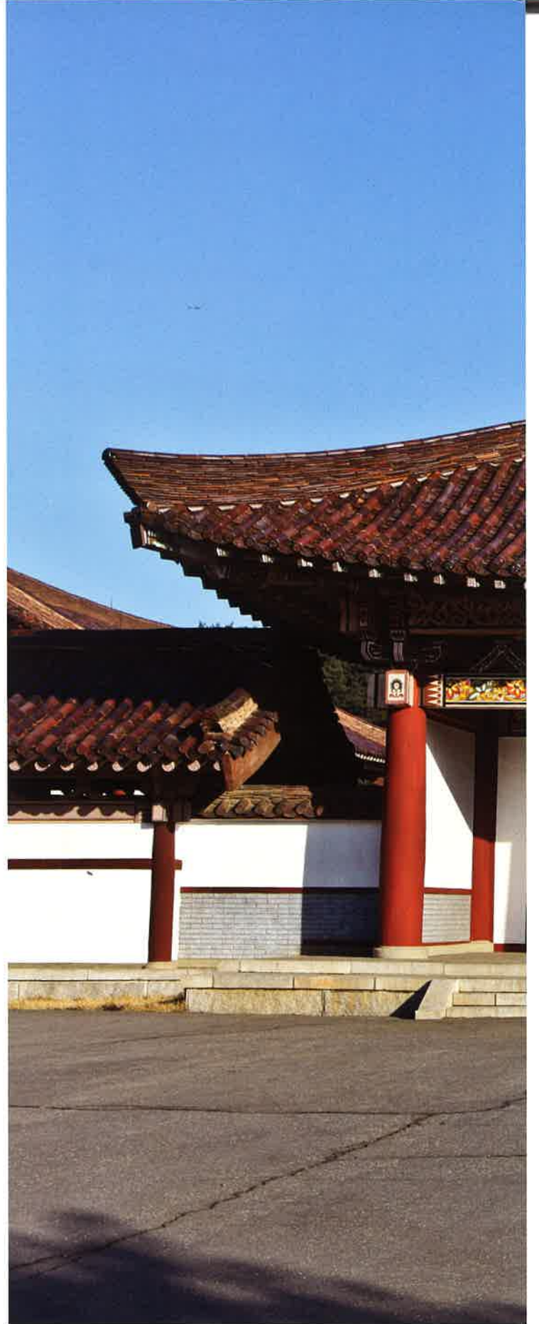
정릉사 중문 / 定陵寺 中門 middle gate, Chōnnūngsa
