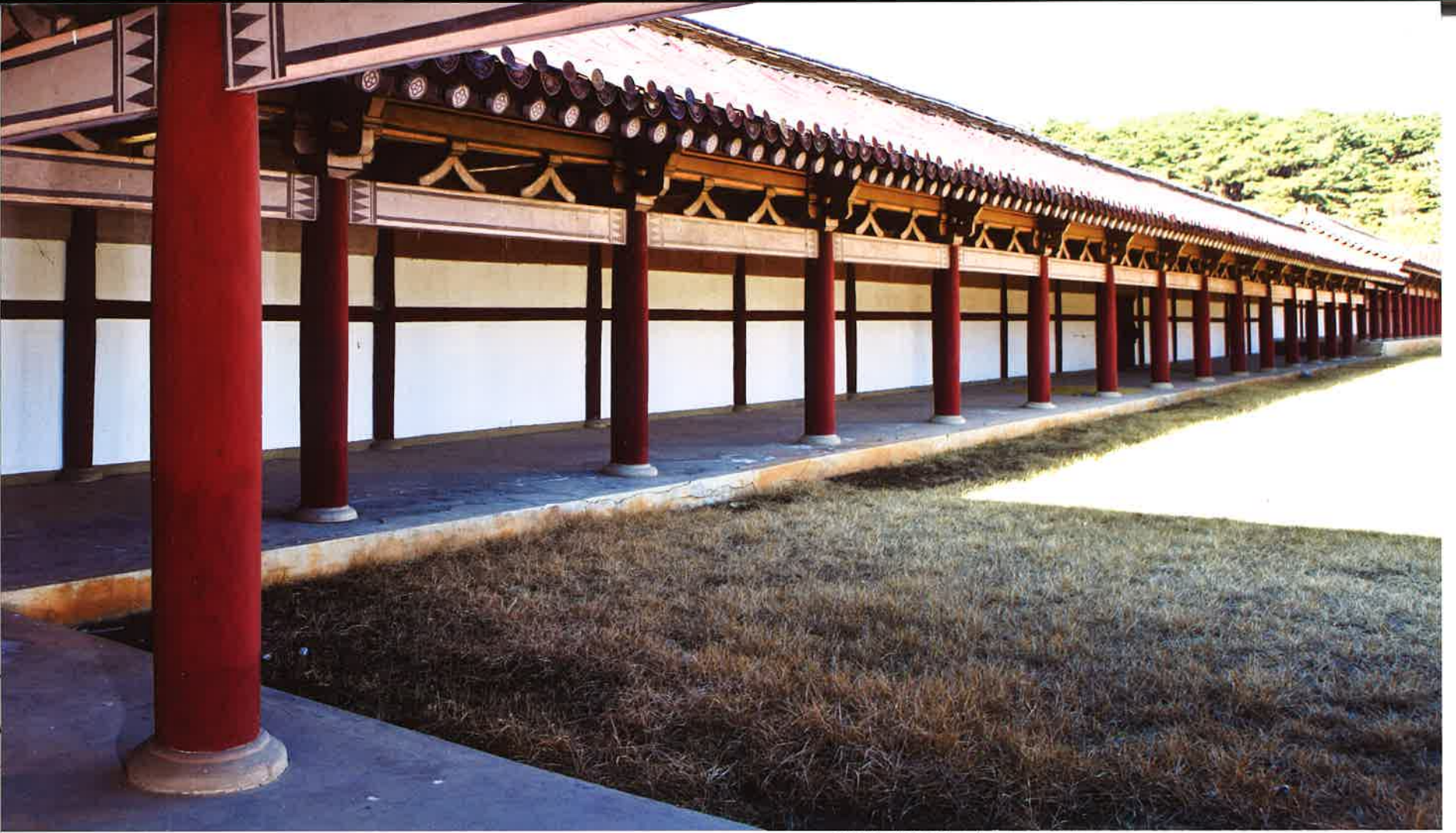
정릉사 뒷면 회랑 / 定陵寺 後面 回廊 / gallery in the backyard, Chönnüngsa.
