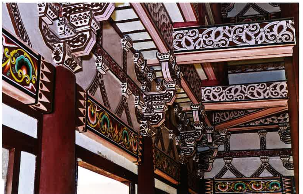
보광전 내부 공포 / 普光殿 內部 棋包 / brackets, Pogwangjŏn hall
