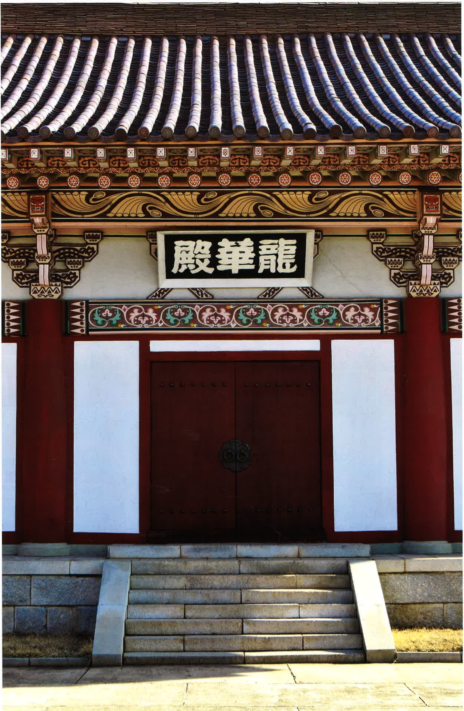
용화전 앞 기단과 계단 / 龍華殿 基壇·階段 / front stairs and stylobate, Yonghwajon hall
