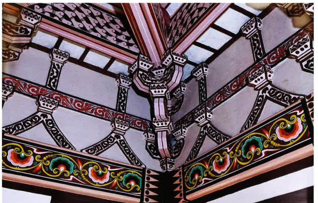
보광전 내부 귀포 / 普光殿 內部 耳包 / corner brackets, Pogwangjŏn hall
