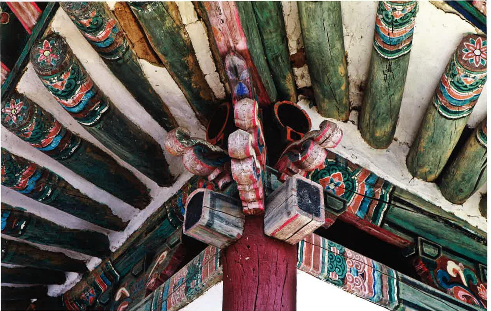
태평루 앞면 서쪽 귀포 / 太平樓 前面 西側 耳包 / western corner brackets, Taep'yongnu
