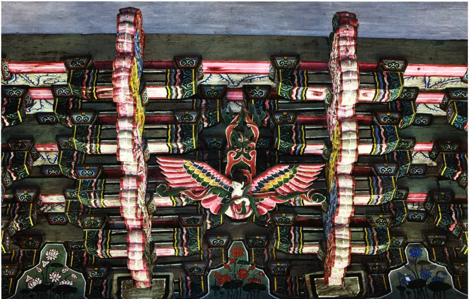
대웅보전 내부 주간포와 가릉빈가 / 大雄寶殿 內部 柱間包·迦陵頻伽 / brackets between columns and Kalavinka, Taeungbojŏn hall
