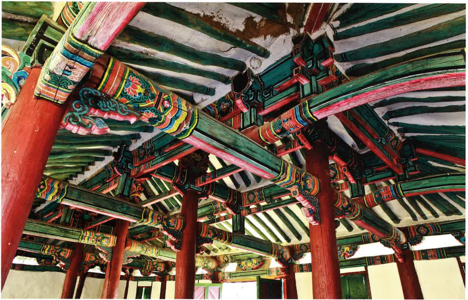
태평루 내부 반자 / 太平樓 內部 天障 / ceiling, T'aep'yŏngnu
