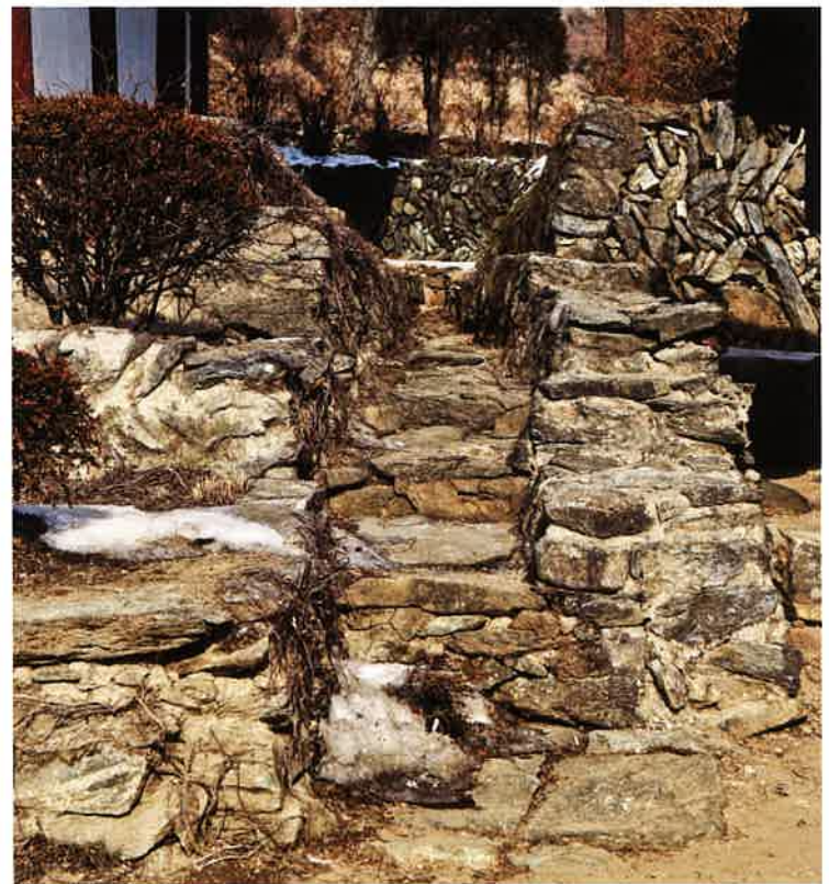
대응보전 동쪽 계단 / 大雄寶殿 東側 階段 / eastern stairs, Taegungbojeon hall
