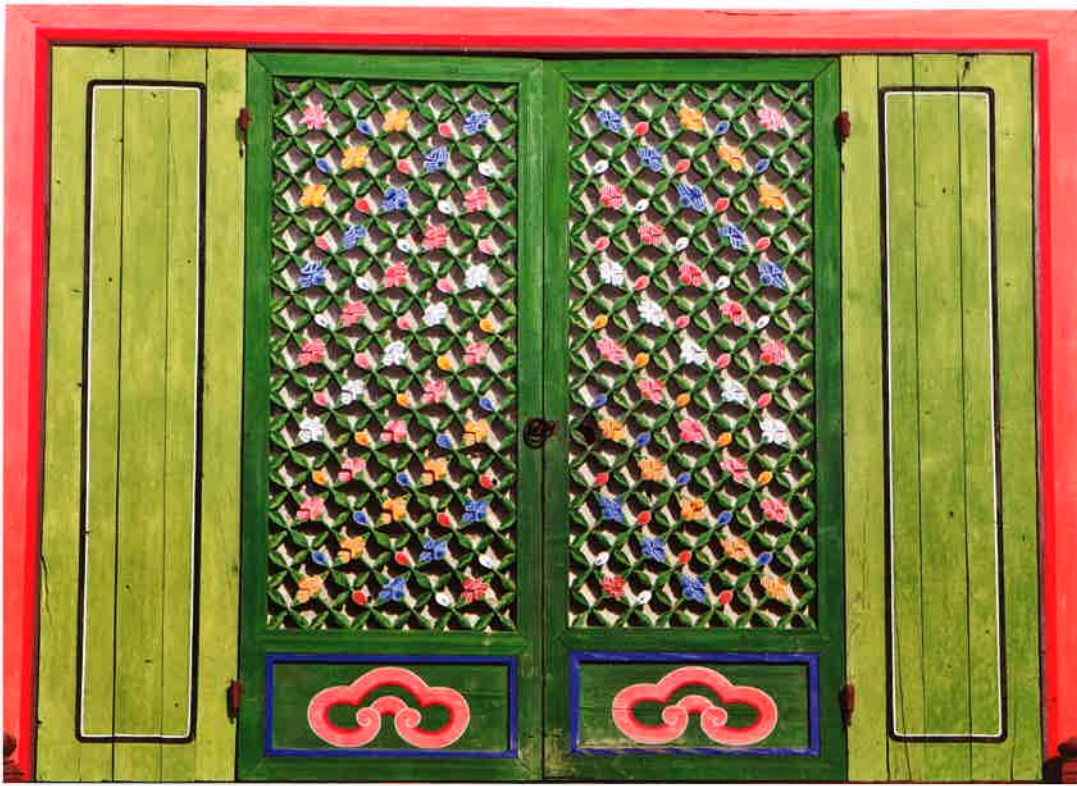
대응보전 정간 창호 / 大雄寶殿 正間 窓戶 middle doors, Taegungbojeon hall
