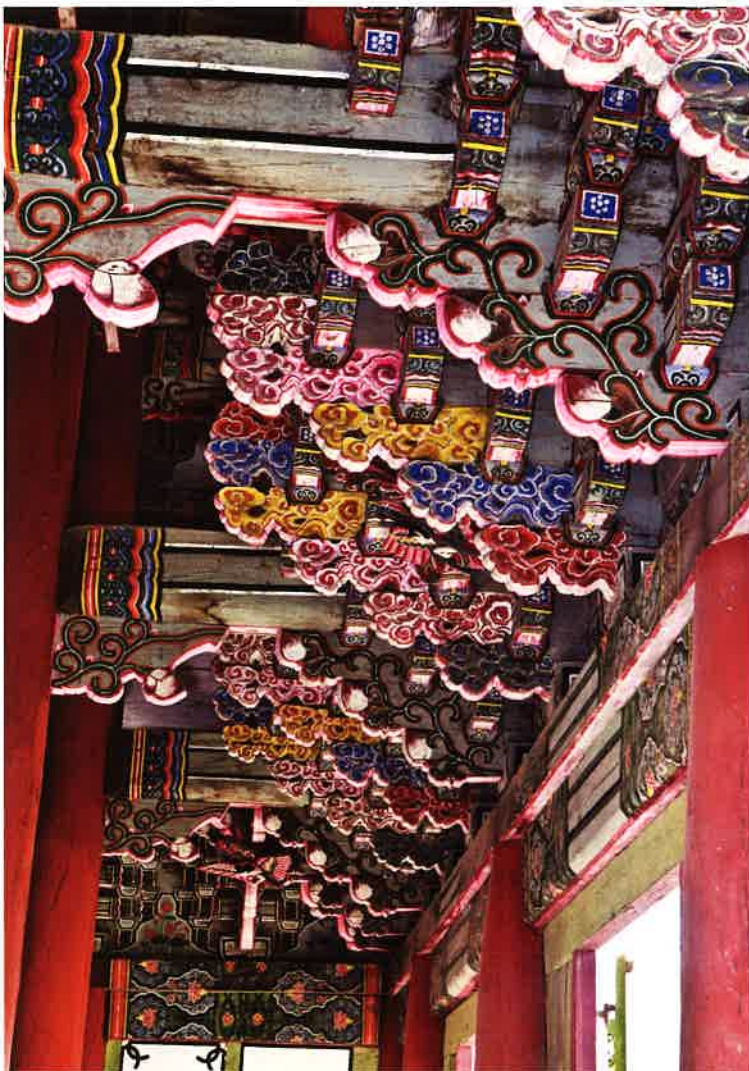
대웅보전 내부 앞면 공포 / 大雄寶殿 內部 前面 棋包 inside front brackets, Taengbojŏn hall
