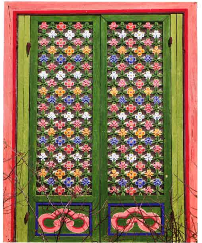
대응보전 서쪽 제2협간 창호 / 大雄寶殿 西側 第2夾間 窓戶 western 2nd doors, Taegungbojeon hall
