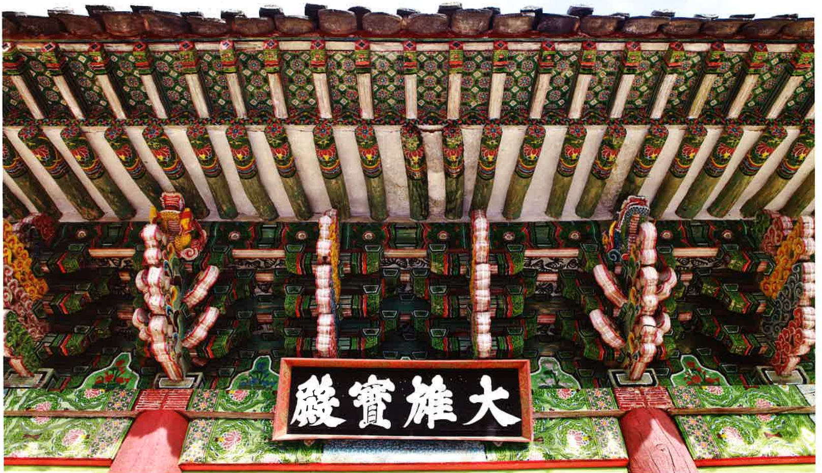
대응보전 전면 처마와 공포 / 大雄寶殿 前面 軒·椽包 / front eaves and brackets, Taegungbojeon hall
