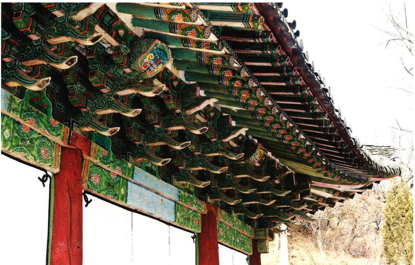
대웅보전 동쪽 측면 처마와 공포 / 大雄寶殿 東側 軒·拱包 / eastern eaves and brackets, Taengbojŏn hall
