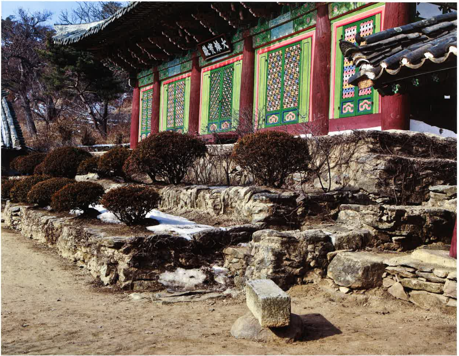
대응보전 앞 기단 / 大雄寶殿 基壇 / front stylobate, Taegungbojeon hall
