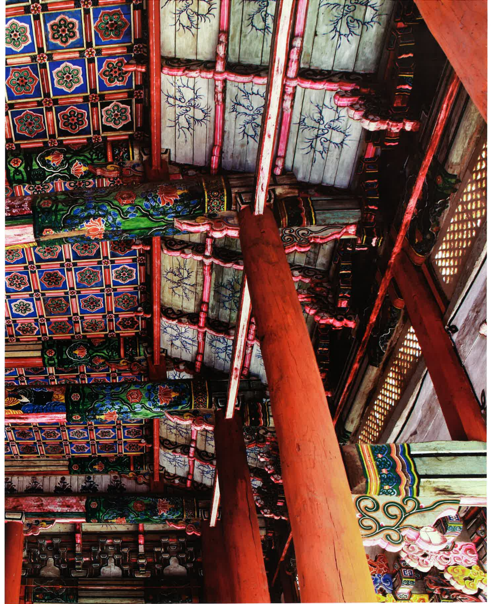
대웅보전 내부 반자 / 大雄寶殿 內部 天障 / ceiling, Taegungbojeon hall
