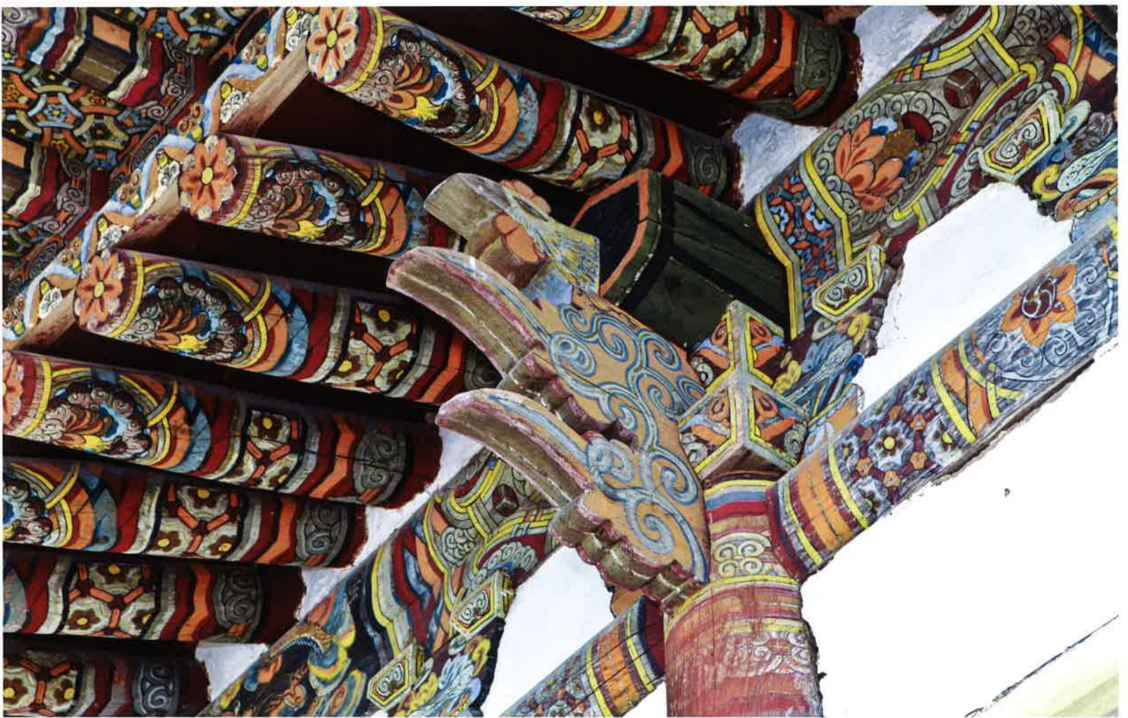
극락전 앞면 주상포 / 極樂殿 前面 柱上包 / brackets above front columns, Kungnakchön hall
