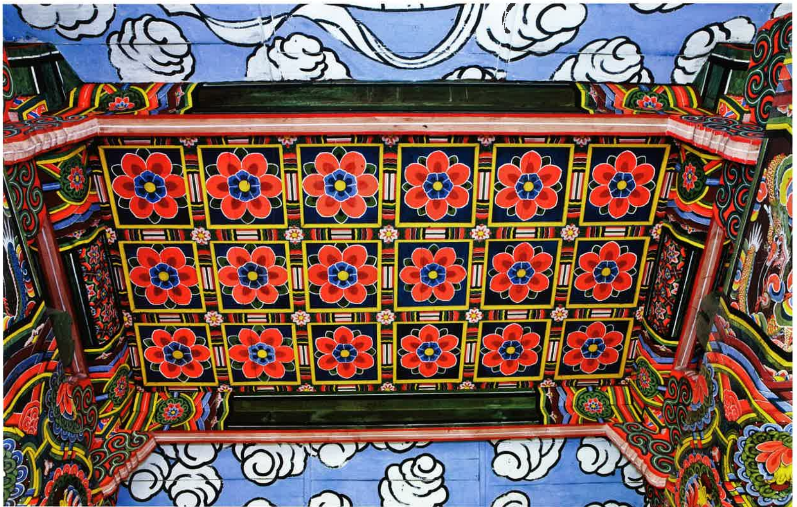
극락전 내부 소란반자 / 極樂殿 內部 格子天障 / latticed ceiling, Kungnakchön hall
