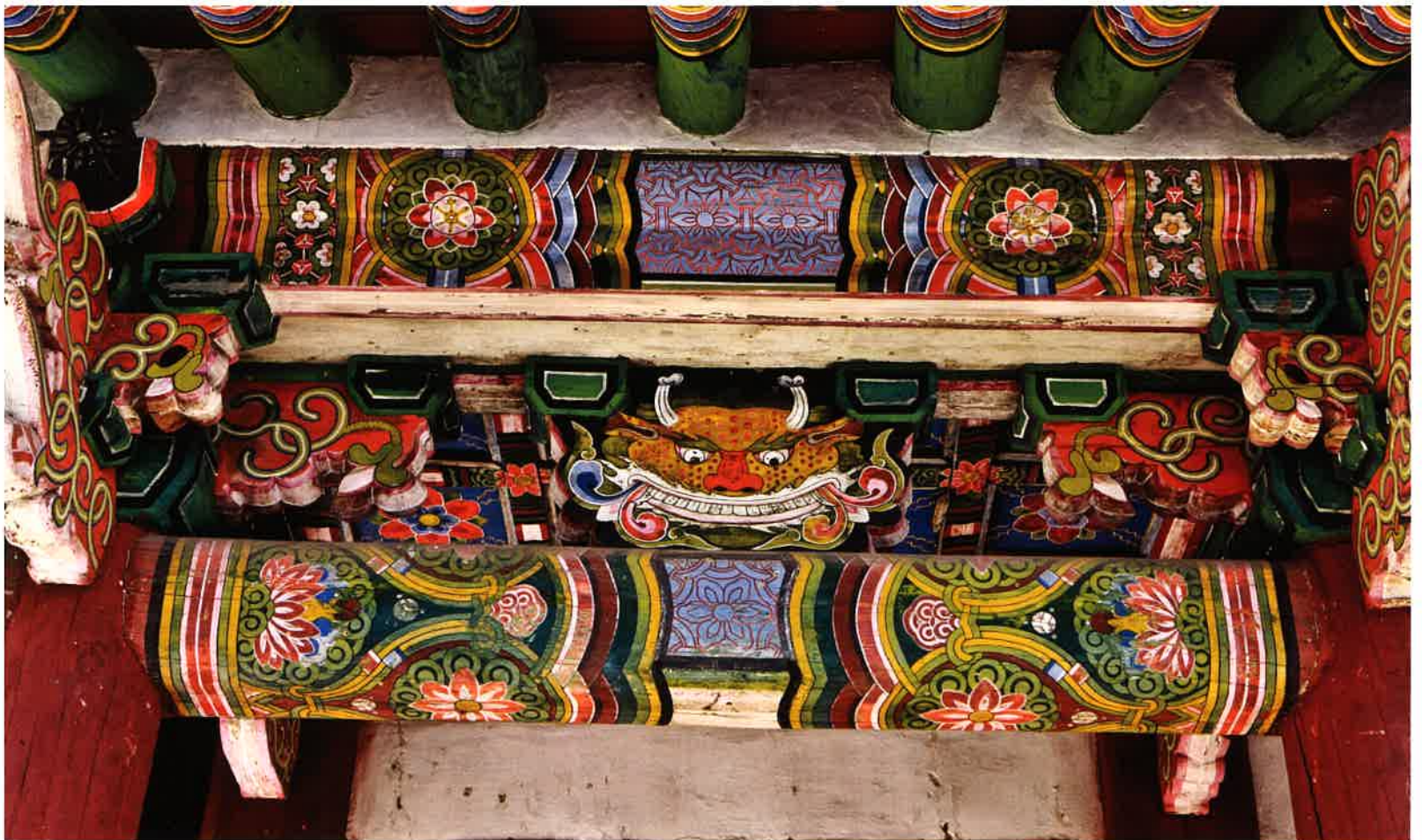
삼화상각 앞면 액방 / 三和尚閣 前面 額枋 / front lintel, Samhwasanggak shrine
