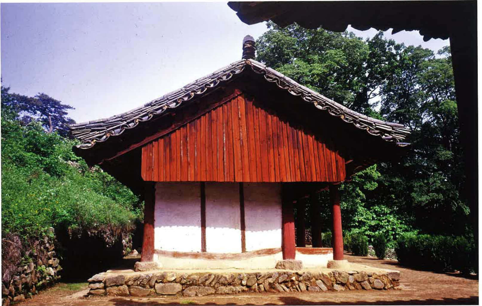
삼화상각 서쪽 측면 기단 / 三和尚閣 西側 基壇 / western stylobate, Samhwasanggak shrine
