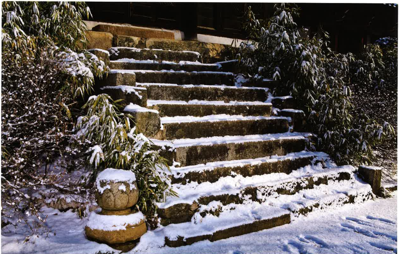
극락전 앞 기단과 계단 / 極樂殿 前面 基壇·階段 / front stylobate and stairs, Küngnakchön hall
