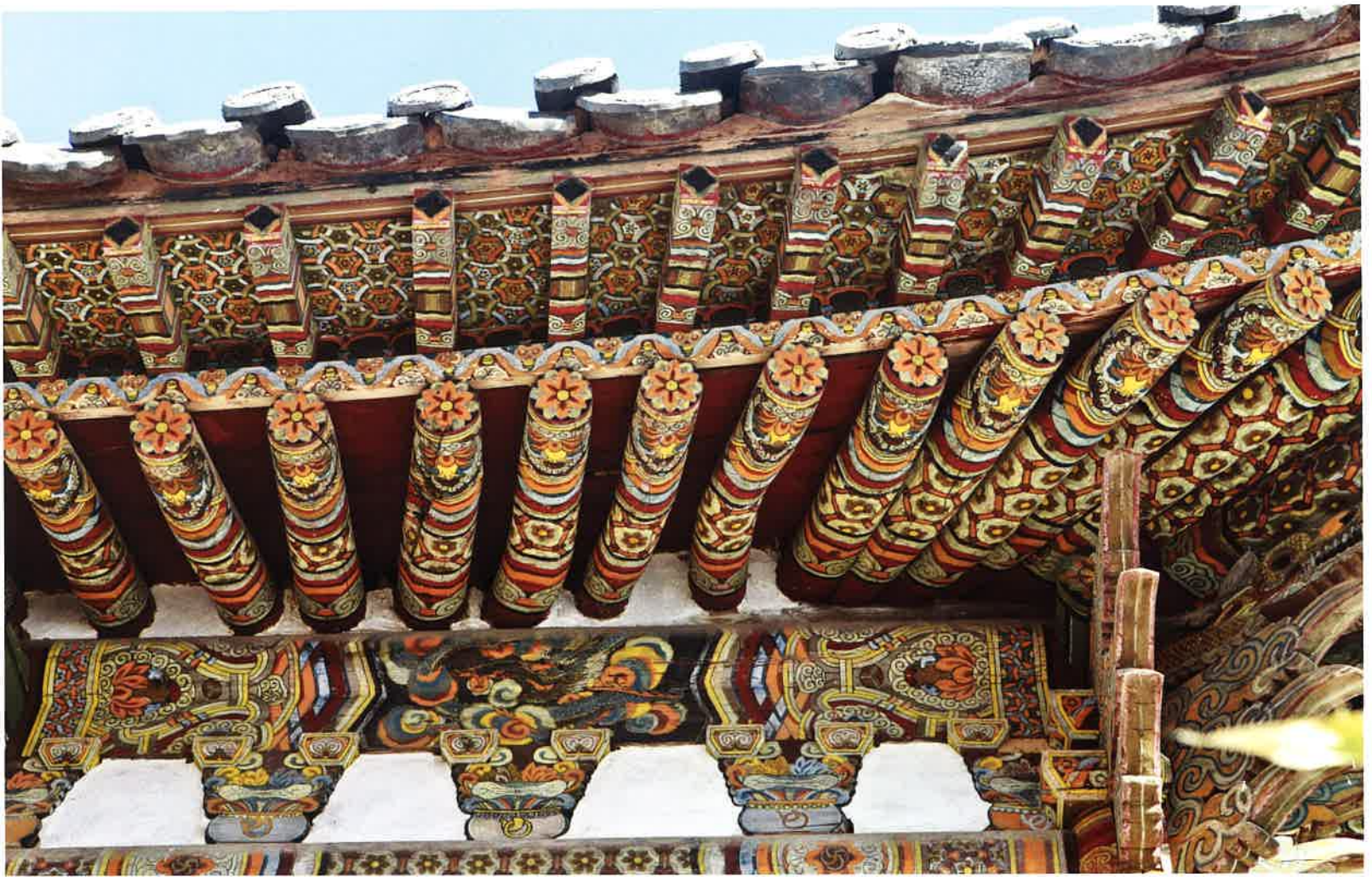
극락전 앞면 공포와 부연 / 極樂殿 前面 棋包·附椽 / front brackets and flying rafter, Kungnakchön hall
