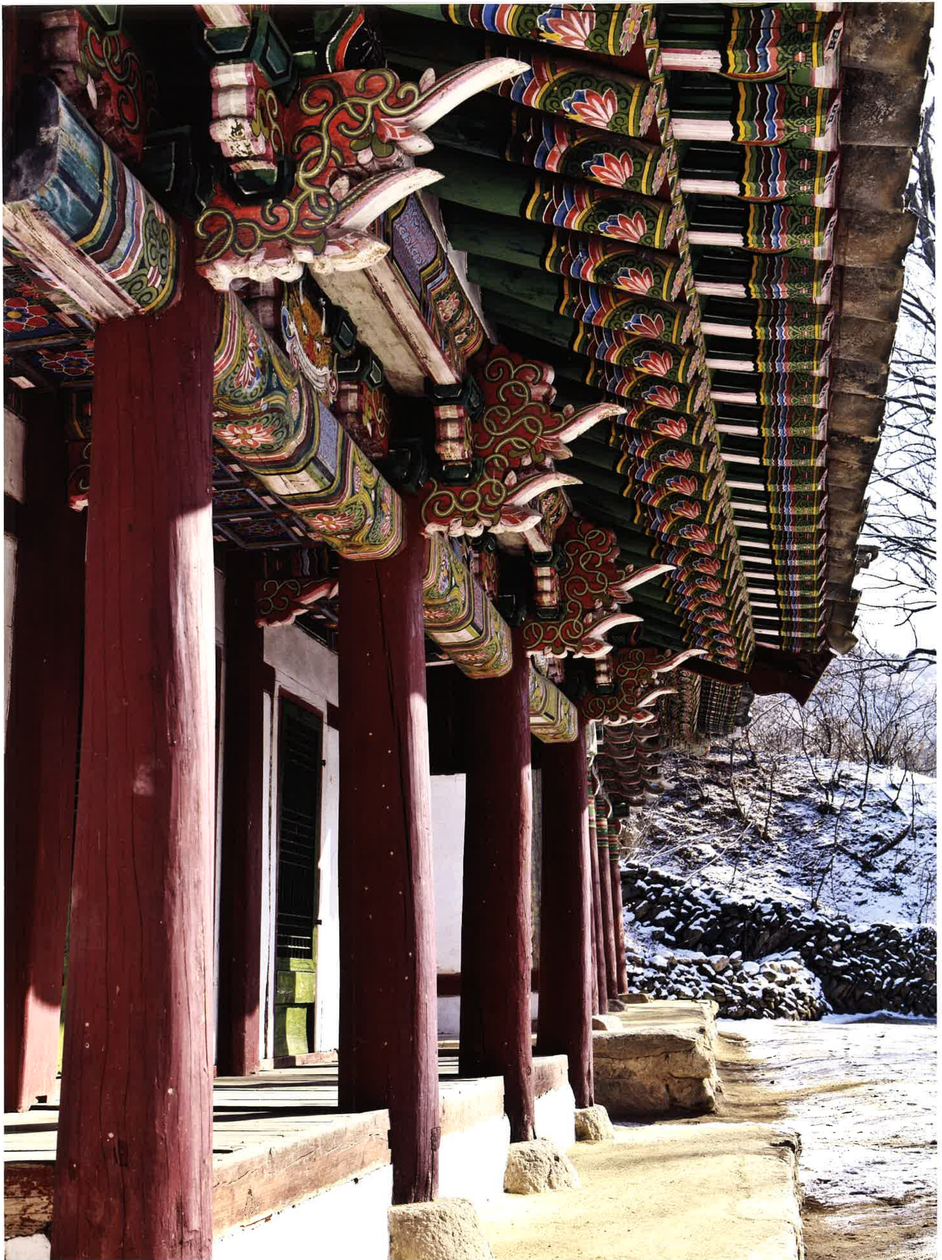
삼화상각 앞면 기둥과 공포 / 三和尚閣 前面 平柱·拱包 / front columns and brackets, Samhwasangak shrine
