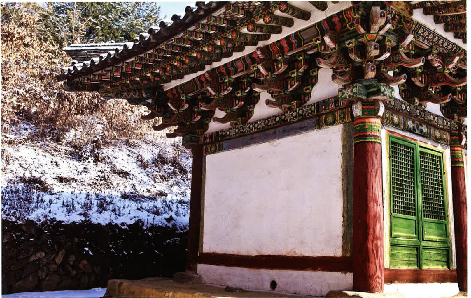
장경각 서쪽 벽체 / 藏經閣 西側 壁體 / western wall, Changgyonggak hall
