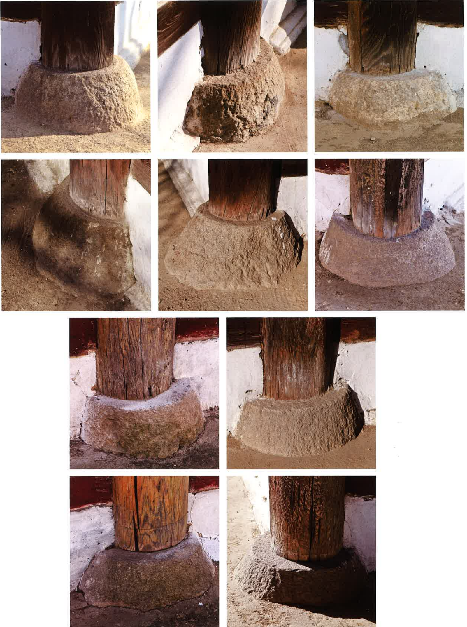
극락전 주춧돌 / 極樂殿 礎石 / plinths, Kūngnakchón hall
