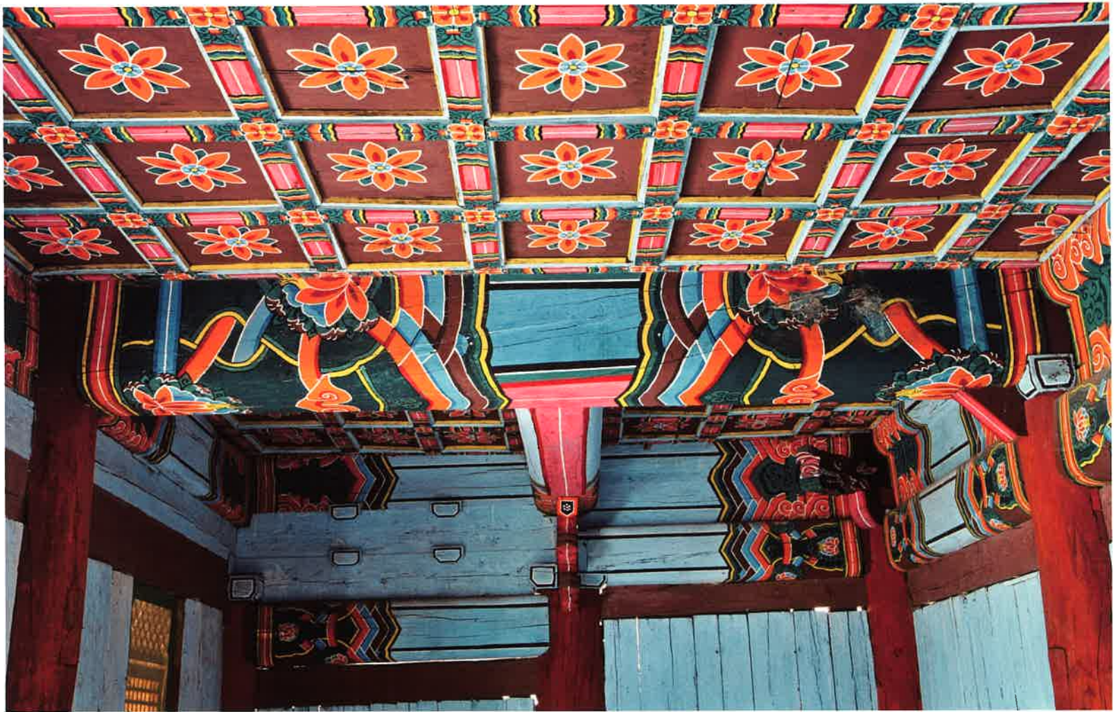
대웅전 대들보와 소란반자 / 大雄殿 大樑·格子天障 / main beam and latticed ceiling, Tacungjön hall
