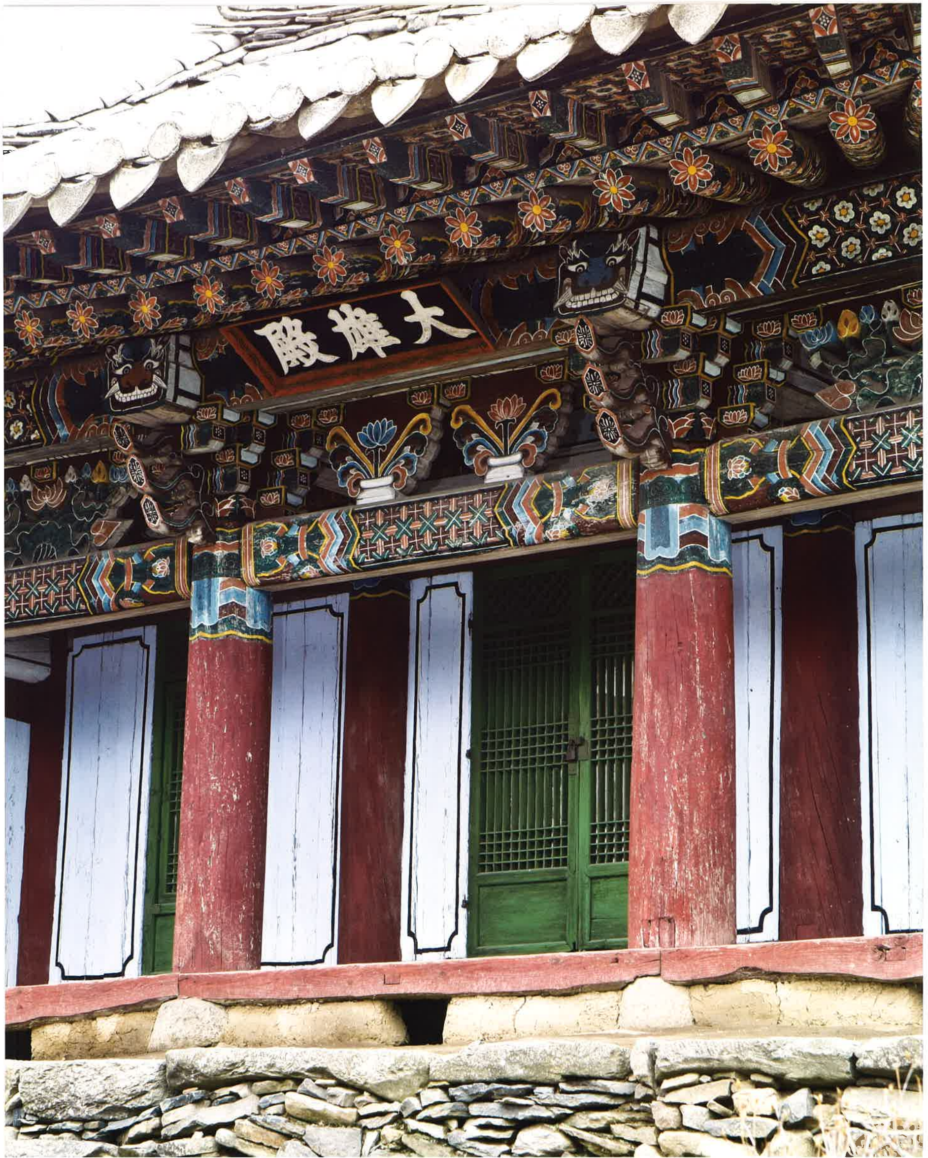
대웅전 앞면 / 大雄殿 前面 / front, Taengjŏn hall
