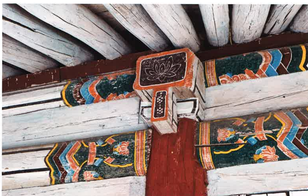
대웅전 뒷면 주상포 / 大雄殿 後面 柱上包 / brackets above backward columns, Taegungjón hall
