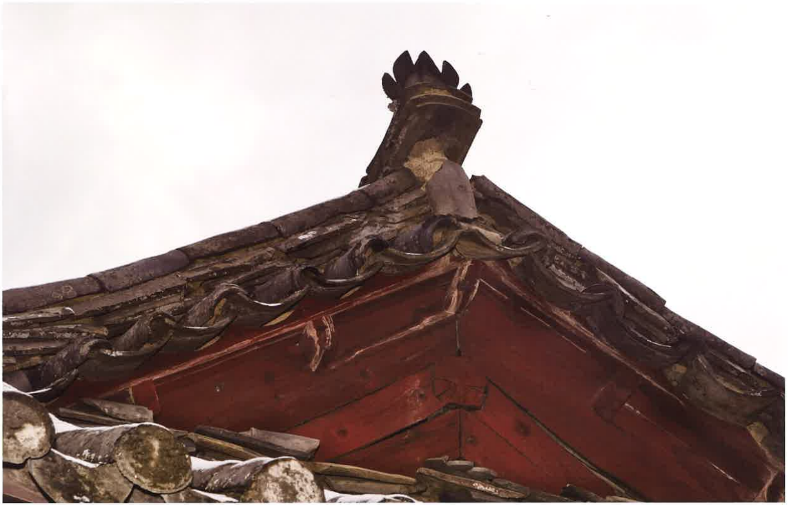
대웅전 동쪽 측면 박공 / 大雄殿 東側 朴工 / eastern gable, Taeungjŏn hall
