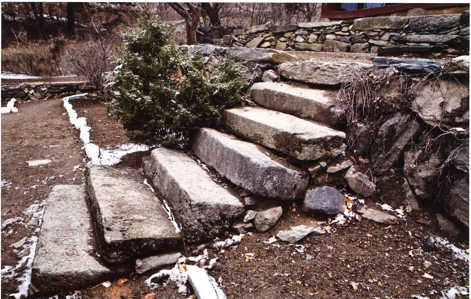
대웅전 동쪽 계단 / 大雄殿 東側 階段 / eastern stairs, Taeungjön hall
