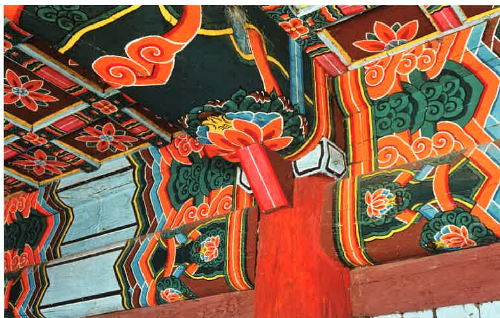
대웅전 내부 뒷면 대들보와 도리 / 大雄殿 內部 後面 大樑·道里 backward main beam and girder, Taeungjön hall
