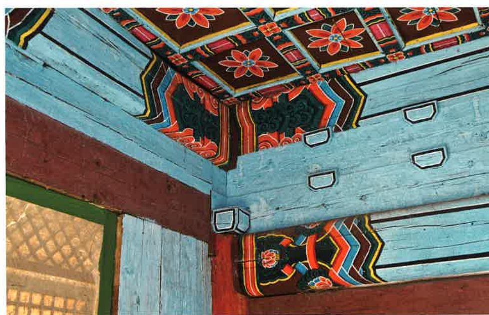
대웅전 내부 앞면 도리와 장혀 / 大雄殿 內部 前面 道里·長舌 front girder, strip of wood supporting a beam, Taeungjön hall
