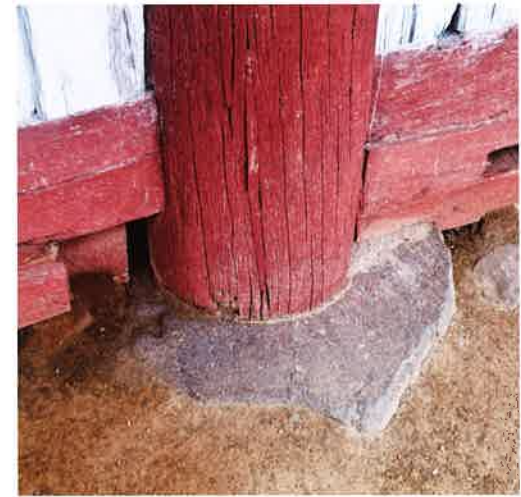
대웅전 주춧돌 / 大雄殿 礎石 / plinths, Taegungjon hall
