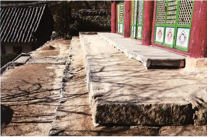
보광전 앞면 마루와 기단 / 普光殿 前面 扶樓·基壇 / front floor and stylobate, Pogwangjŏn hall
