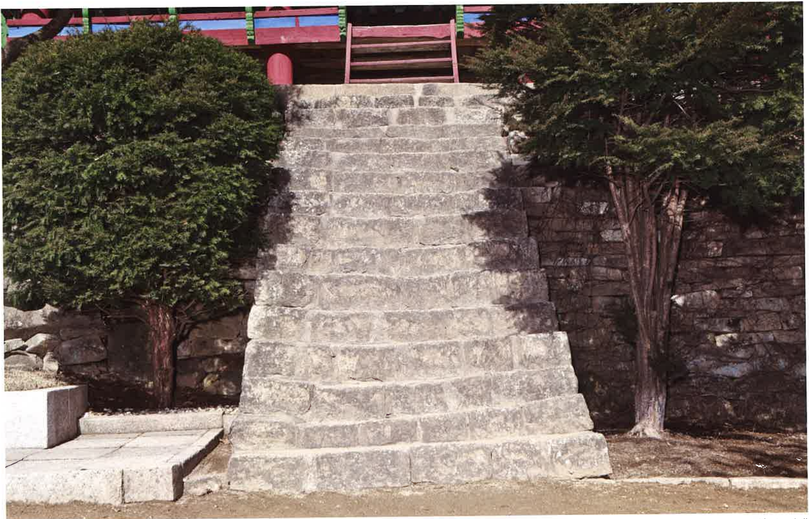
천주루 계단 / 天柱樓 階段 / stairs of Mangwŏltae, Ch'ŏnju hall
