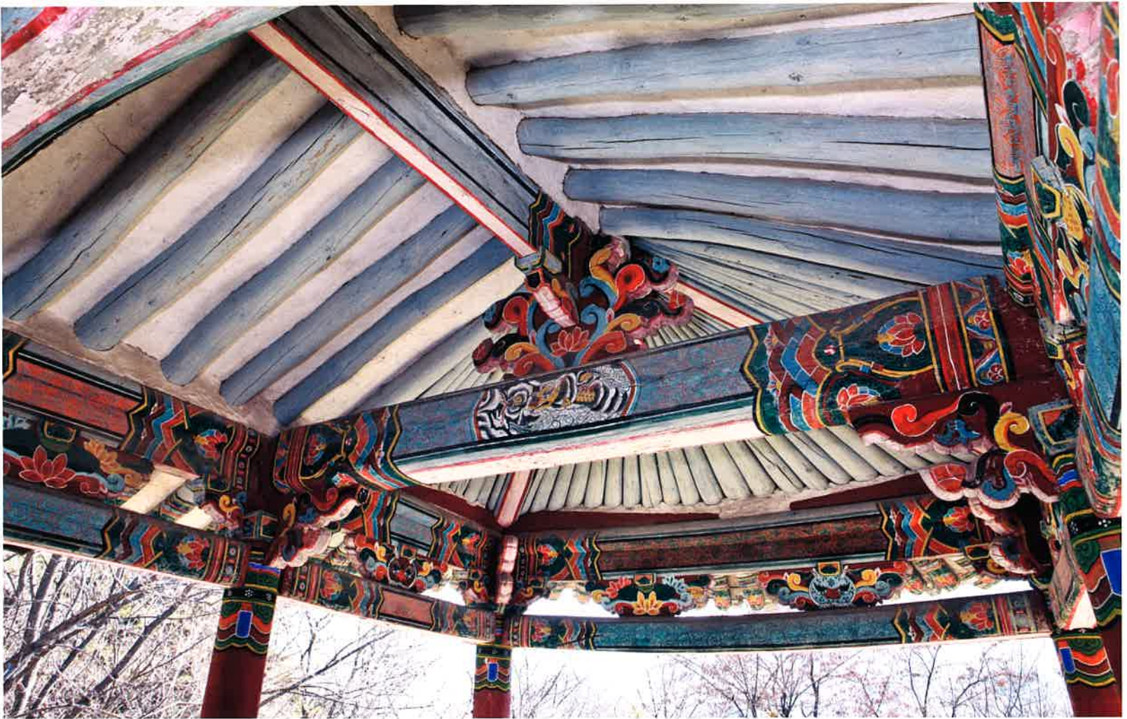
천주루 향일헌 내부 반자 / 天柱樓 向日軒 內部 天障 / ceiling of Hyangilhön, Ch'önjuru hall
