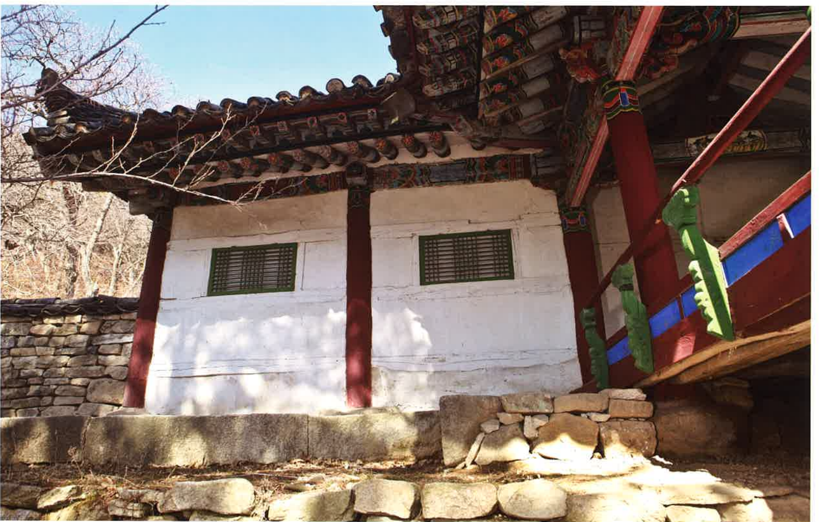
천주루 망월대 귀포 / 天柱樓 望月臺 耳包 / corner brackets of Mangwoltae, Ch'önjuru hall
