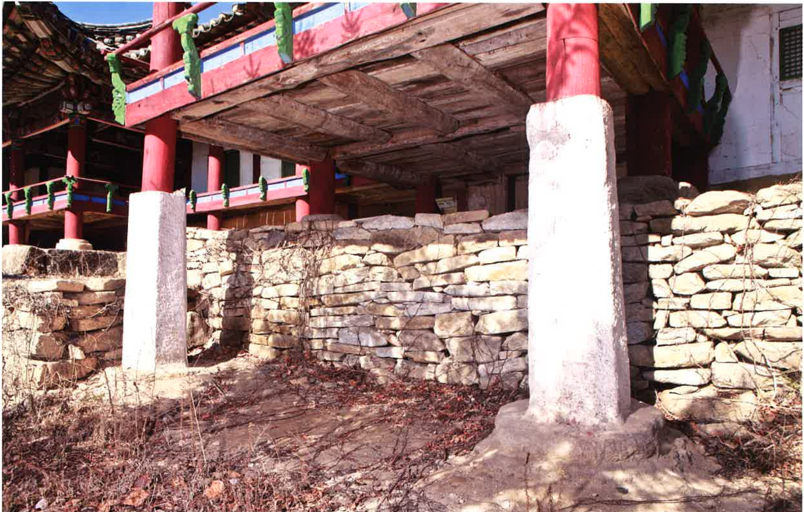
천주루 향일헌 기둥과 기단 / 天柱樓 向日軒 櫻柱·基壇 / columns and stylobate of Hyangilhon, Ch'onjuru hall
