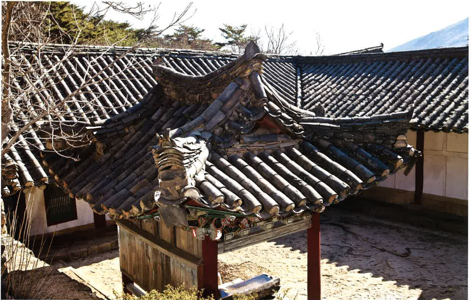
천주사 수각 지붕 / 天柱寺 水閣 屋蓋 / roof of pavilion on water, Ch'ŏnjesa
