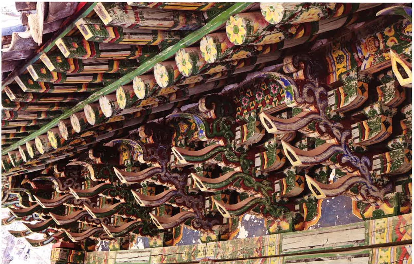
보광전 뒷면 공포 / 普光殿 後面 栱包 / backward brackets, Pogwangjŏn hall
