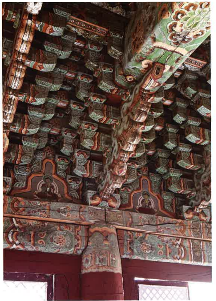
보광전 내부 앞면 주상포 / 普光殿 内部 前面 柱上包 brackets above front columns, Pogwangjŏn hall
