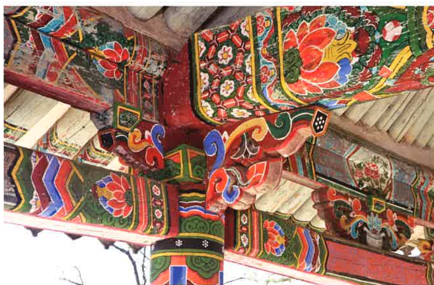
천주루 내부 대들보와 주상포 / 天柱樓 內部 大樑·柱上包 main beam and brackets above columns, Ch'ŏnjuru hall
