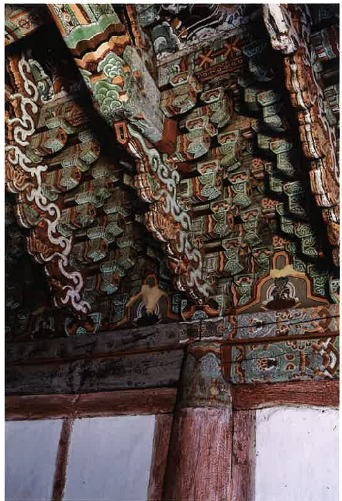
보광전 내부 동쪽 측면 주상포 / 普光殿 內部 東側 柱上包 brackets above eastern columns, Pogwangjŏn hall
