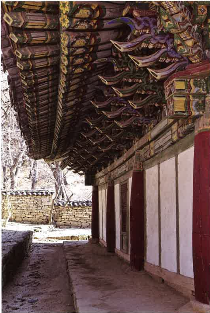
보광전 뒷면 처마와 공포 / 普光殿 後面 軒·栱包 backward eaves and brackets, Pogwangjŏn hall
