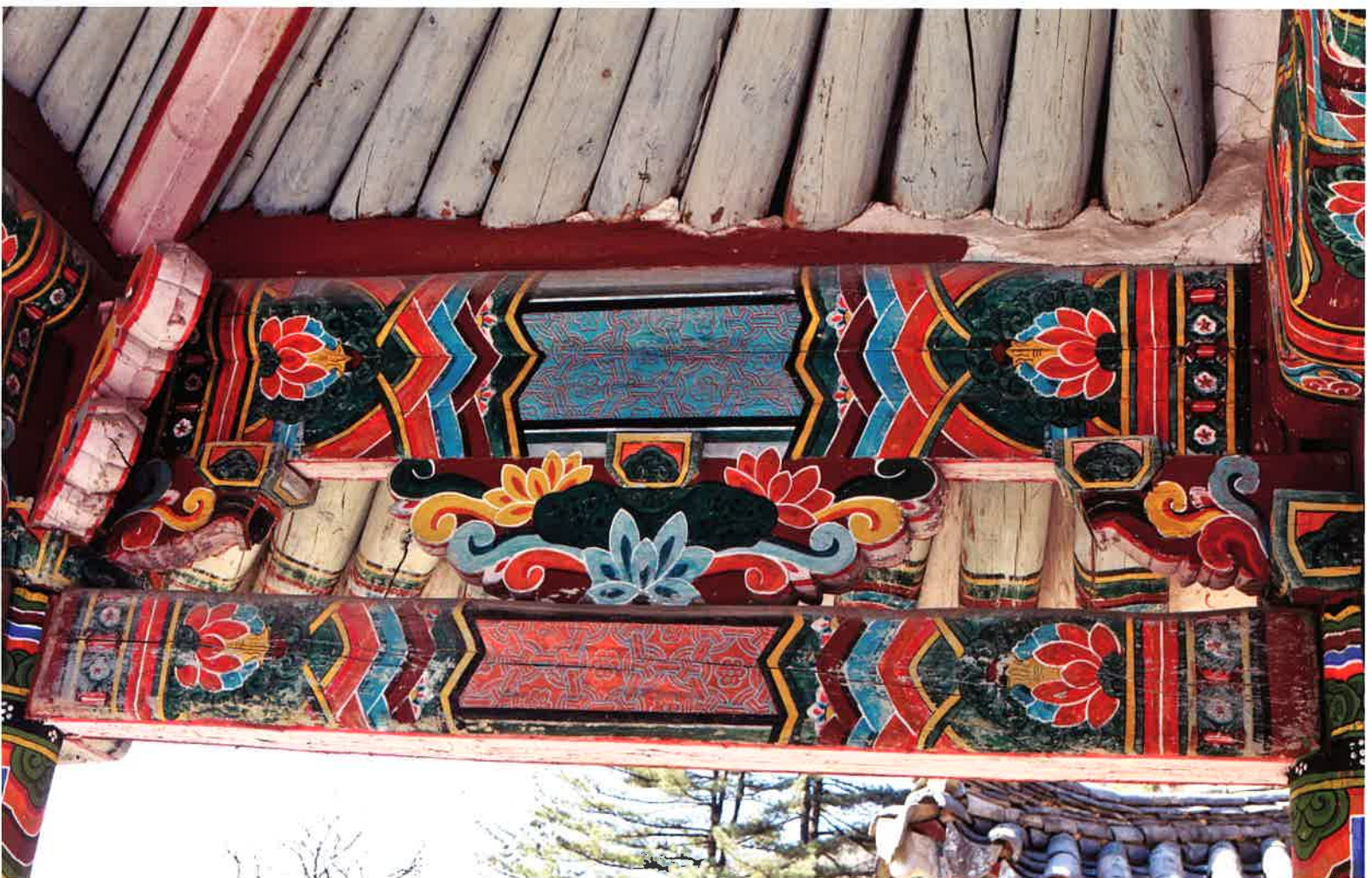
천주루 향일헌 내부 대들보와 도리 / 天柱樓 向日軒 內部 大樑·道里 / main beam and girder of Hyangilhon, Ch'onjuru hall
