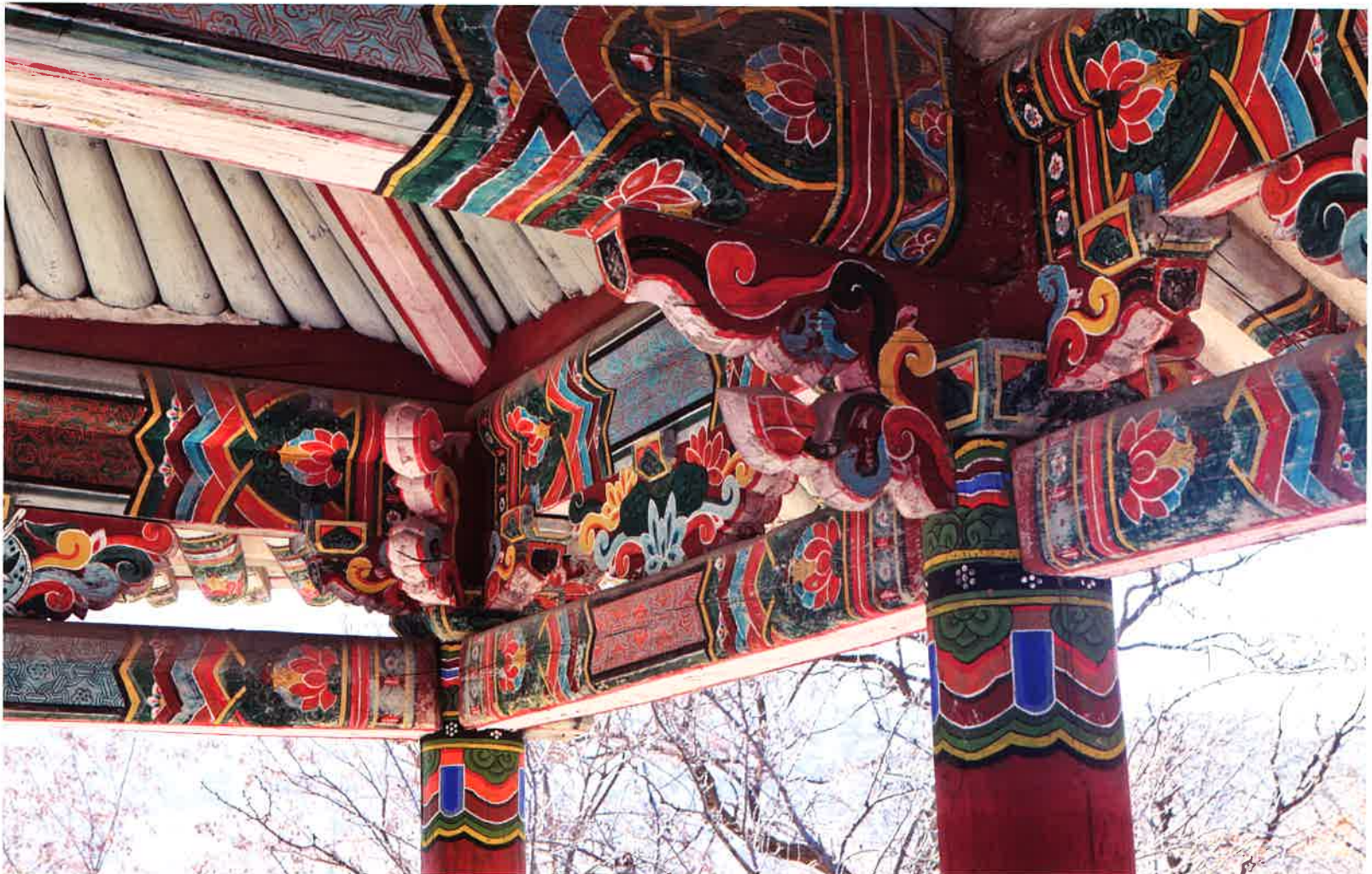
천주루 향일헌 내부 공포 / 天柱樓 向日軒 內部 拱包 / brackets of Hyangilhon, Ch'onjuru hall
