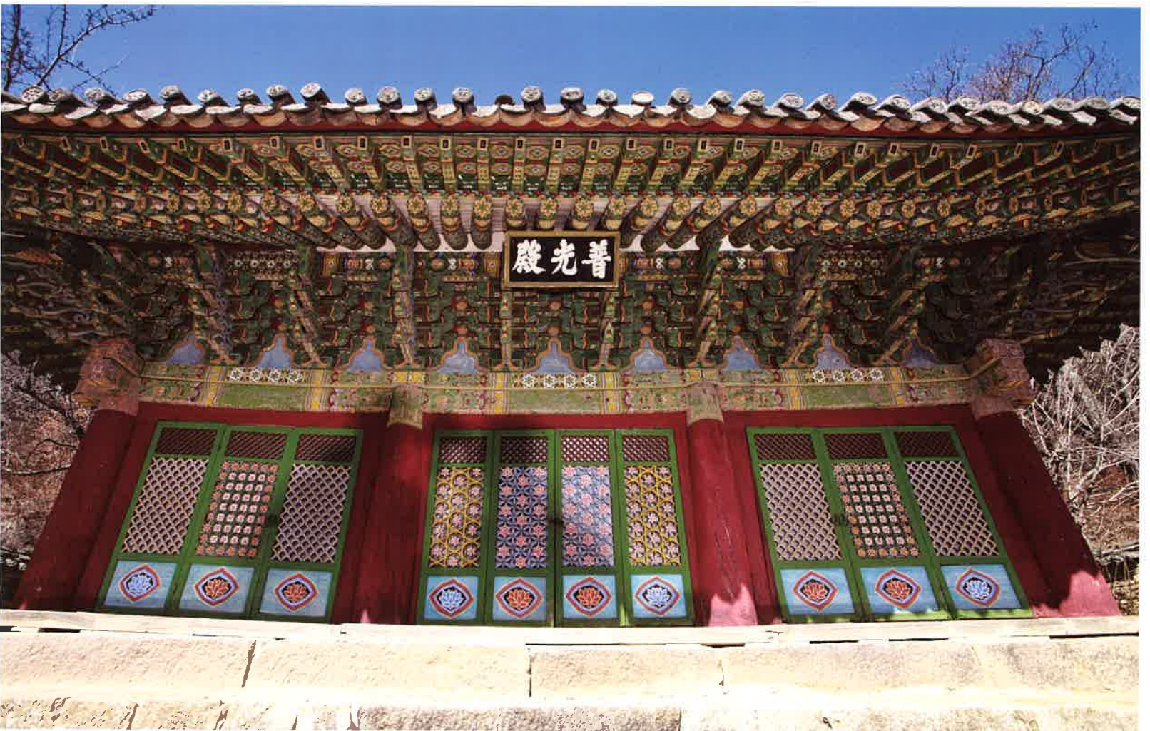
보광전 앞면 처마와 공포 / 普光殿 前面 軒·拱包 / front eaves and brackets, Pogwangjŏn hall
