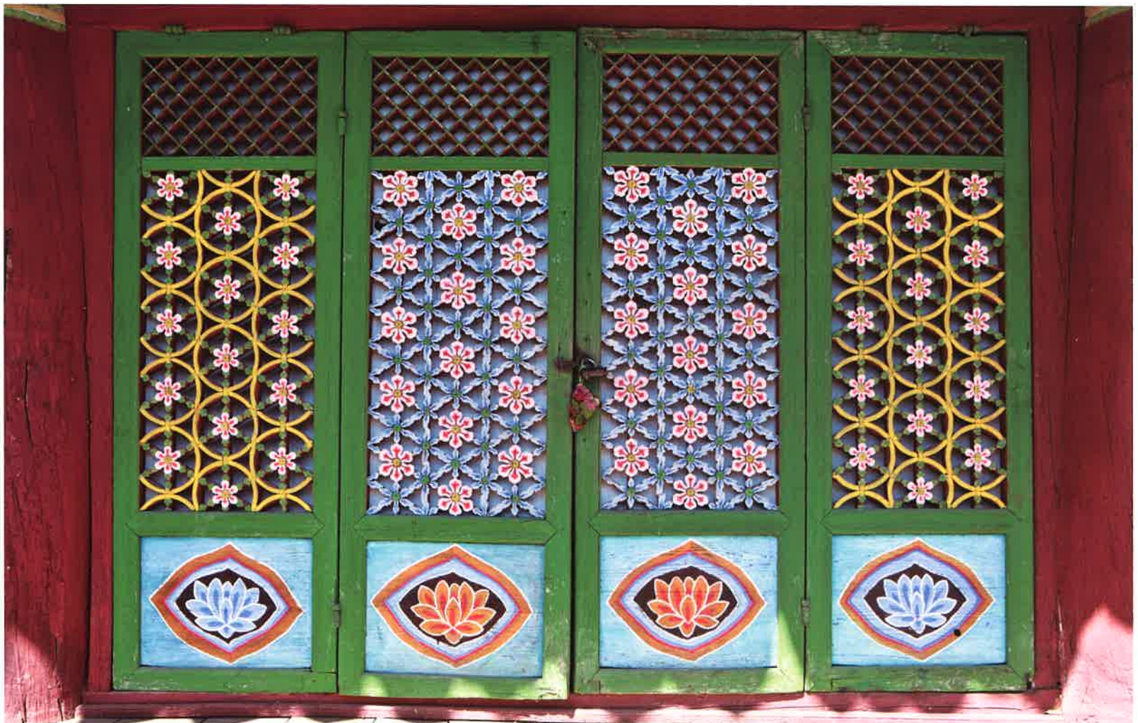
보광전 앞면 정간 창호 / 普光殿 前面 正間 窓戶 / front middle doors, Pogwangjŏn hall
