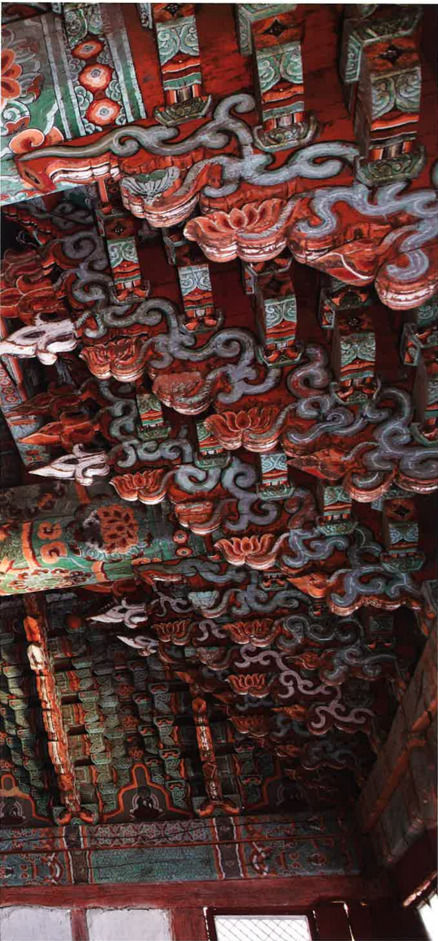
보광전 내부 반자 / 普光殿 內部 天障 / ceiling, Pogwangjŏn hall
