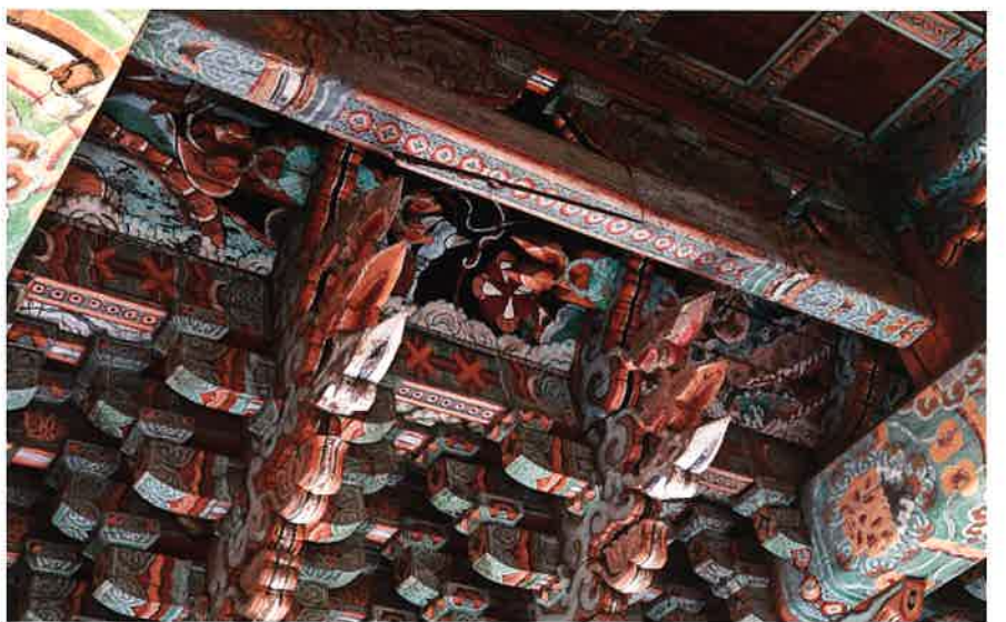
보광전 내부 동쪽 측면 주간포 / 普光殿 內部 東側 柱間包 brackets between eastern columns, Pogwangjŏn hall
