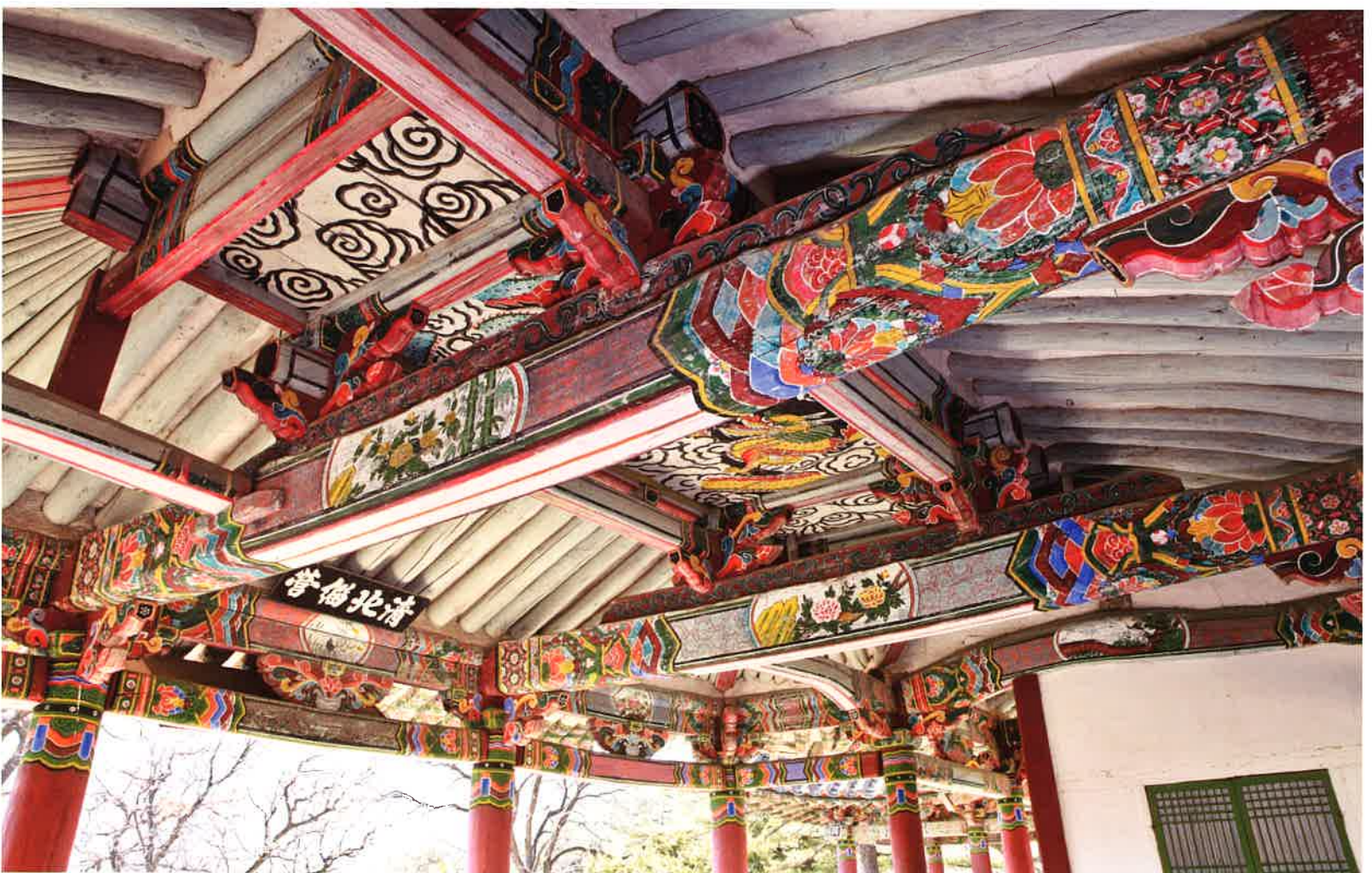
천주루 내부 대들보 / 天柱樓 內部 大樑 / main beam, Ch'önjuru hall
