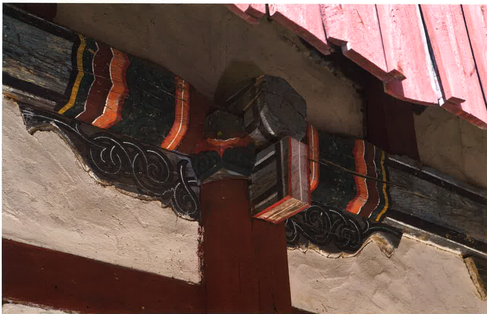
본전 동쪽 측면 주상포 / 本殿 東側 柱上包 / brackets above eastern columns, main hall
