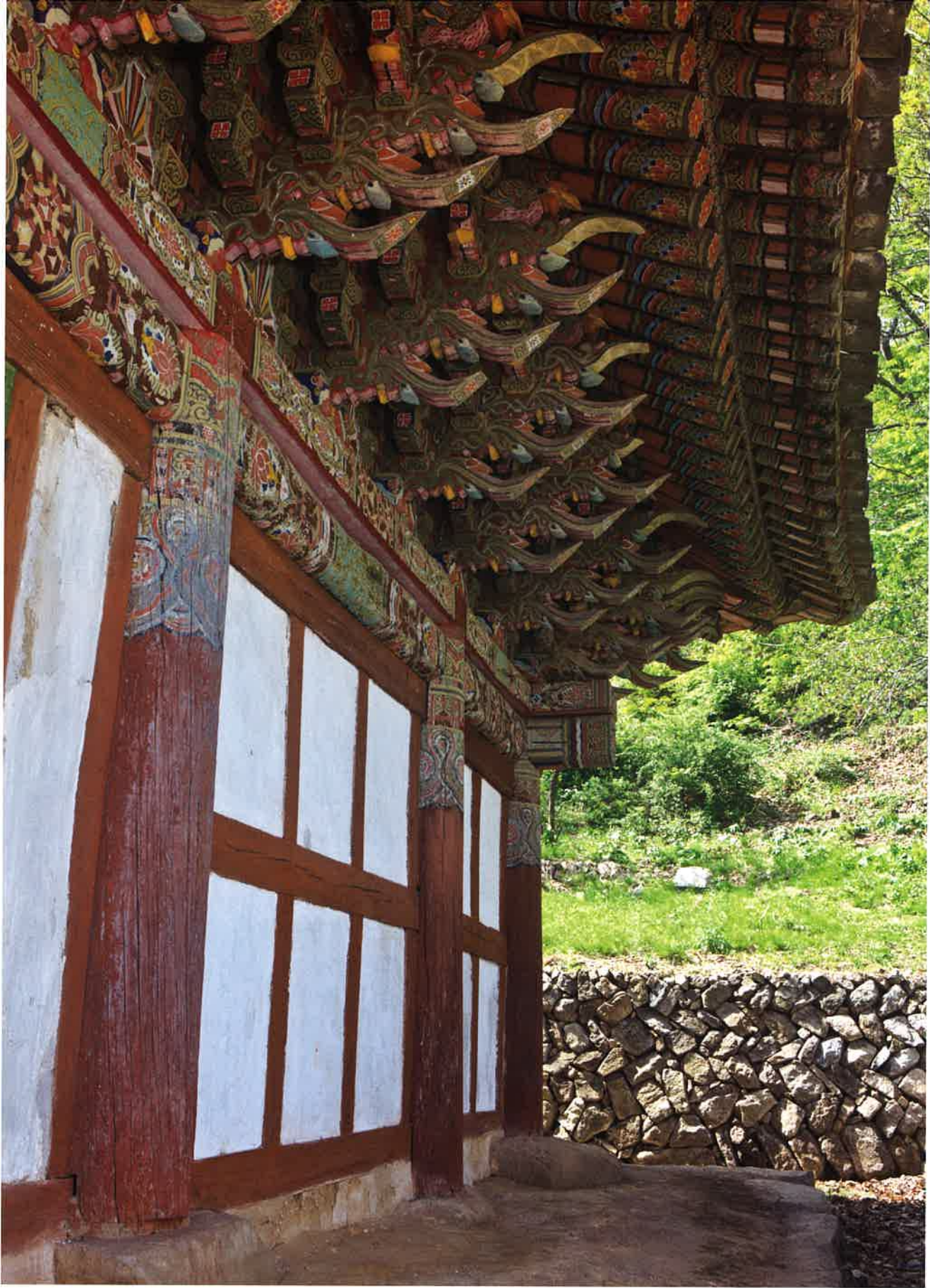
대웅전 동쪽 측면 처마와 기둥 / 大雄殿 東側 軒·平柱 / eastern eaves and columns, Taeungjön hall
