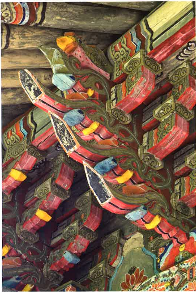
대웅전 뒷면 주간포 / 大雄殿 後面 柱間包 brackets between backward columns, Taeungjeon hall
