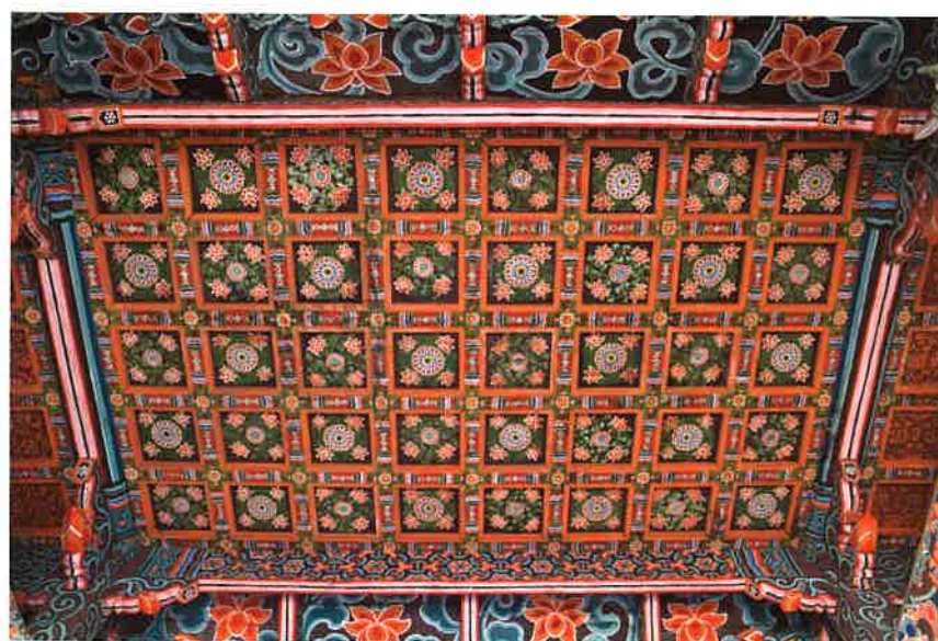
대웅전 내부 소란반자 / 大雄殿 內部 格子天障 / latticed ceiling, Taeungjeon hall
