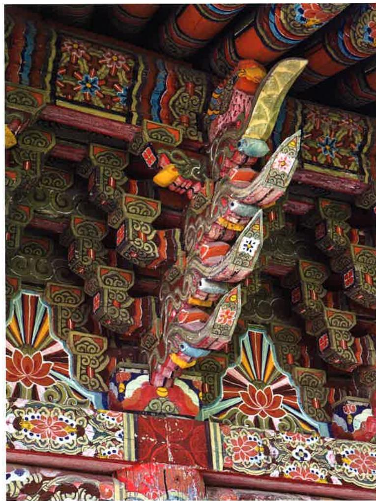
대웅전 동쪽 측면 주상포 / 大雄殿 東側 柱上包 brackets above eastern columns, Taeungjön hall
