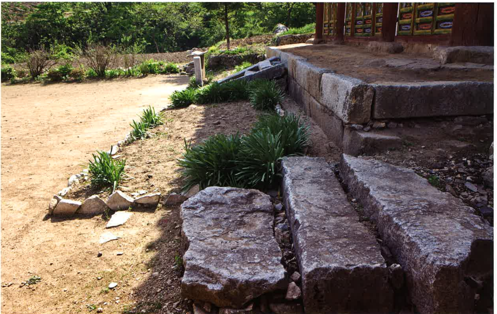
대웅전 앞면 기단과 동쪽 측면 계단 / 大雄殿 前面 基壇·東側 階段 / front stylobate and eastern stairs, Taeungjön hall
