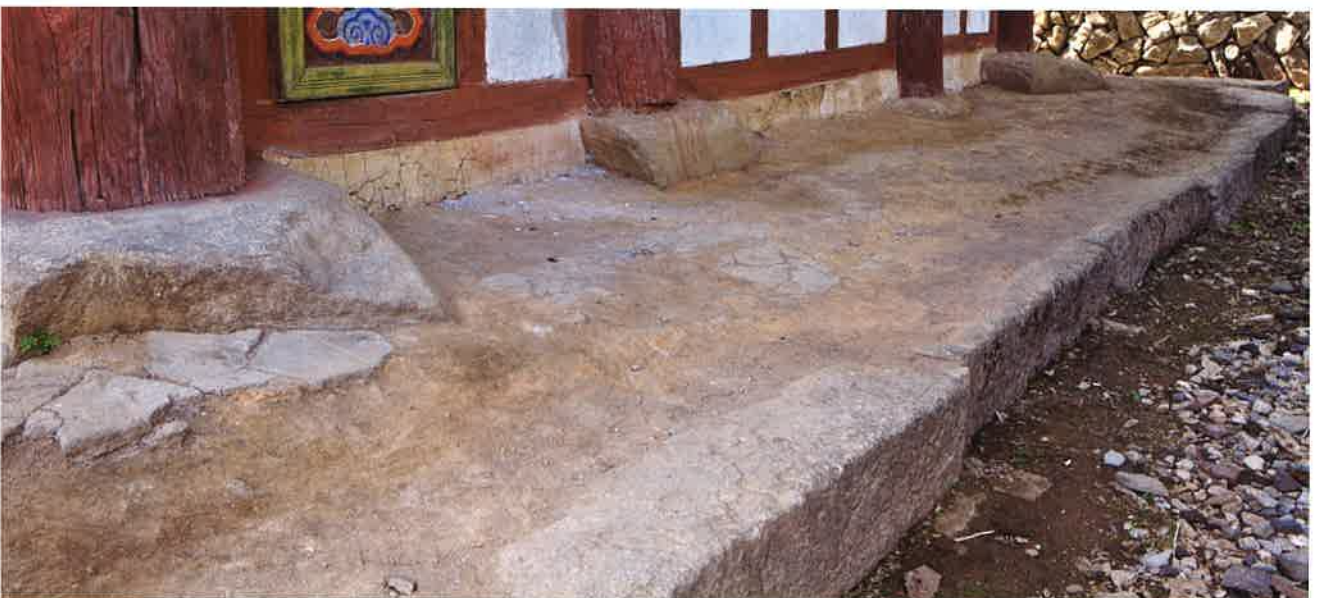
대웅전 동쪽 측면 기단과 주춧돌 / 大雄殿 東側 基壇·礎石 / eastern stylobate and plinths, Taeungjön hall
