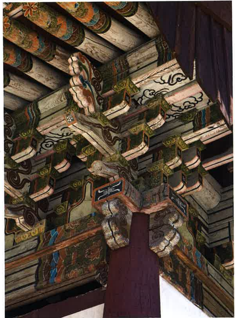
호지문 앞면 귀포 / 護持門 前面 耳包 front corner brackets, Hojimun gate
