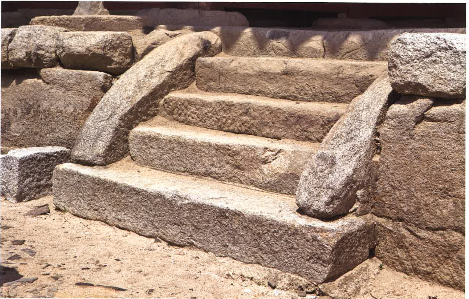
호지문 앞면 계단 / 護持門 前面 階段 / front stairs, Hojimun gate
