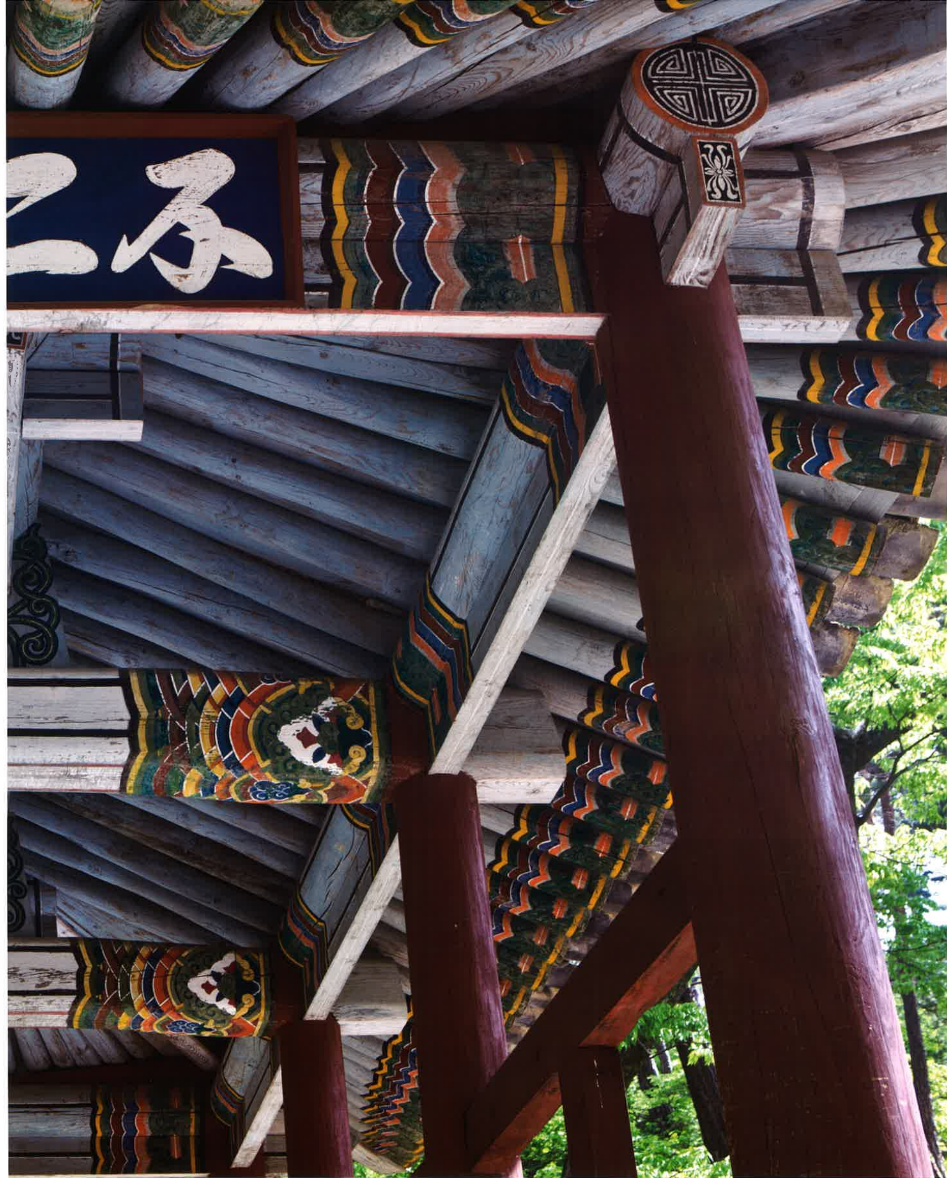
불이문 내부 반자 / 不二門 內部 天障 / ceiling, Purimun gate
