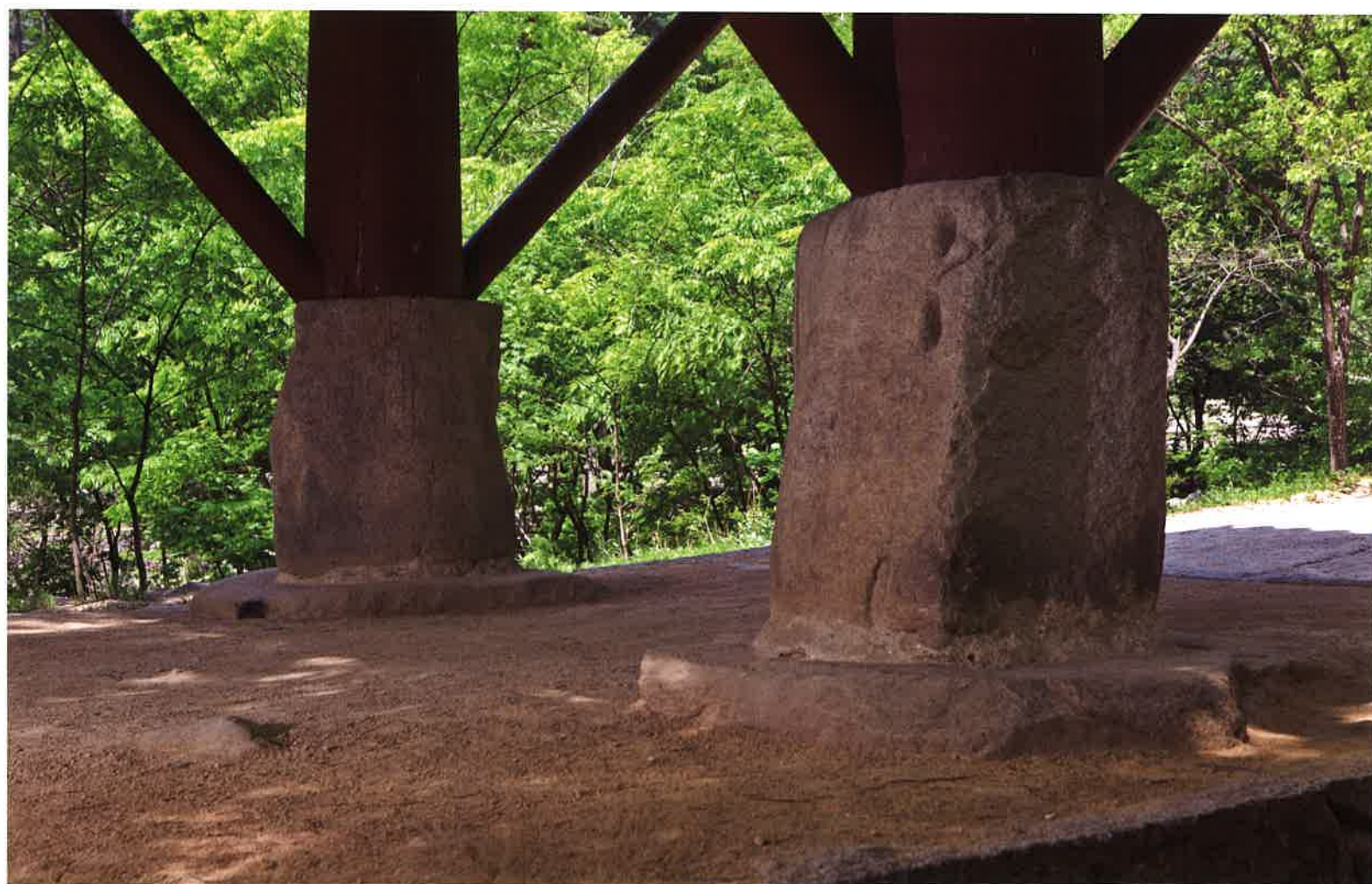
조계문 주춧돌 / 曹溪門 礎石 / plinths, Chogyemun gate
