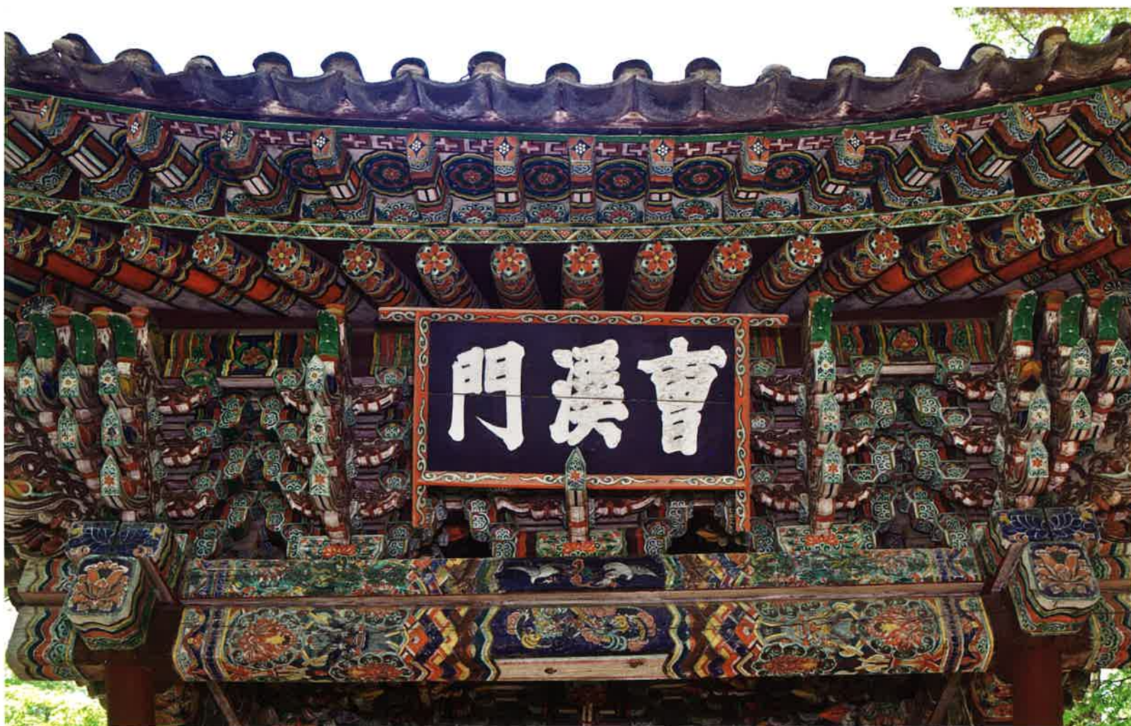
조계문 앞면 공포 / 曹溪門 前面 棋包 / front brackets, Chogyemun gate
