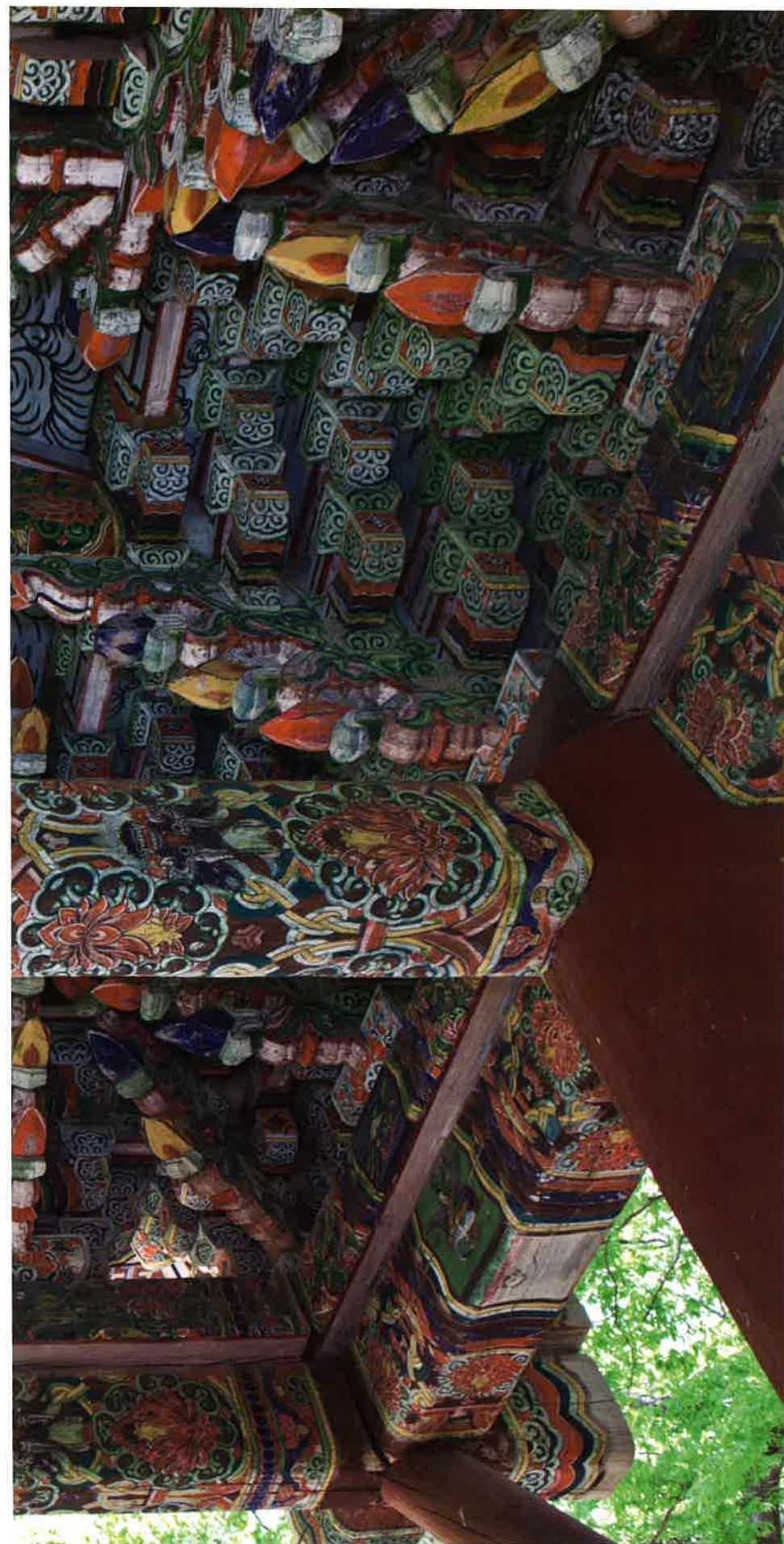
조계문 내부 반자 / 曹溪門 內部 天障 / ceiling, Chogyemun gate
