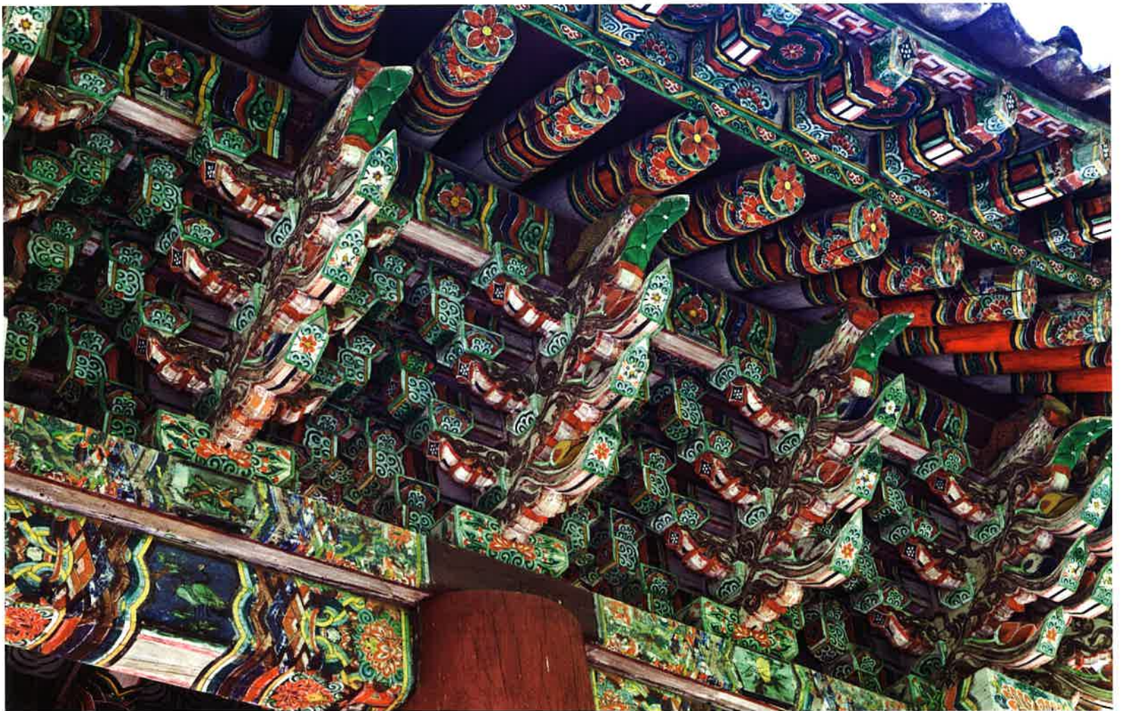
조계문 동쪽 측면 처마와 주상포 / 曹溪門 東側 軒·柱上包 / eastern eaves and brackets above columns, Chogyemun gate
