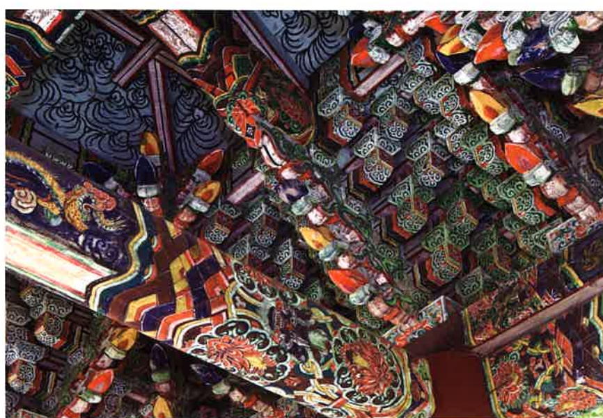
조계문 내부 주상포 / 曹溪門 內部 柱上包 / brackets above columns, Chogyemun gate
