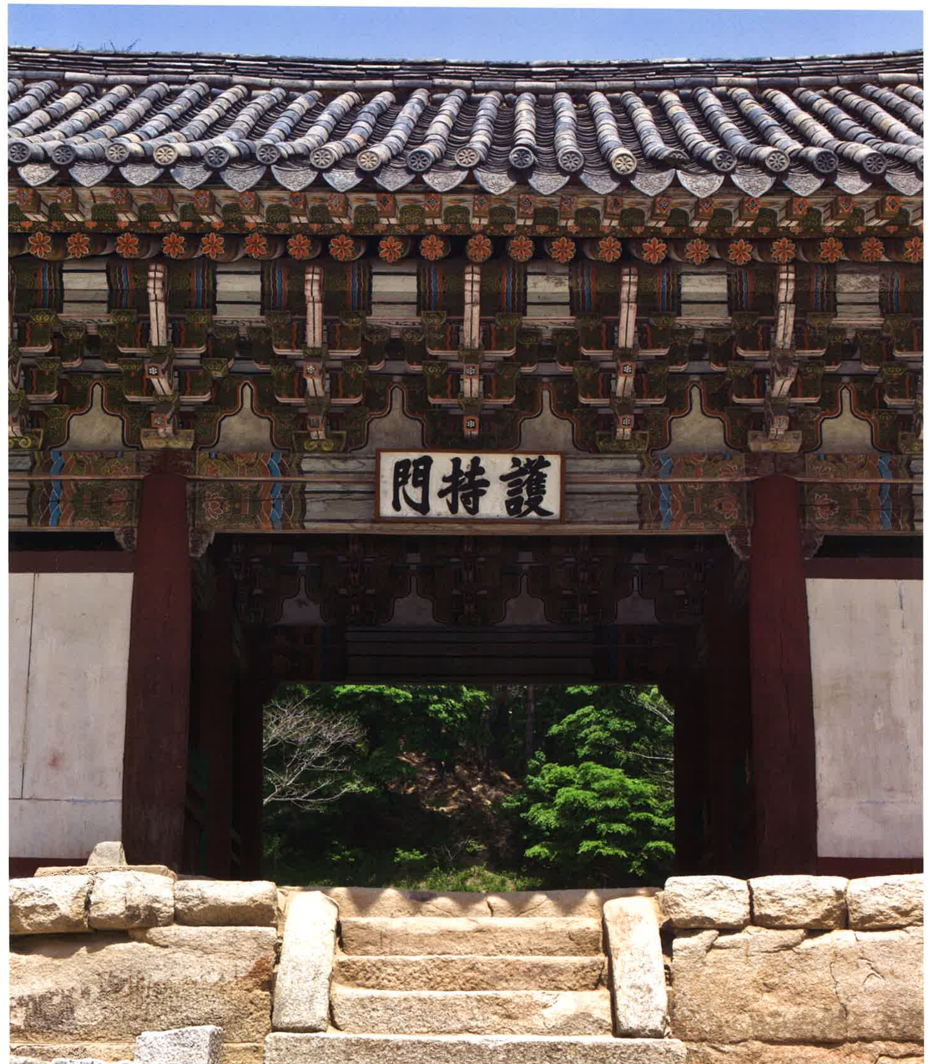
호지문 앞면 공포 / 護持門 前面 棋包 / front brackets, Hojimun gate
