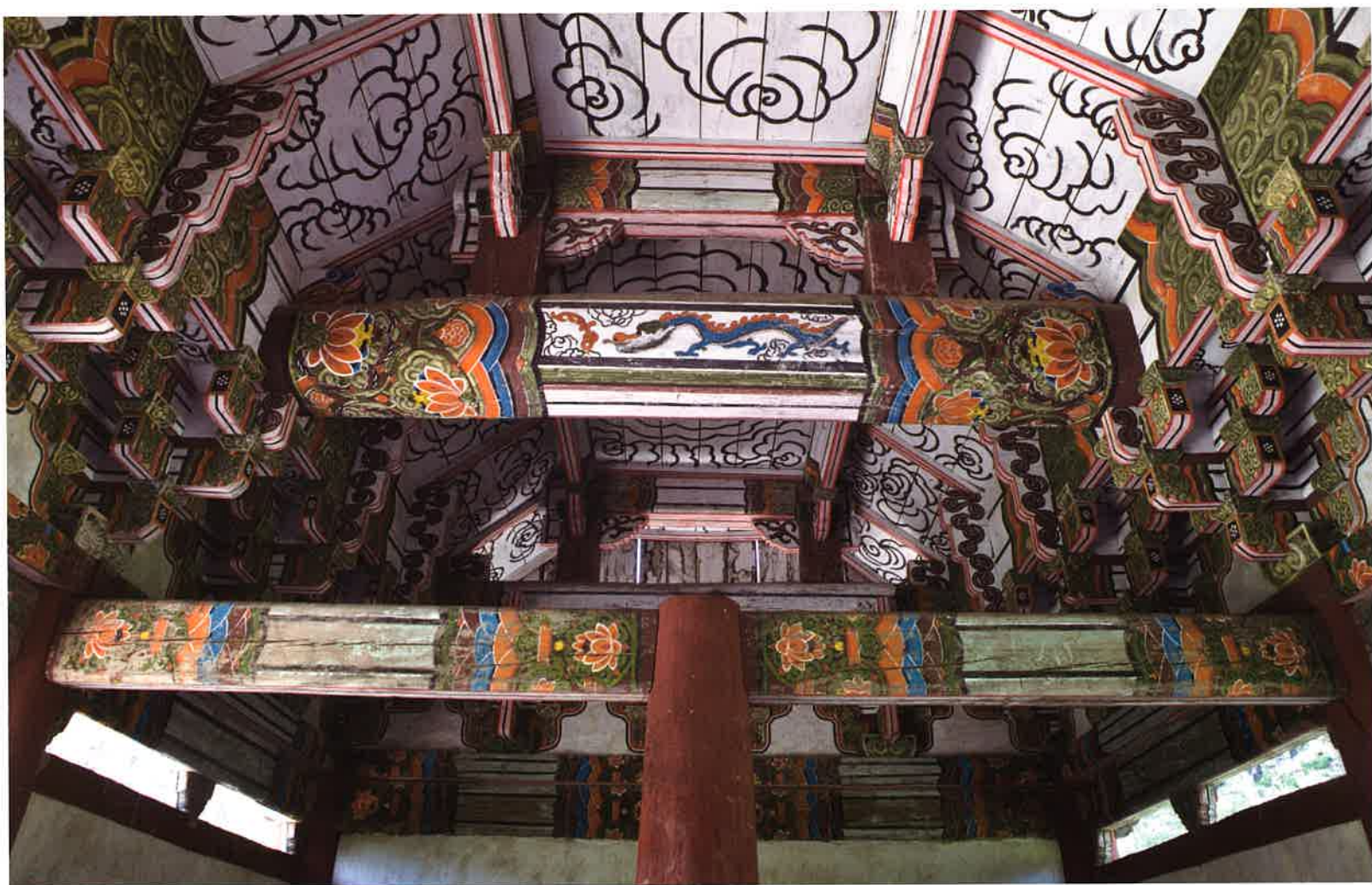
호지문 내부 대들보와 증보·종보 / 護持門 內部 大樑 中樑·宗樑 / main beam and supporting beams, Hojimun gate
