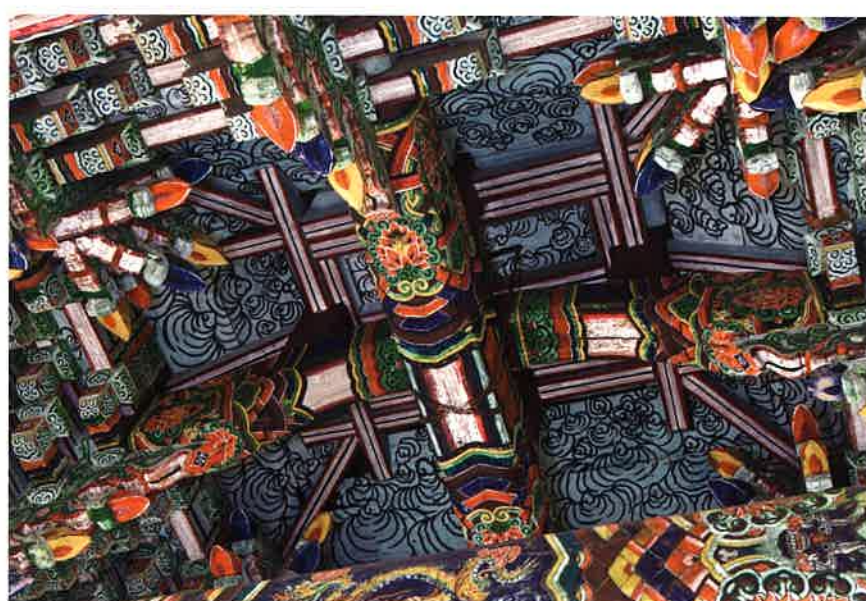
조계문 내부 반자 부분 / 曹溪門 內部 天障 部分 / part of ceiling, Chogyemun gate
