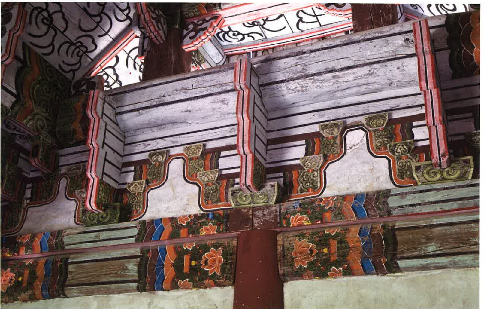
호지문 내부 주상포 / 護持門 內部 柱上包 / brackets above columns, Hojimun gate
