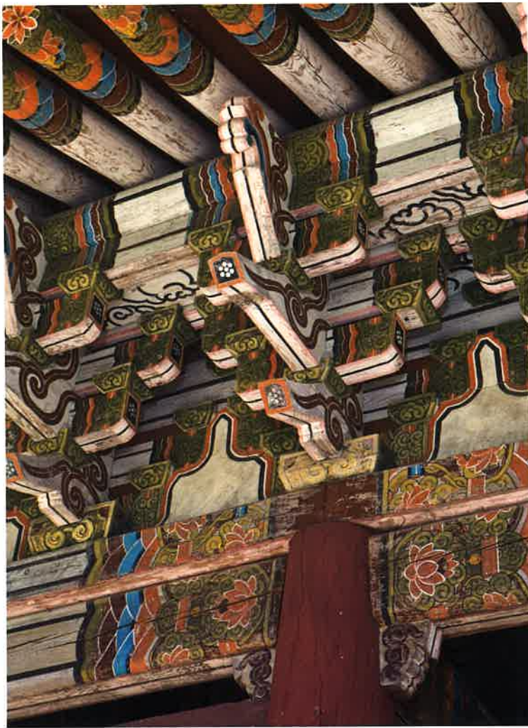
호지문 앞면 주상포 / 護持門 前面 柱上包 brackets above front columns, Hojimun gate
