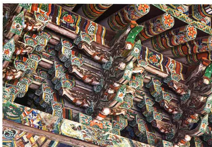
조계문 뒷면 가운데 공포 / 曹溪門 後面 中間 栱包 / backward middle brackets, Chogyemun gate
