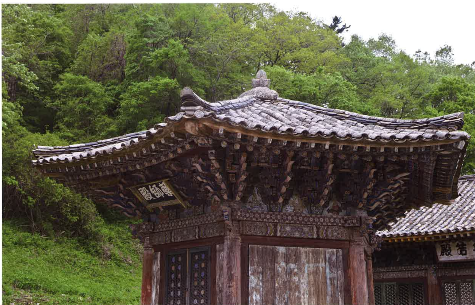
약사전 지붕 / 藥師殿 屋蓋 / roof, Yaksajön hall
