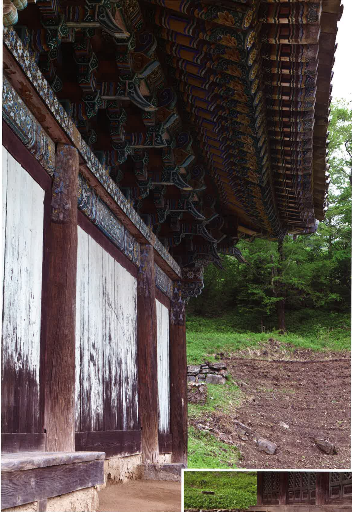
반야전 동쪽 측면 처마와 공포 / 般若殿 東側 軒-拱包 eastern eaves and brackets, Panyajön hall
