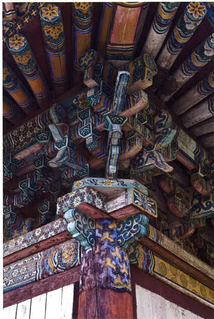
반야전 뒷면 동쪽 귀포 / 般若殿 後面 東側 耳包 backward eastern corner brackets, Panyajon hall
