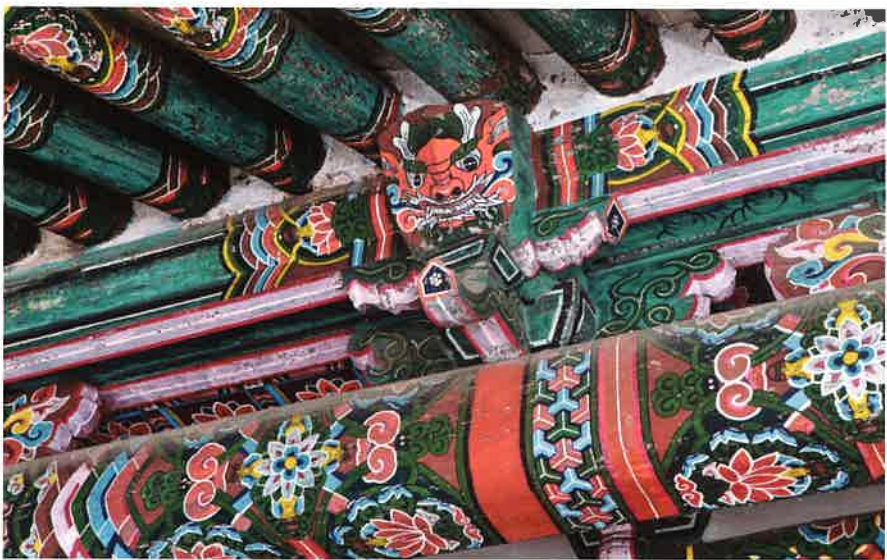
상원암 본전 앞면 주상포 / 上院庵 本殿 前面 柱上包 brackets above front columns of main hall, Sangwŏnam
