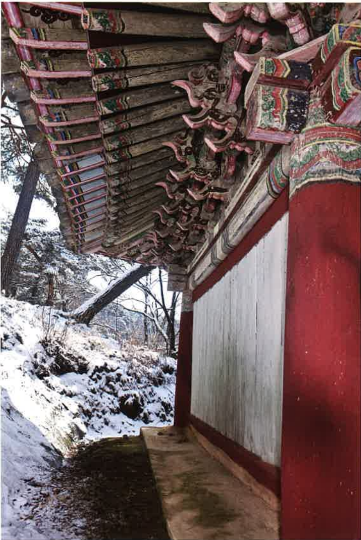
칠성각 뒷면 처마와 공포 / 七星閣 後面 軒·拱包 eaves and brackets of backward side, Ch'ilsönggak shrine
