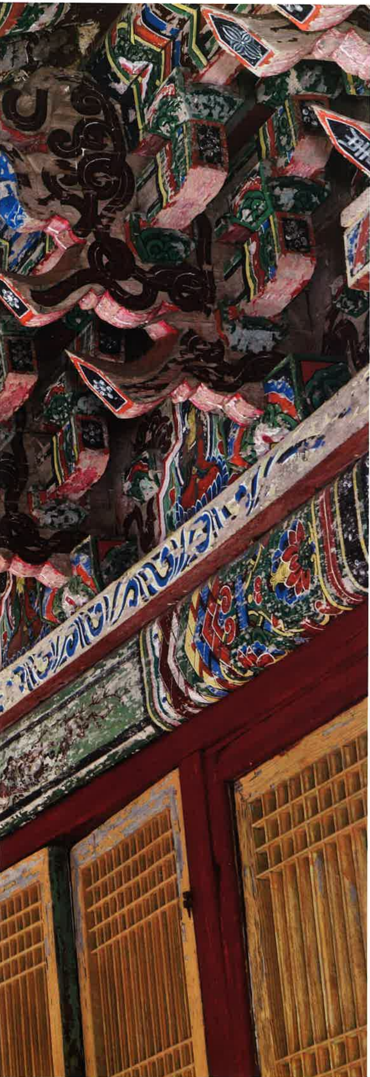
칠성각 앞면 처마 / 七星閣 前面 軒 / front caves, Ch'ilsönggak shrine
