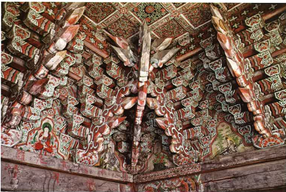
칠성각 내부 귀포 / 七星閣 內部 耳包 corner brackets, Ch'lsönnngak shrine
