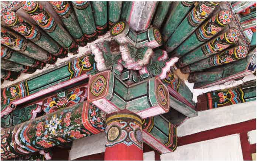
상원암 본전 앞면 귀포 / 上院庵 本殿 前面 耳包 corner brackets of main hall, Sangwŏnam
