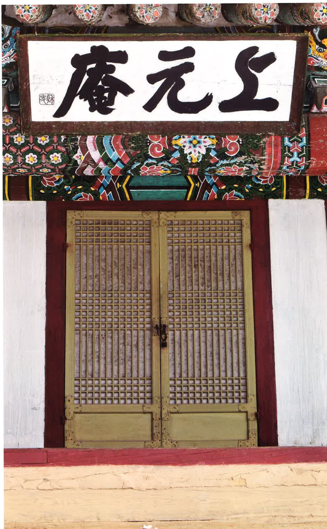
상원암 본전 액방과 가운데 창호 / 上院庵 本殿 額枋·窓戶 / lintel and middle doors of main hall, Sangwŏnam
