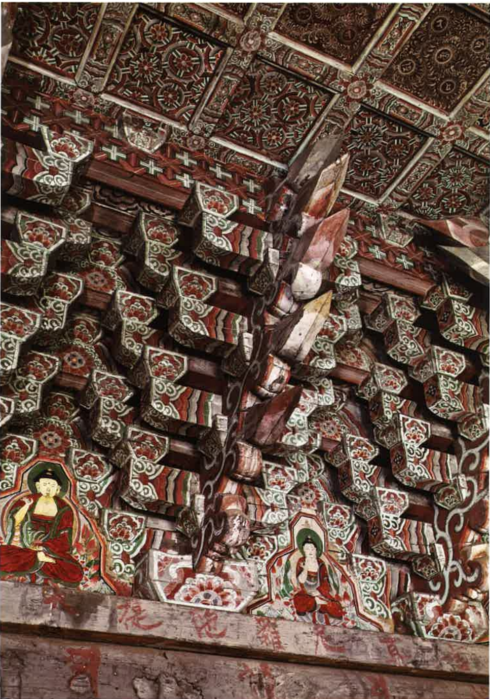
칠성각 내부 주간포 / 七星閣 內部 柱間包 brackets between columns, Ch'lsönnngak shrine
