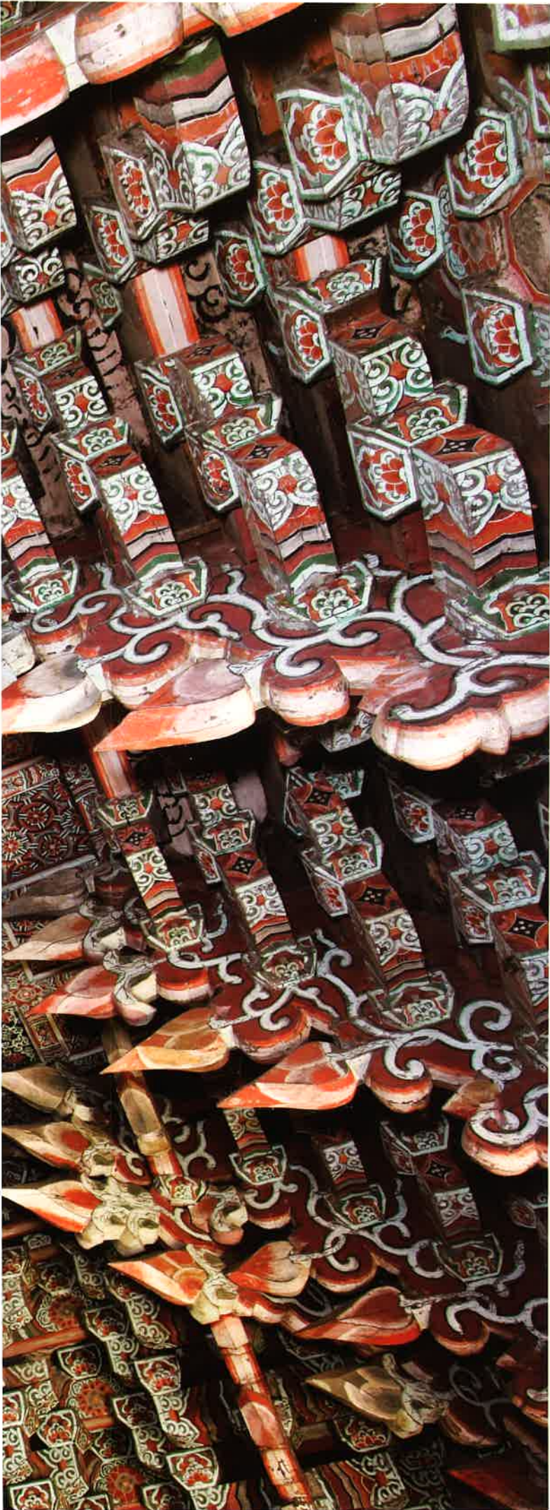
칠성각 내부 소란반자 / 七星閣 內部 格子天障 latticed ceiling, Ch'lsönnngak shrine
