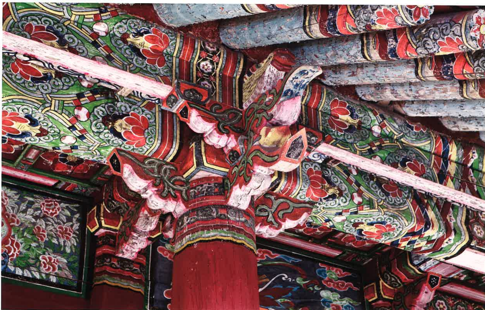
화장암 앞면 주상포 / 華藏庵 前面 柱上包 / brackets above front columns, Hwajangam
