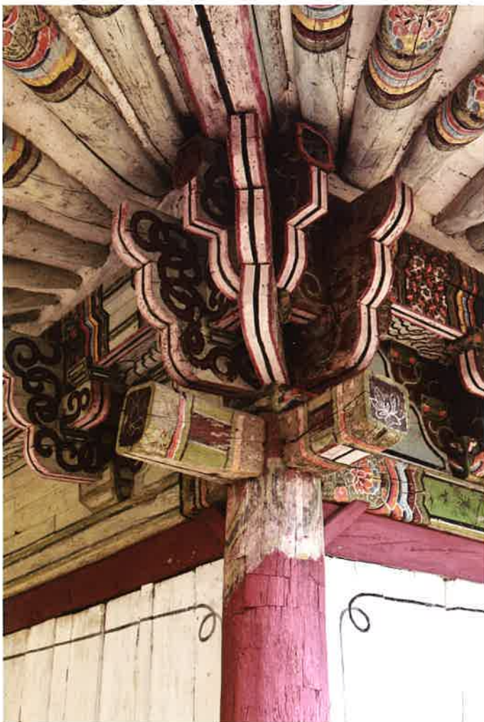
대웅전 뒷면 서쪽 귀포 / 大雄殿 後面 西側 耳包 western corner brackets, Taeungjeon hall
