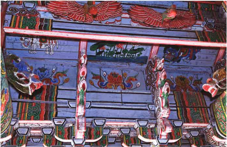
대웅전 내부 빗반자 별화 / 大雄殿 內部 斜天障 別齋 attached painting on inclined ceiling, Taeungjön hall
