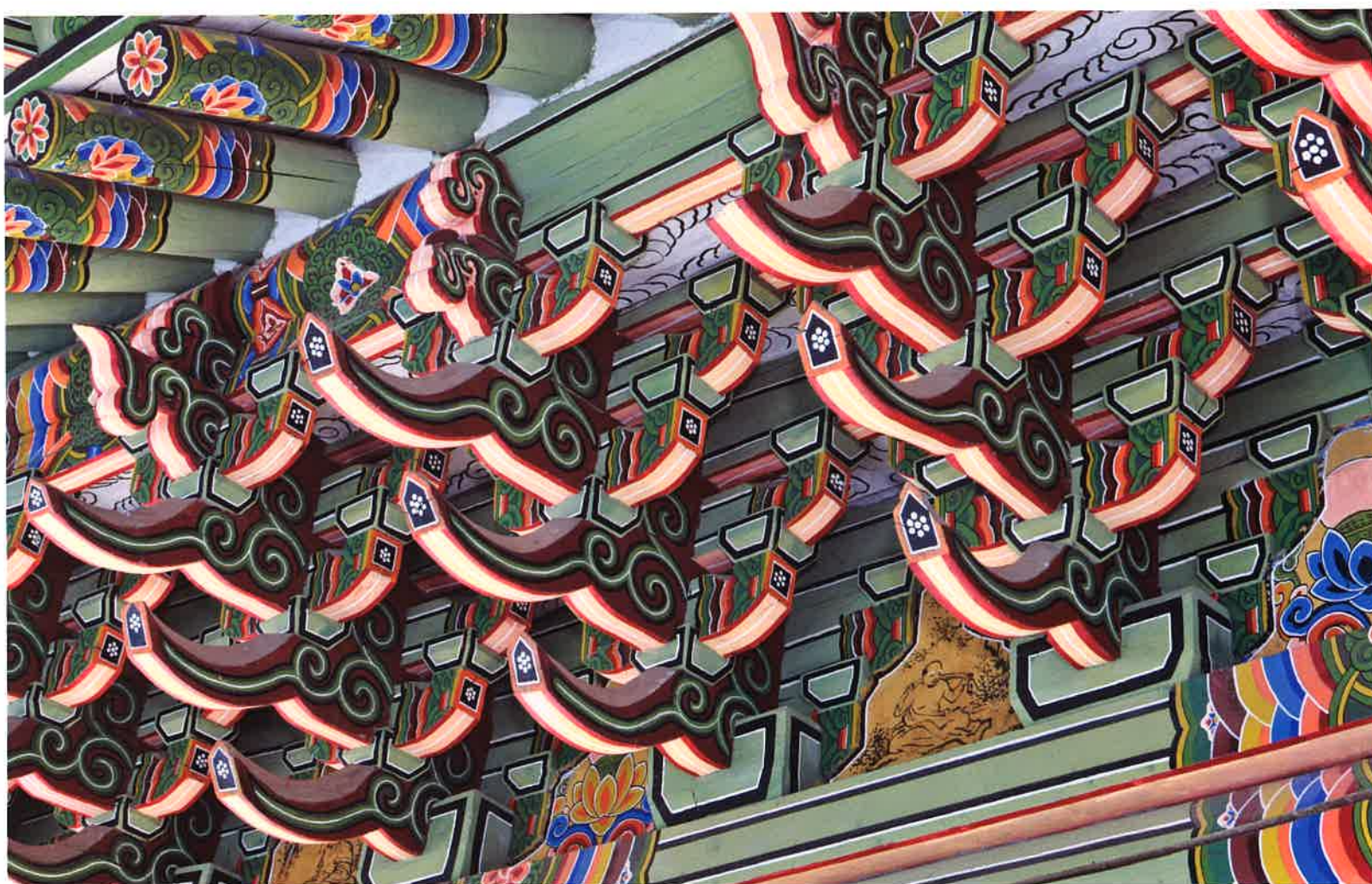
대웅전 서쪽 측면 주간포 / 大雄殿 西側 柱間包 / brackets between western columns, Taeungjeon hall
