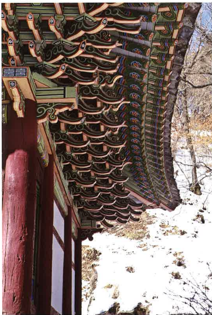
대웅전 동쪽 처마와 공포 / 大雄殿 東側 軒·栱包 eastern eaves and brackets, Taeungjön hall
