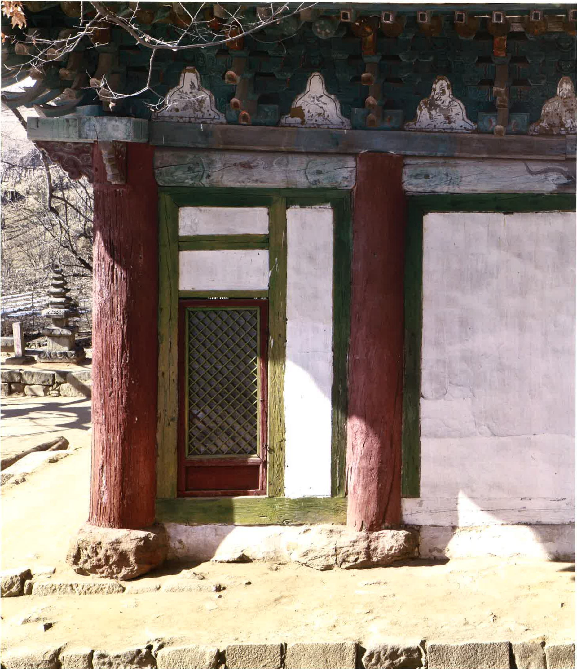
대웅전 동쪽 측면 화반과 창호 / 大雄殿 東側 花盤・窓戶 / eastern door and Hwaban, Taeungjeon hall
