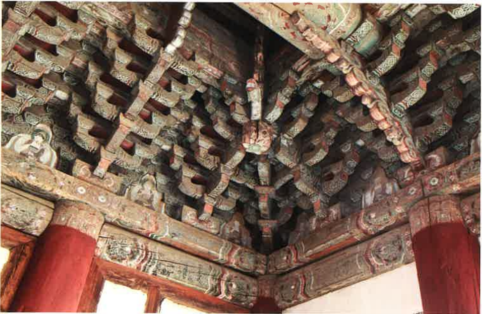
대웅전 내부 귀포 / 大雄殿 内部 耳包 / corner brackets, Taeungjon hall
