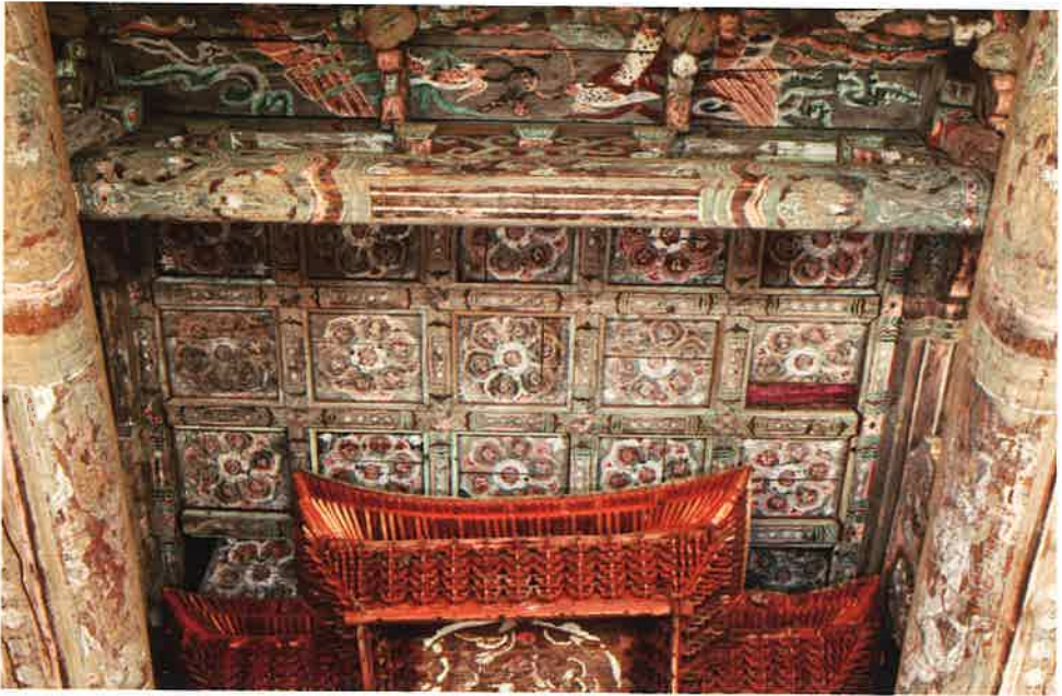
대웅전 내부 소란반자 / 大雄殿 内部 格子天障 / latticed ceiling, Taeungjon hall
