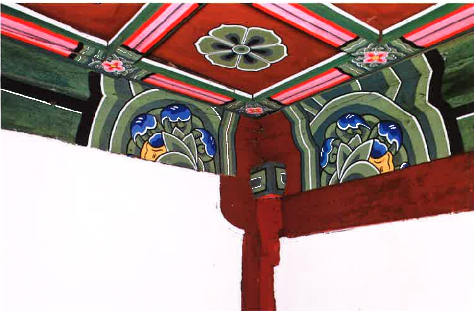
현암 내부 서쪽 귀포 / 懸庵 內部 西側 耳包 / western corner brackets, Hyönam
