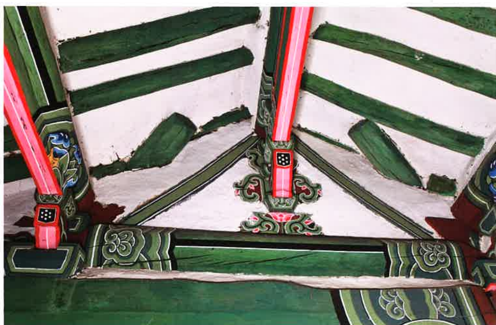
현암 내부 반자 / 懸庵 內部 天障 / ceiling, Hyōnam
