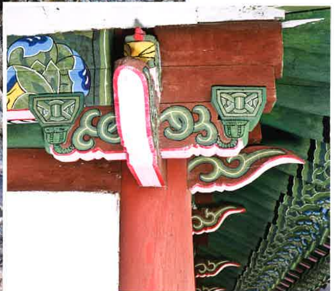
현암 앞면 귀포 / 懸庵 前面 耳包 front corner brackets, Hyönam
