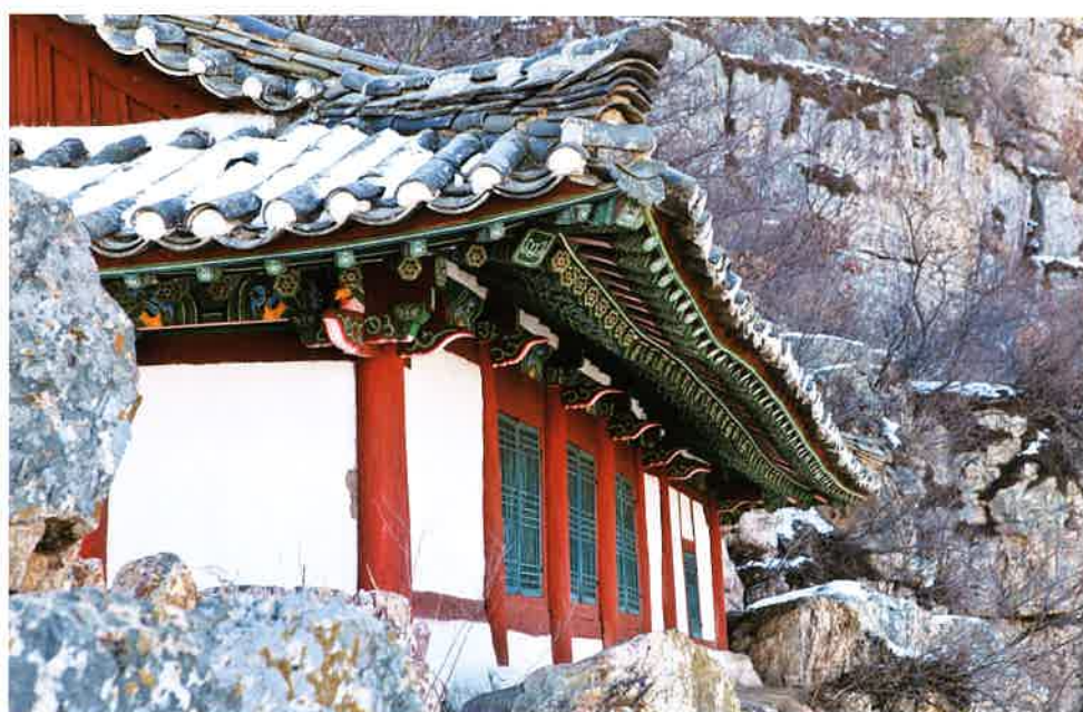
현암 앞면 처마와 공포 / 懸庵 前面 軒·拱包 / front eaves and brackets, Hyōnam
