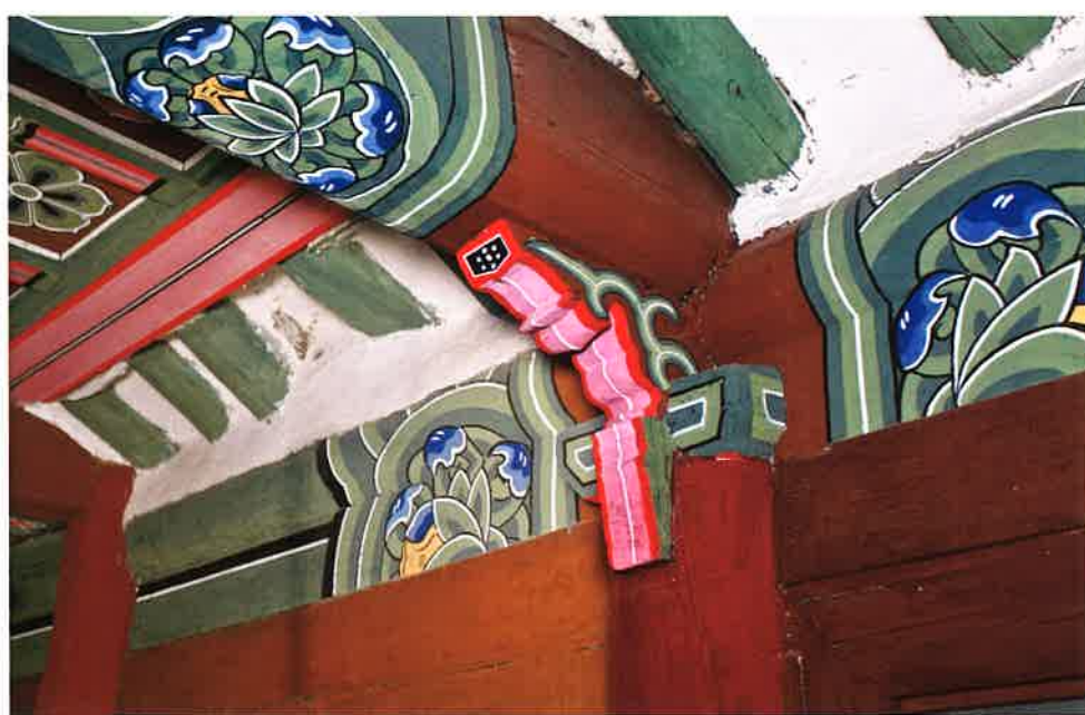
현암 내부 주상포 / 懸庵 內部 柱上包 / brackets above columns, Hyōnam
