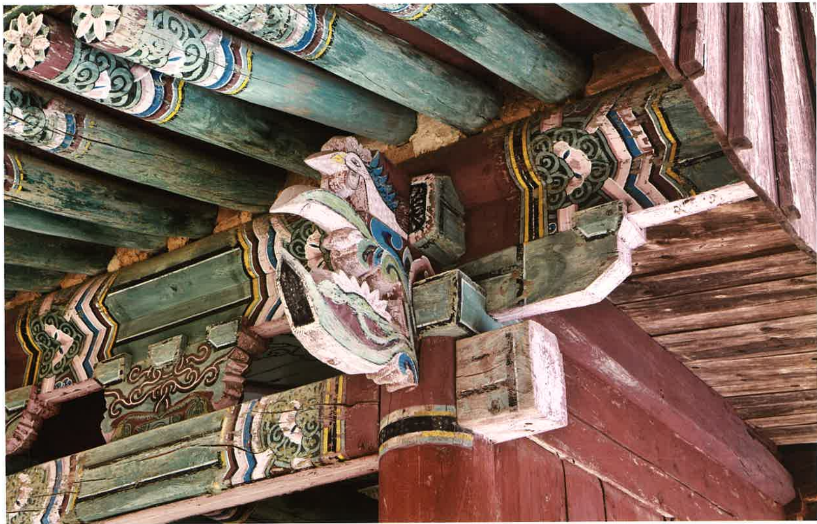
만세루 전면 귀포 / 萬歲樓 前面 耳包 / front corner brackets, Manseru
