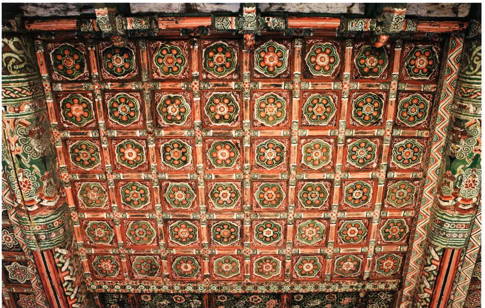
극락보전 내부 소란반자 / 極樂寶殿 內部 格子天障 / latticed ceiling, Kungnakpojon hall
