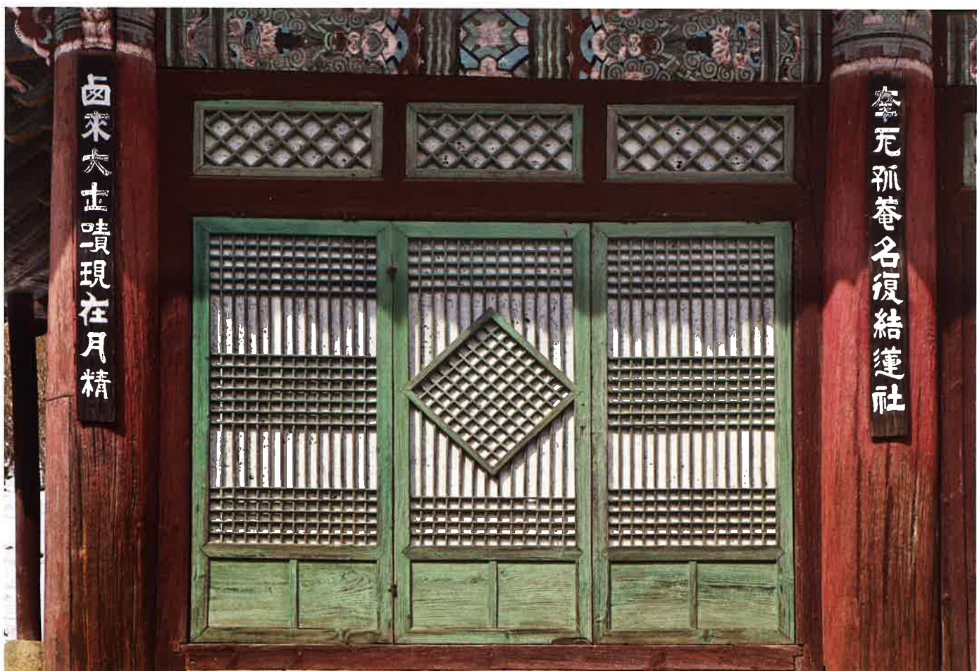
극락보전 앞면 서쪽 협간 창호와 주련 / 極樂寶殿 前面 西側 夾間 窓戶·柱聯 / western windows and doors and pillar tablets, Kungnakpojon hall
