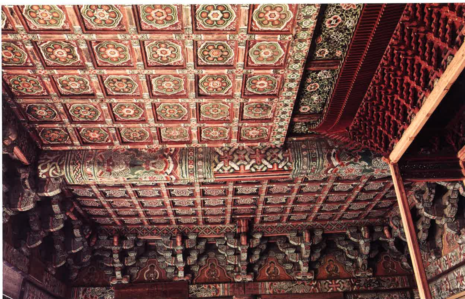
극락보전 내부 반자 부분 / 極樂寶殿 內部 天障 部分 / part of ceiling, Kungnakpojon hall
