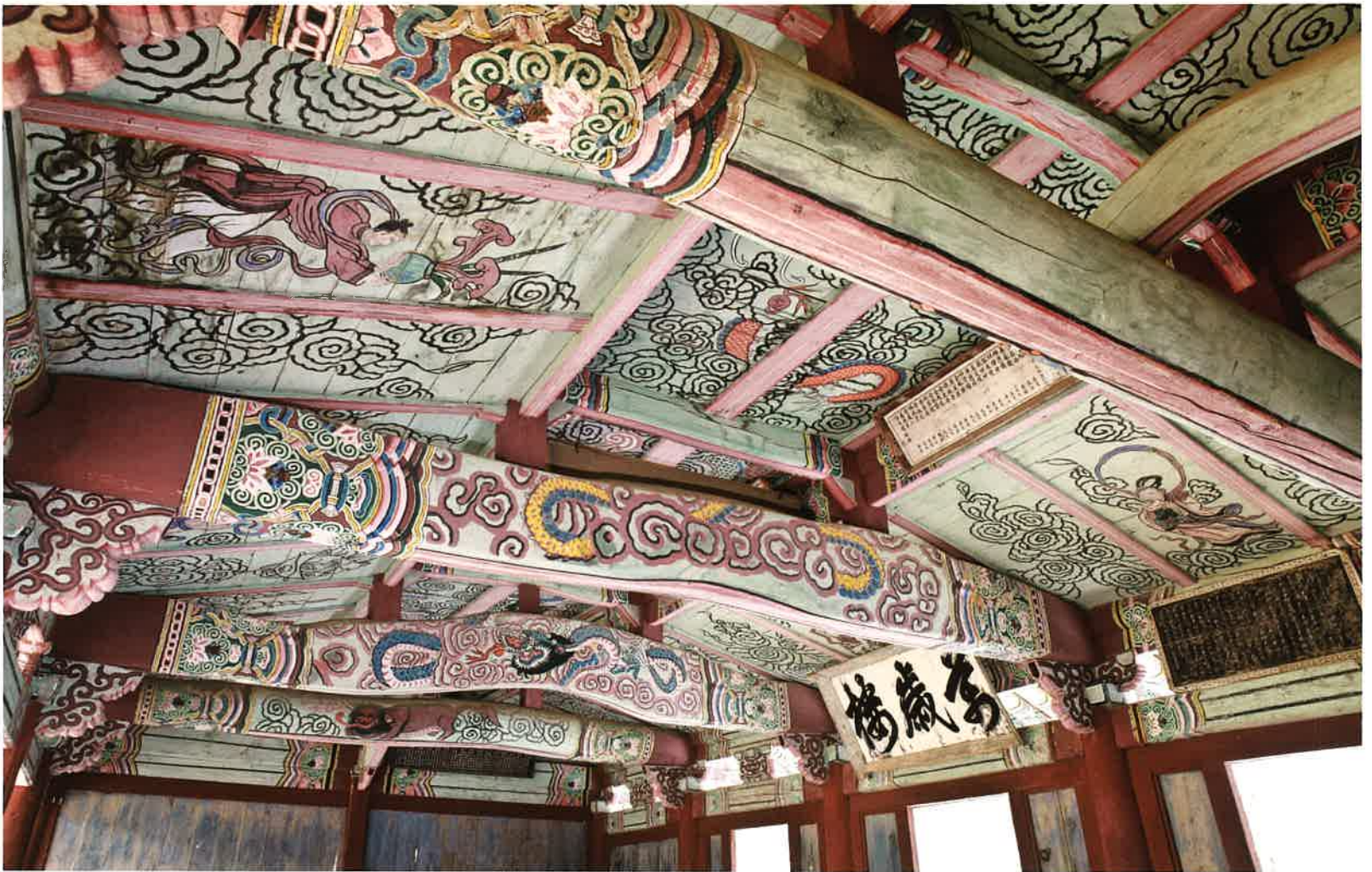
만세루 대들보 / 萬歲樓 大樑 / main beam, Manseru
