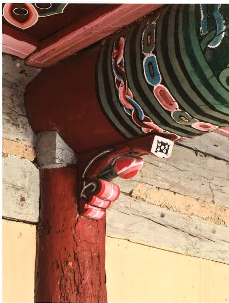
수월당 내부 대들보와 주상포 / 水月堂 內部 大樑·柱上包 main beam and brackets above columns, Suwöltang hall
