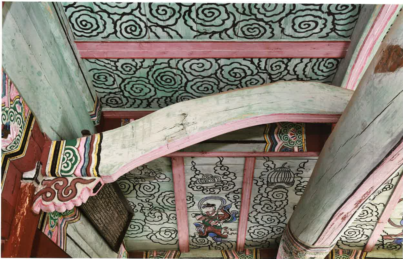
만세루 내부 총량 / 萬歲樓 內部 衡樑 / measuring beam, Manseru
