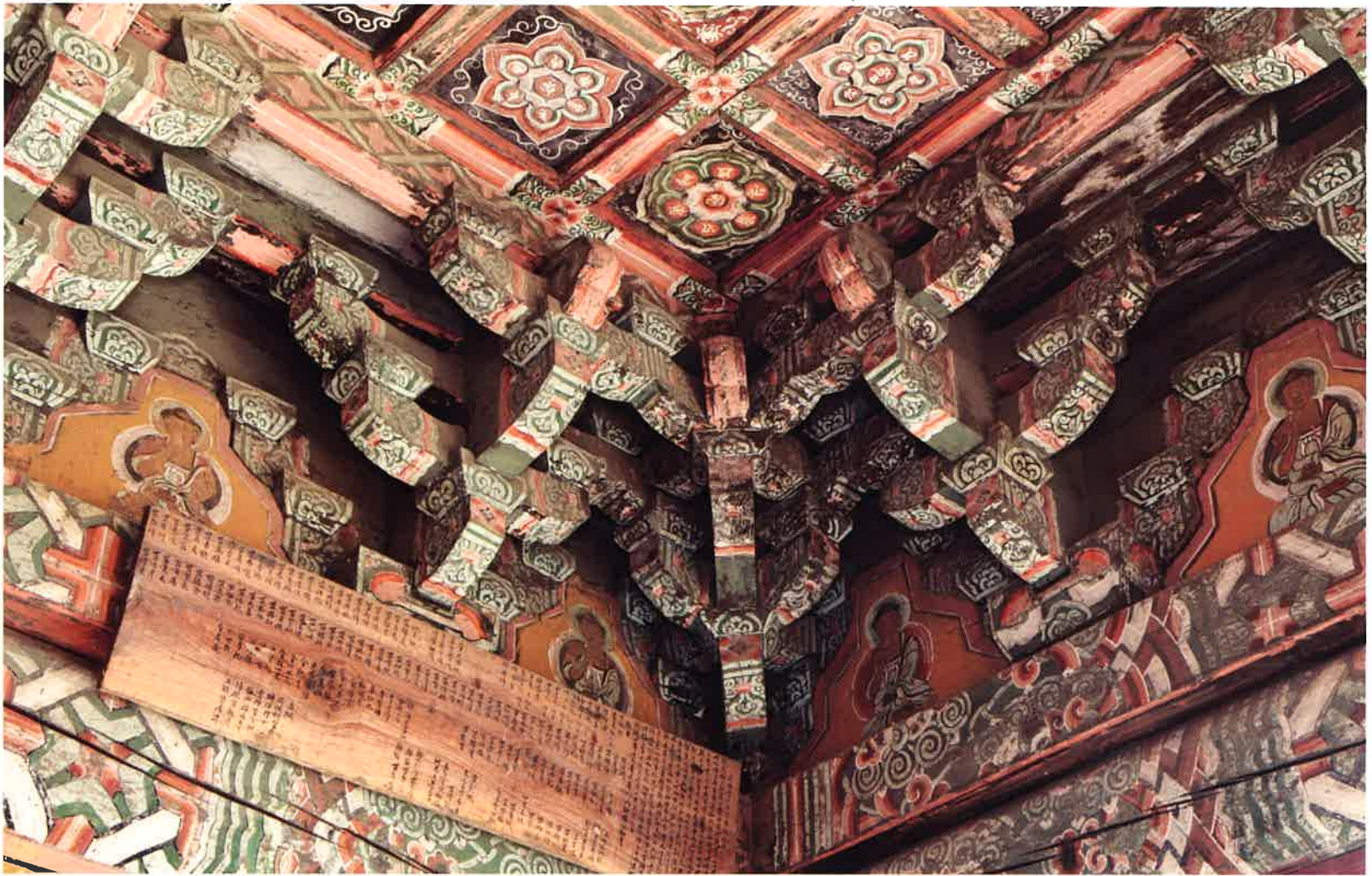
극락보전 내부 서쪽 귀포 / 極樂寶殿 內部 西側 耳包 / western corner brackets, Kungnakpojon hall
