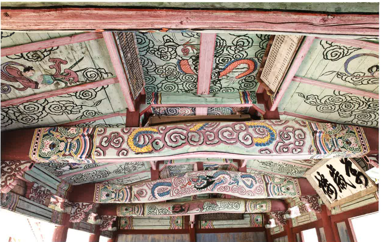
만세루 대들보 / 萬歲樓 大樑 / main beam, Manseru
