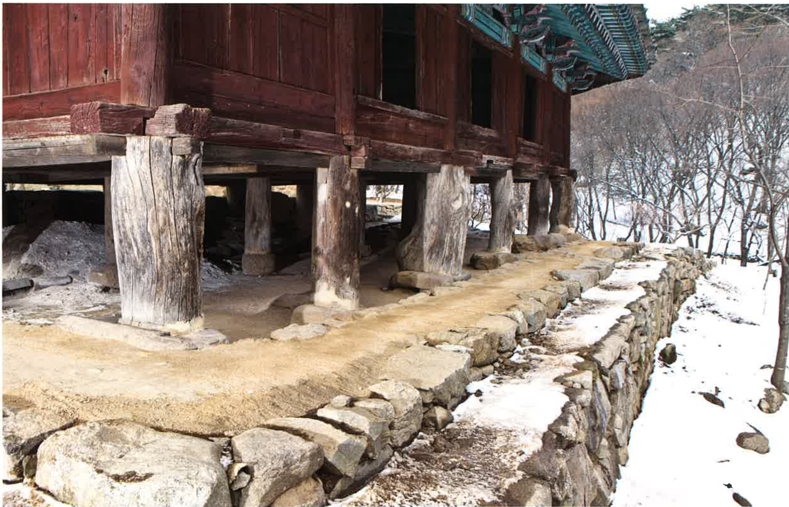
만세루 앞면 기단과 기둥 / 萬歲樓 前面 基壇·樓下柱 / front stylobate and columns, Manseru
