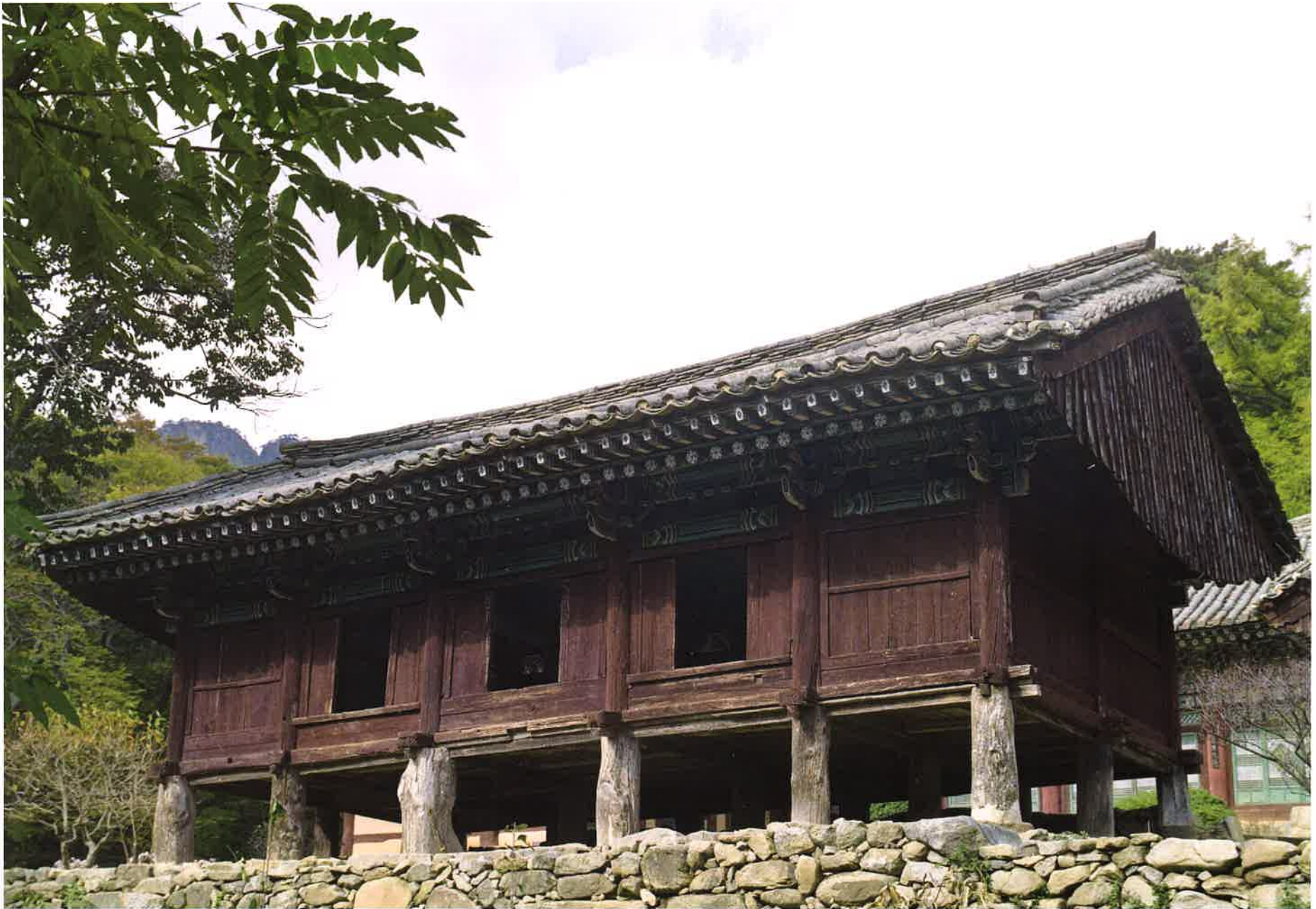
만세루 전경 / 萬歲樓 全景 / whole view, Manseru
