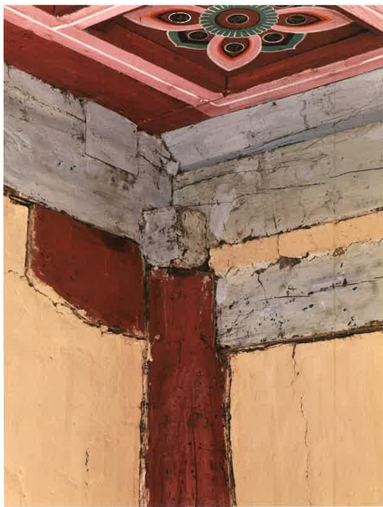
수월당 내부 귀포 2 / 水月堂 內部 耳包 2 corner brackets 2, Suwöltang hall
