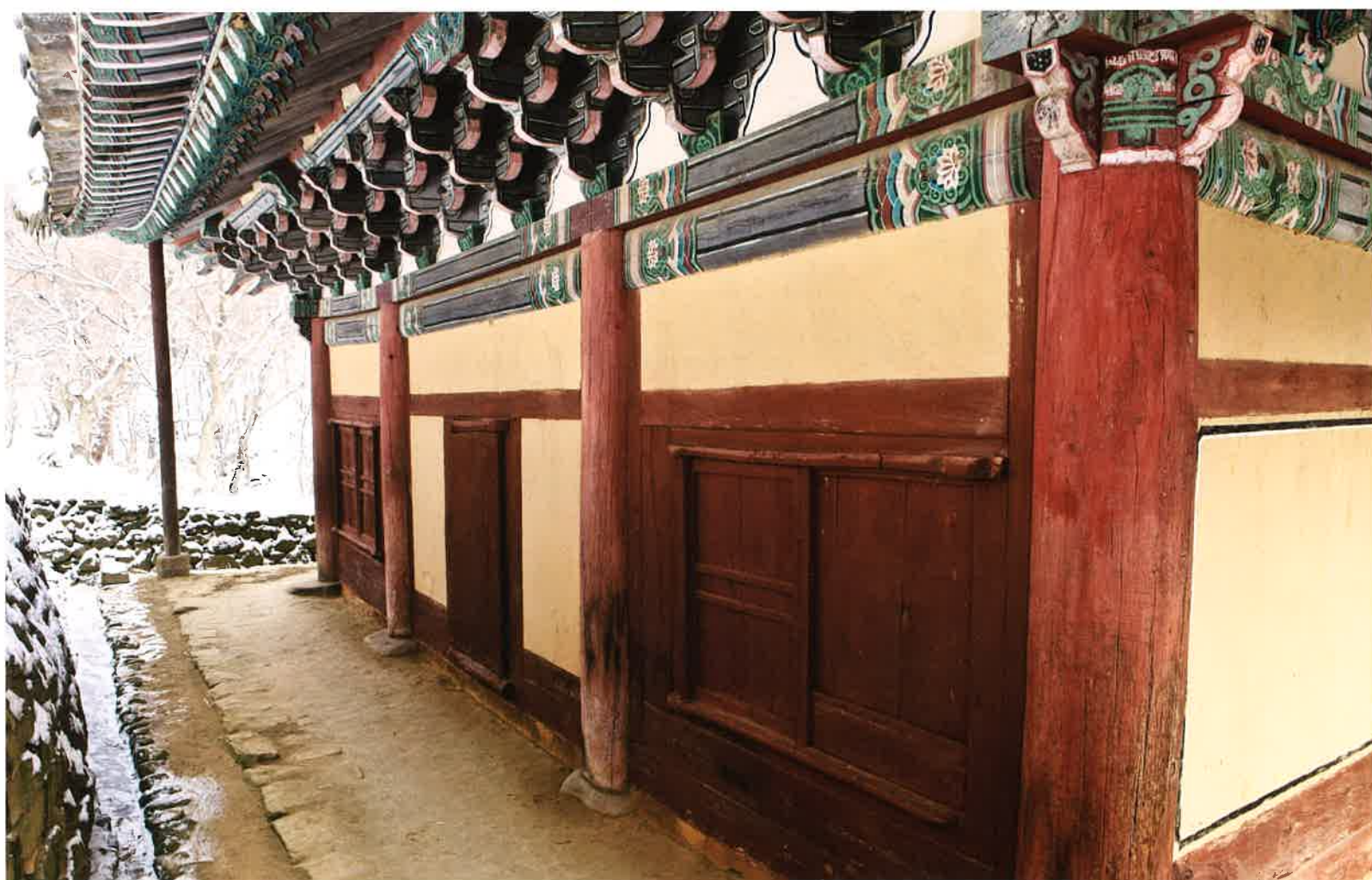
극락보전 뒷면 벽체 / 極樂寶殿 後面 壁體 / backward wall, Kŭngnakpojŏn hall
