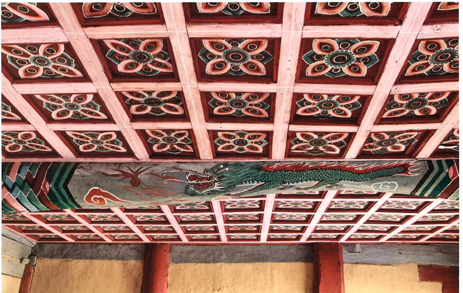
수월당 내부 반자 1 / 水月堂 内部 天障 1 / ceiling 1, Suwöltang hall
