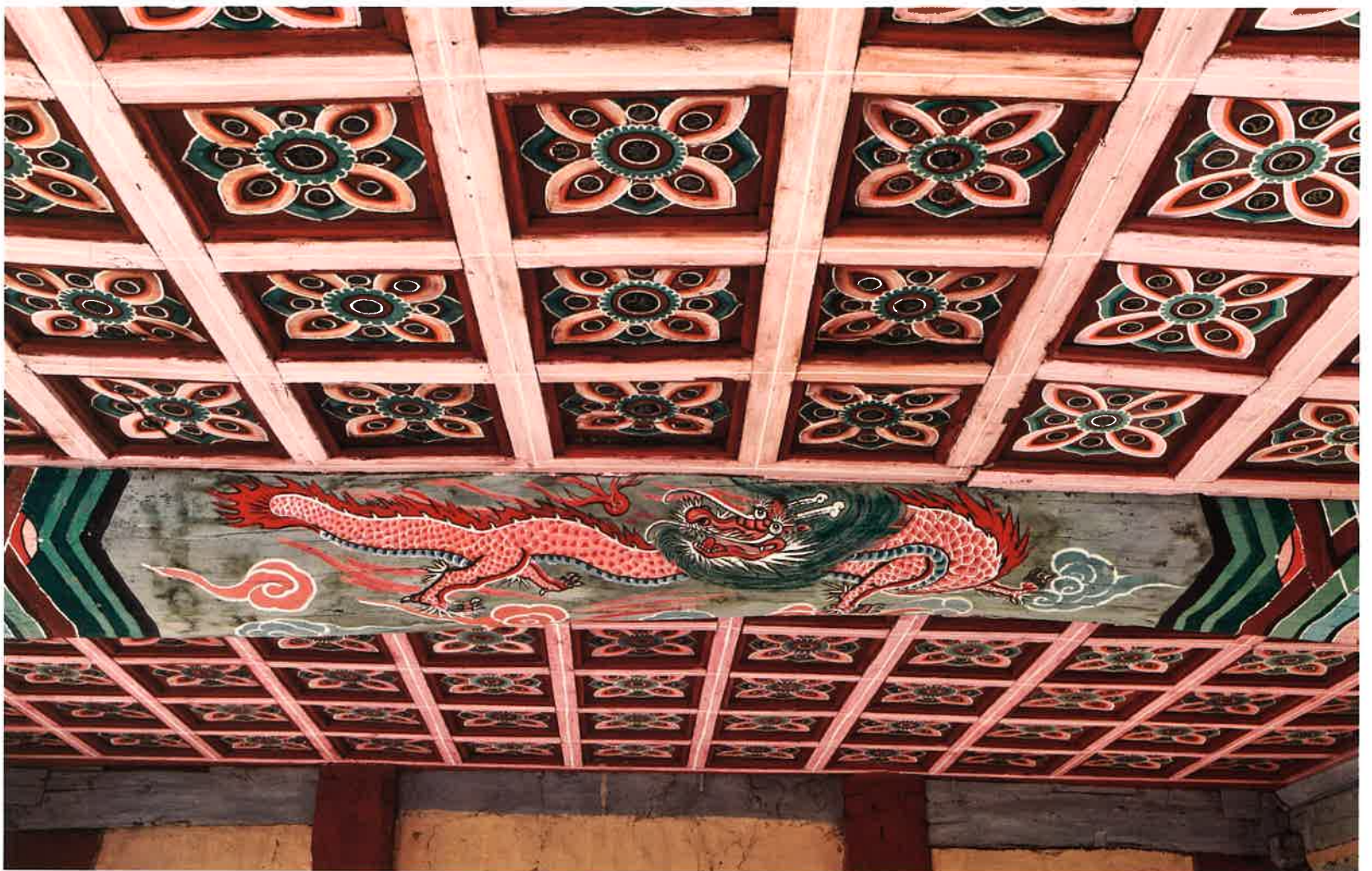
수월당 내부 반자 2 / 水月堂 内部 天障 2 / ceiling 2, Suwöltang hall
