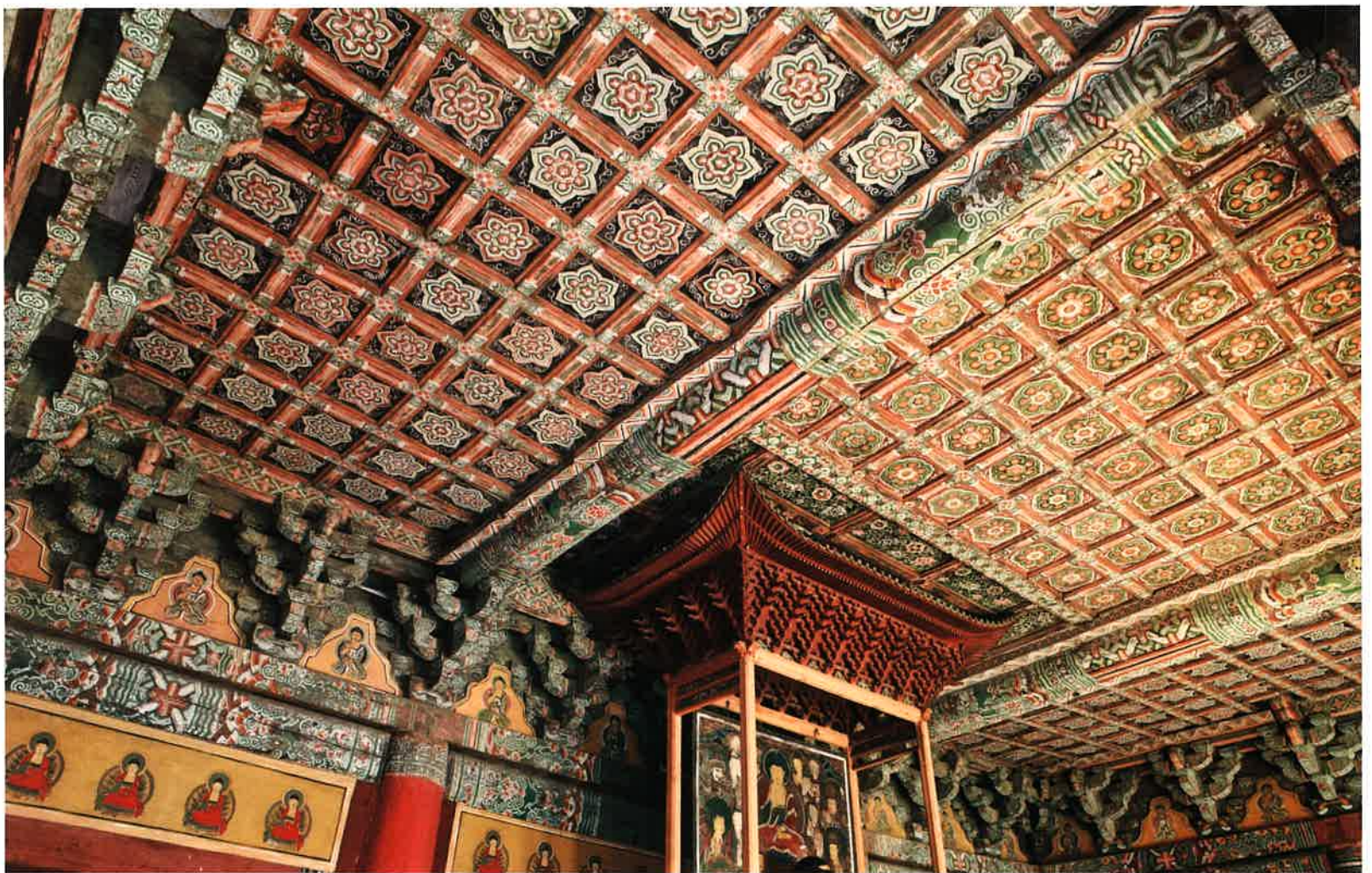
극락보전 내부 반자 전경 / 極樂寶殿 內部 天障 全景 / ceiling, Kungnakpojon hall
