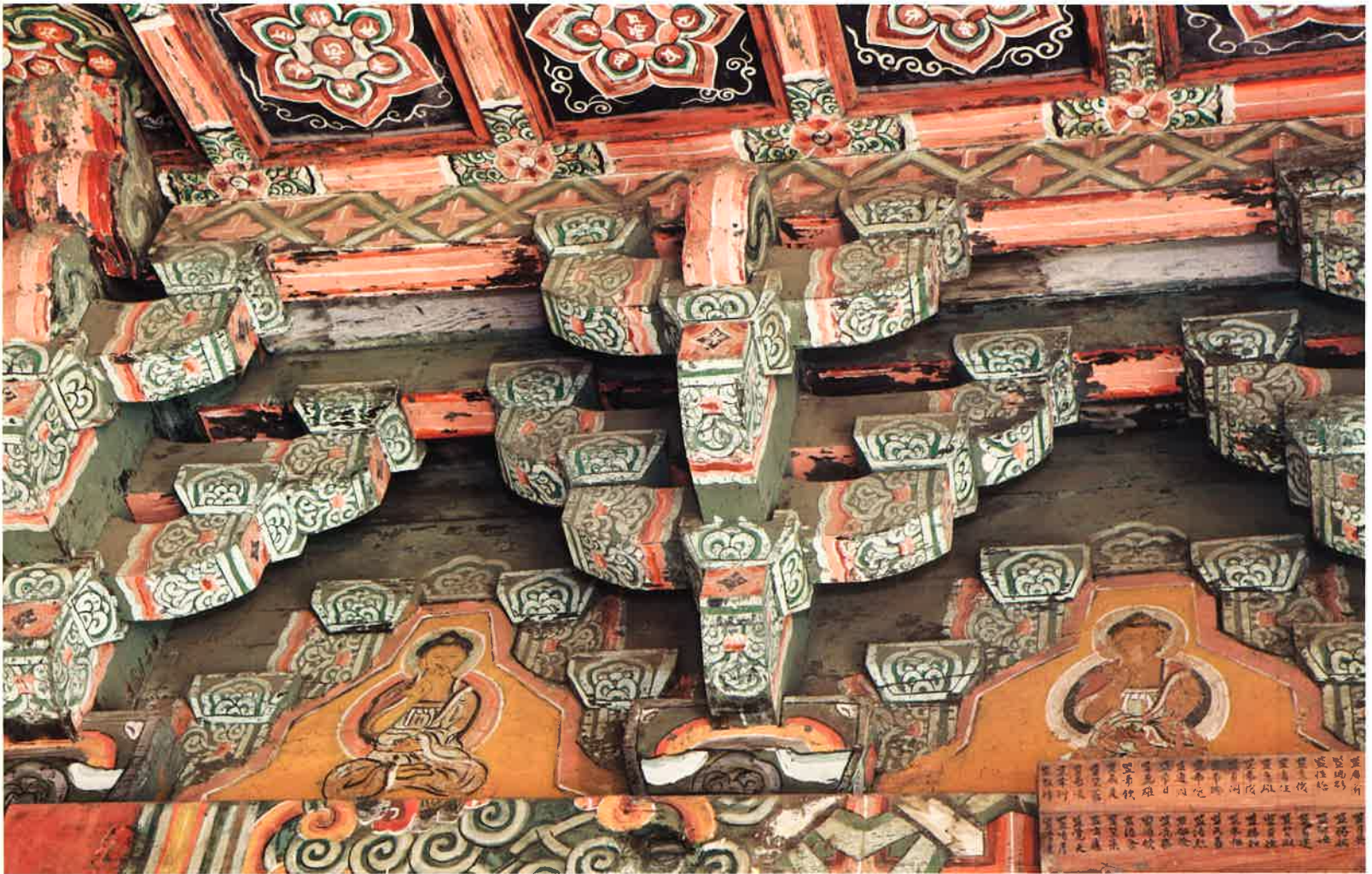
극락보전 내부 서쪽 측면 주간포 / 極樂寶殿 內部 西側 柱間包 / brackets between western columns, Kungnakpojon hall
