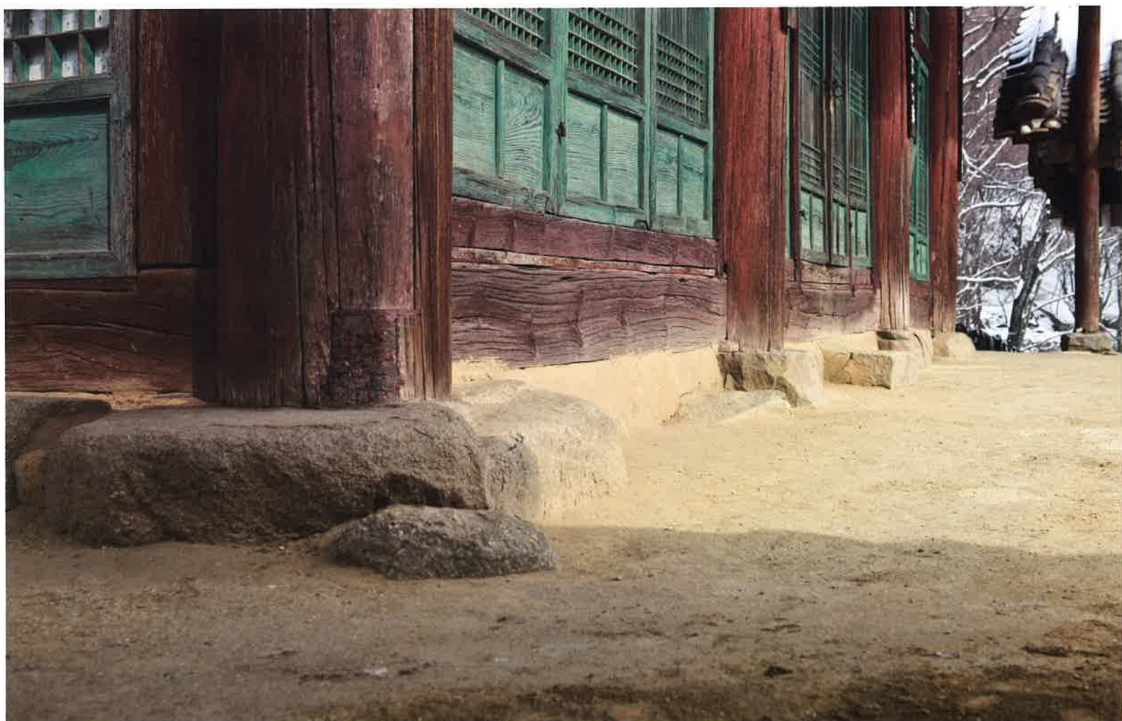
극락보전 앞면 주춧돌 / 極樂寶殿 前面 礎石 / front plinths, Kūngnakpojŏn hall
