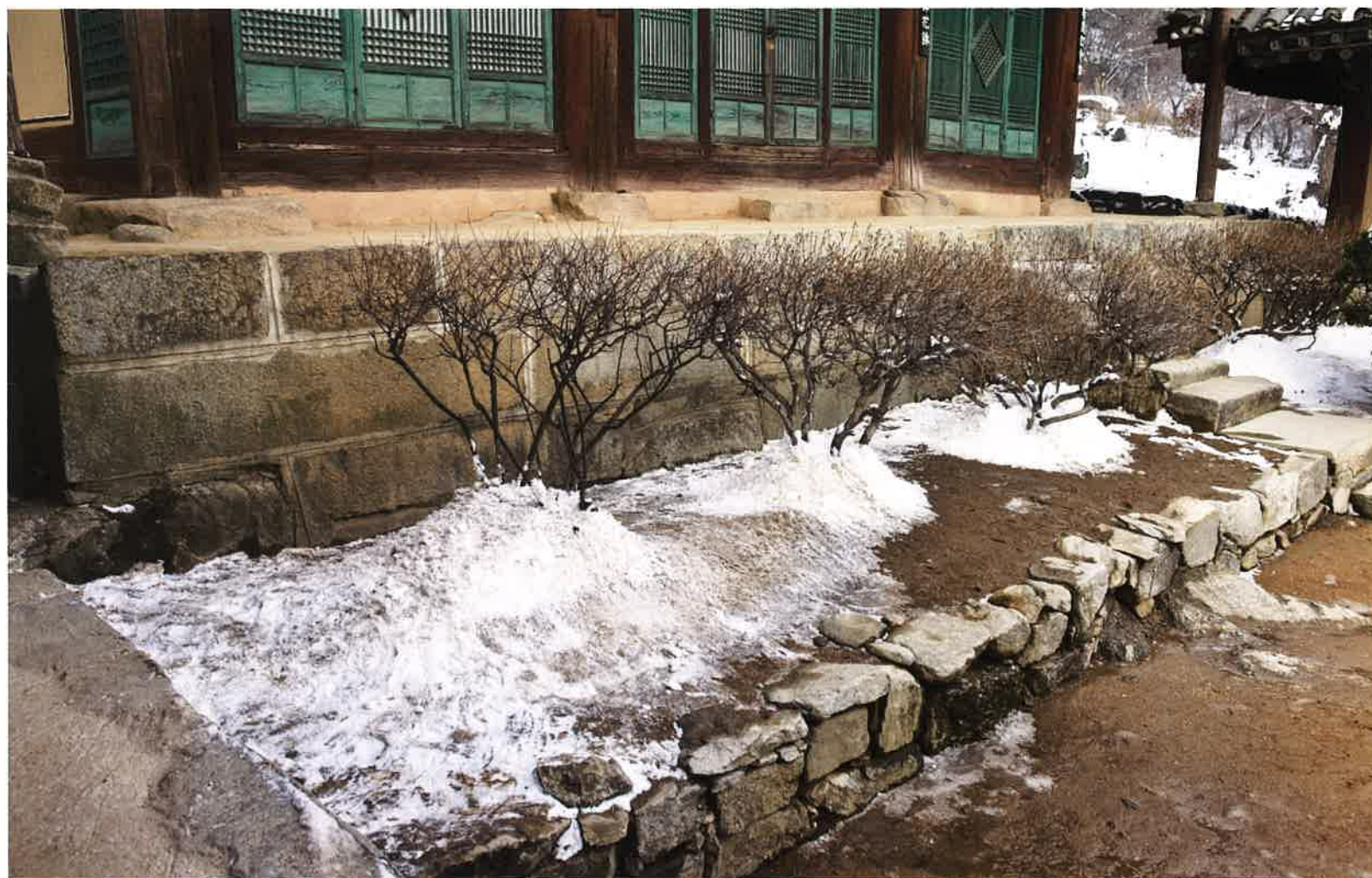
극락보전 앞면 기단 / 極樂寶殿 前面 基壇 / front stylobate, Kūngnakpojŏn hall
