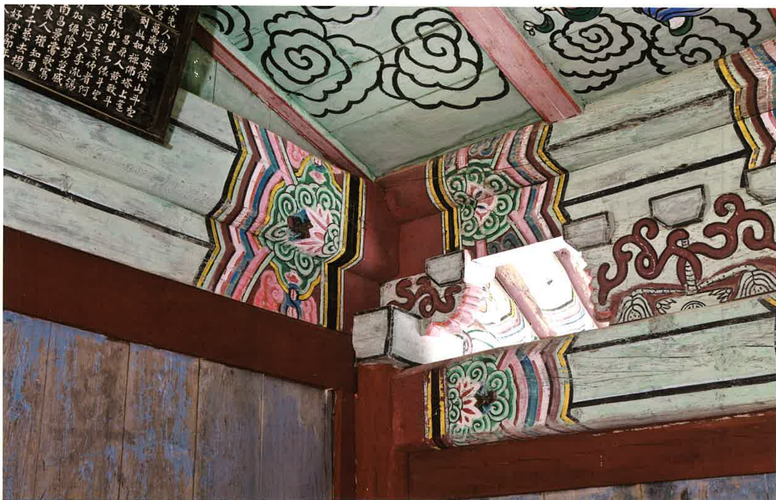
만세루 내부 귀포 / 萬歲樓 內部 耳包 / corner brackets, Manseru
