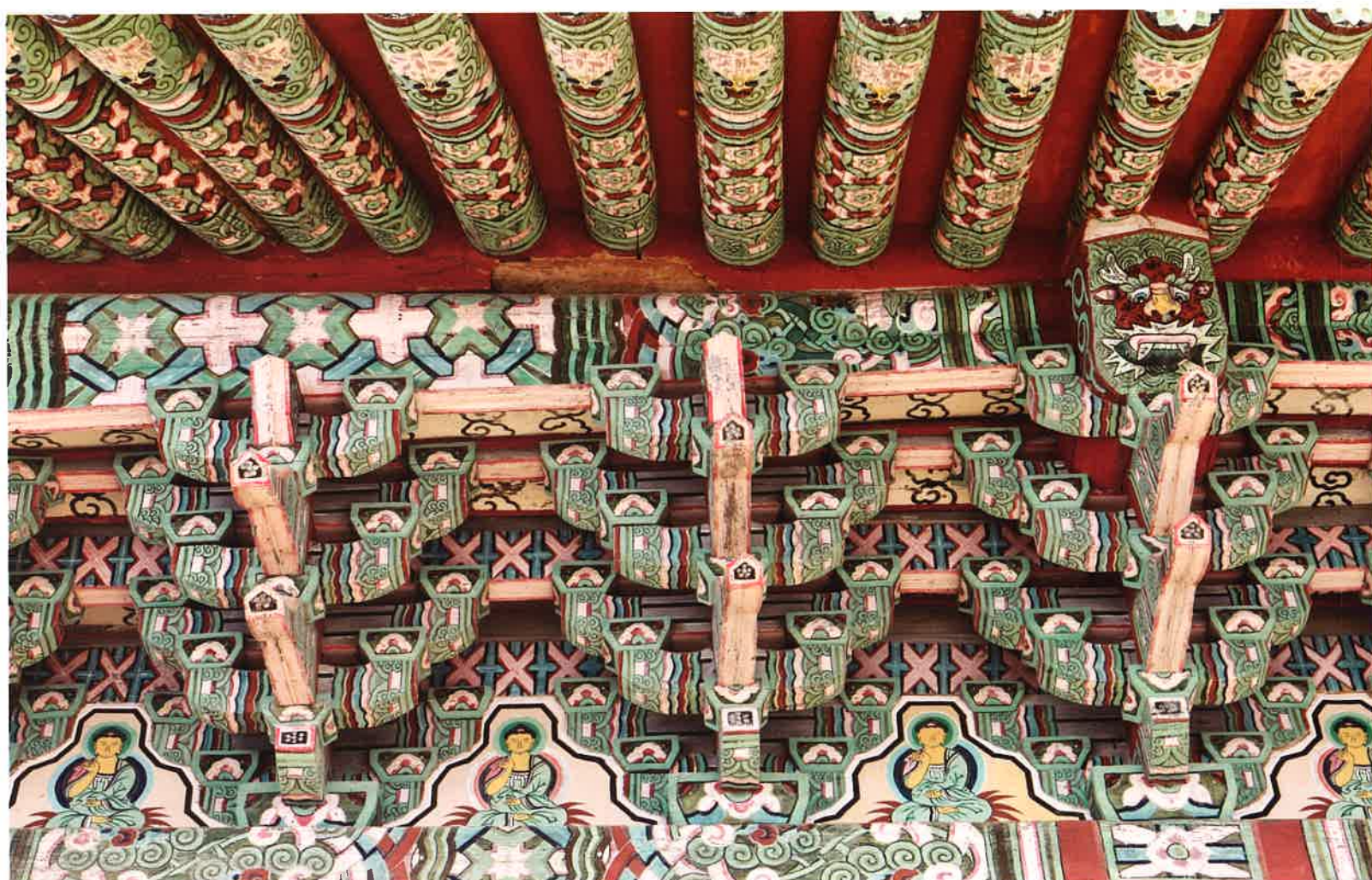
극락보전 앞면 공포 1 / 極樂寶殿 前面 棋包 1 / front brackets 1, Kūngnakpojón hall
