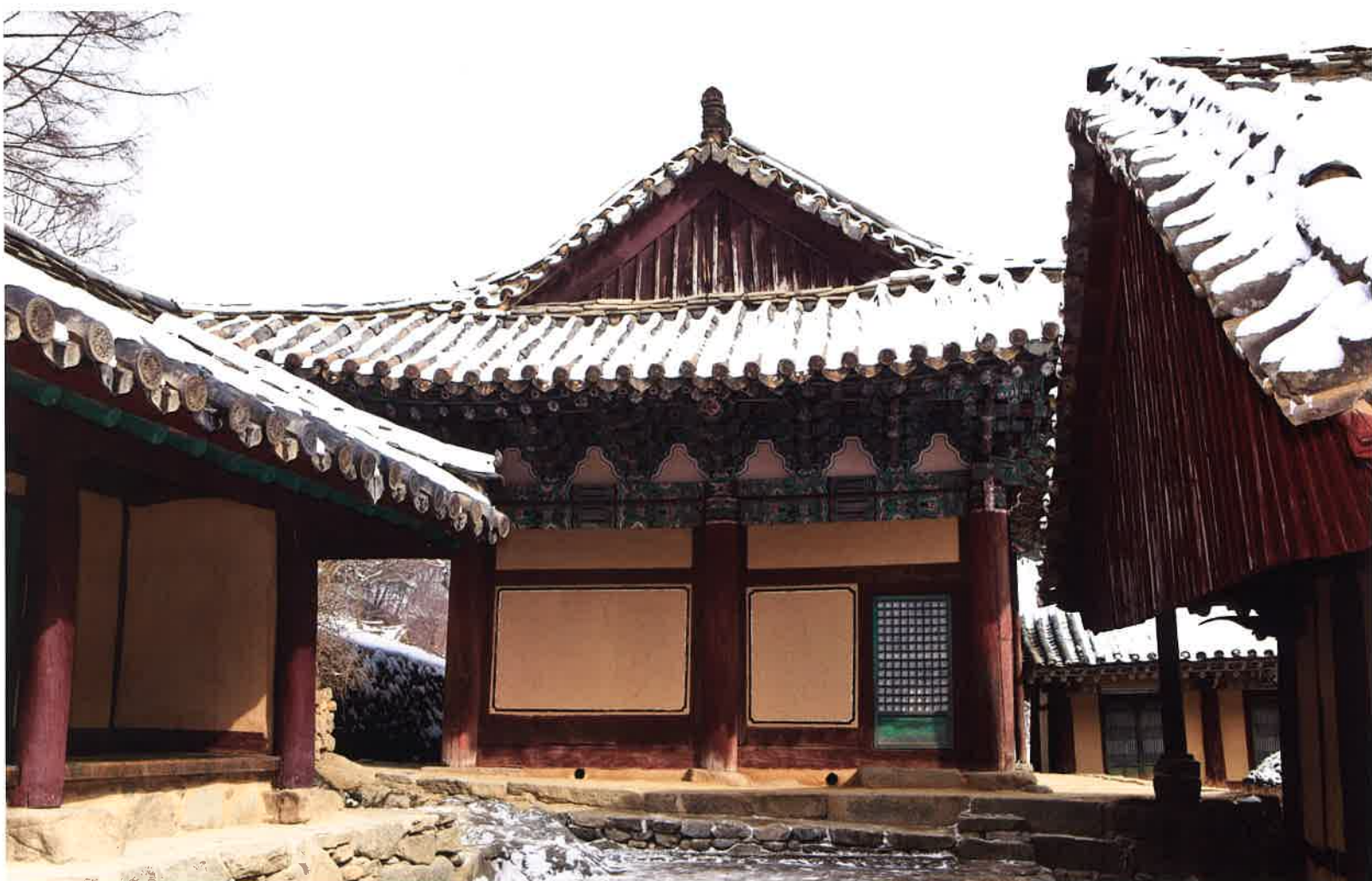
극락보전 서쪽 측면 / 極樂寶殿 西側面 / western side, Kŭngnakpojŏn hall
