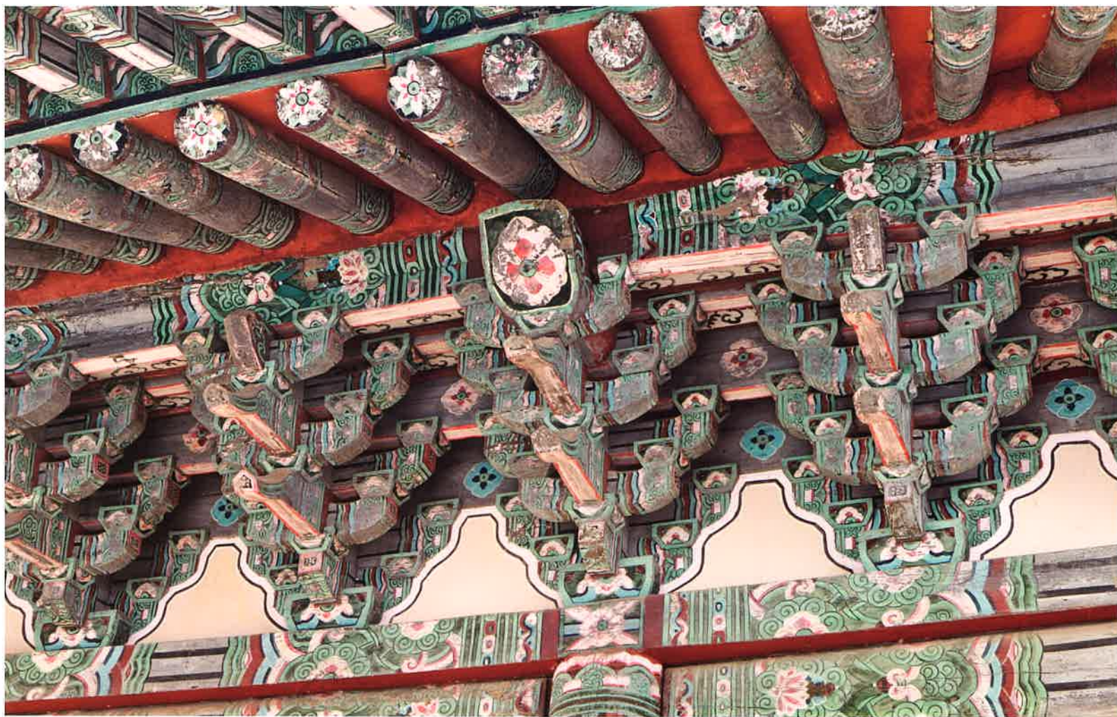
극락보전 서쪽 측면 주상포 / 極樂寶殿 西側 柱上包 / brackets above western columns, Kŭngnakpojŏn hall
