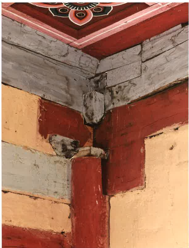
수월당 내부 귀포 1 / 水月堂 內部 耳包 1 corner brackets 1, Suwöltang hall
