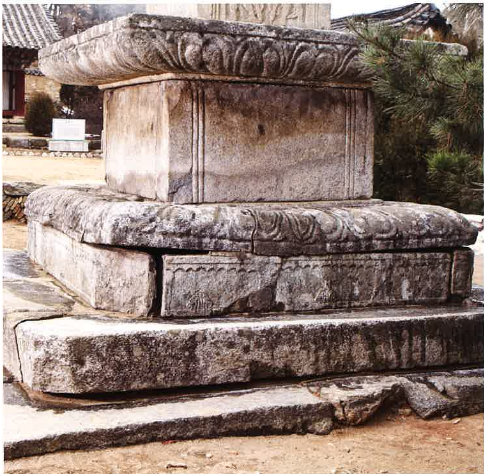
자혜사 5층석탑 기단 / 慈惠寺 五層石塔 基壇 stylobate of 5 storied stone pagoda, Chahyesa
