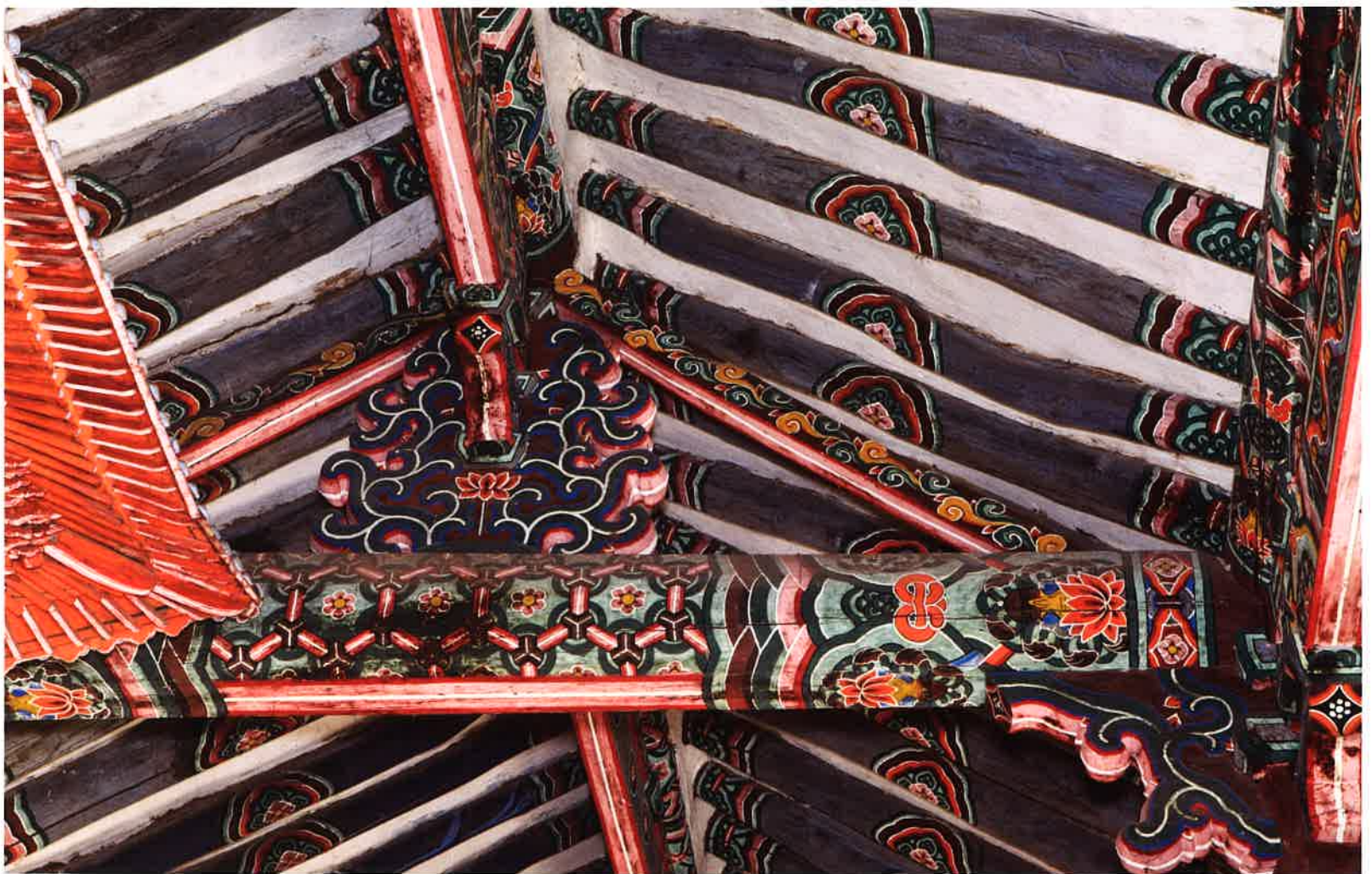
대웅전 내부 화반대공 / 大雄殿 內部 花盤大拱 / Hwaban brackets, Tacungjŏn hall
