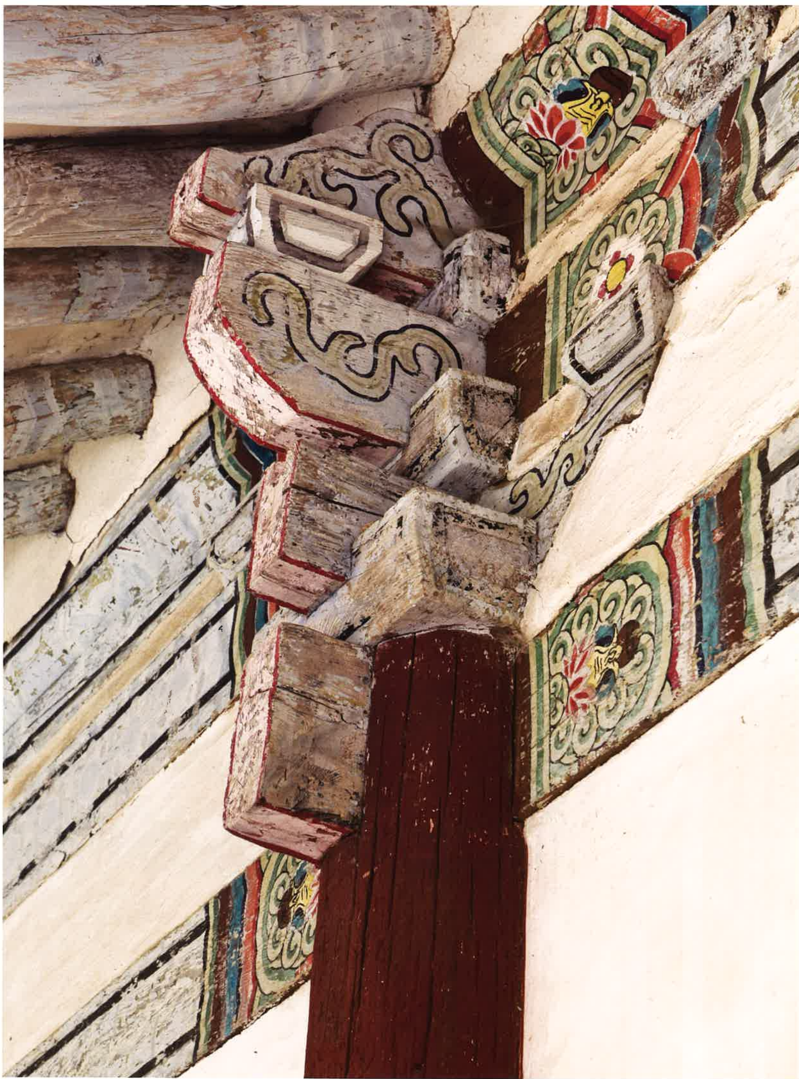
대웅전 뒷면 주상포 / 大雄殿 後面 柱上包 / brackets above backward columns, Taeungjön hall
