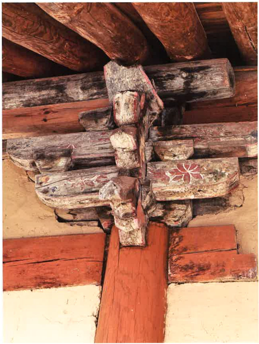
백화전 동쪽 측면 주상포 / 白華殿 東側 柱上包 brackets above eastern columns, Paekhwajon hall
