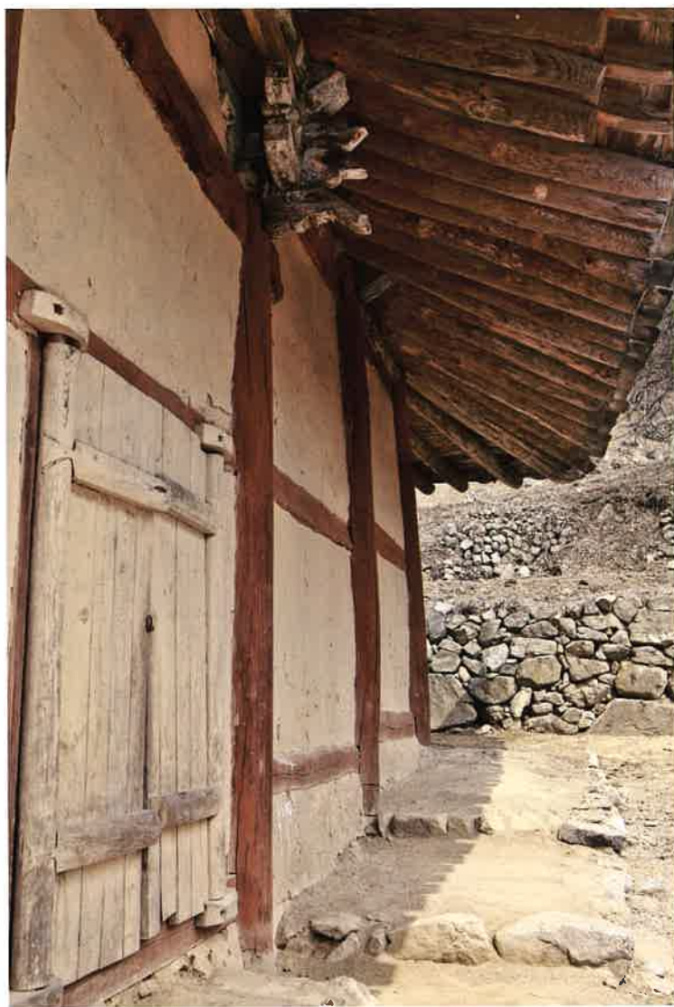
백화전 동쪽 측면 처마와 기둥 / 白華殿 東側 軒·平柱 eastern eaves and columns, Paekhwajon hall
