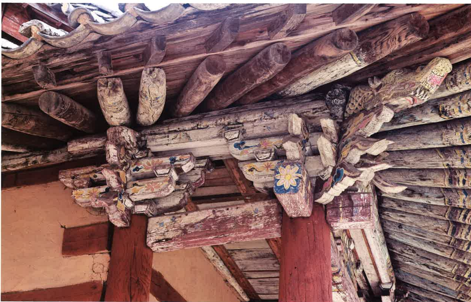
백화전 서쪽 측면 귀포 / 白華殿 西側 耳包 / western corner brackets, Paekhwajon hall
