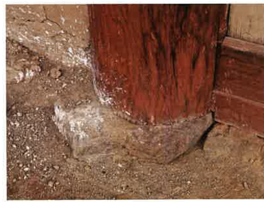
백화전 주춧돌 / 白華殿 礎石 / plinths, Paekhwajon hall
