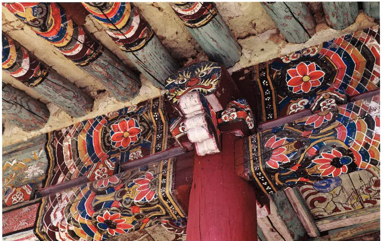
극락전 앞면 주상포 / 極樂殿 前面 柱上包 / brackets above front columns, Kŭngnakjŏn hall
