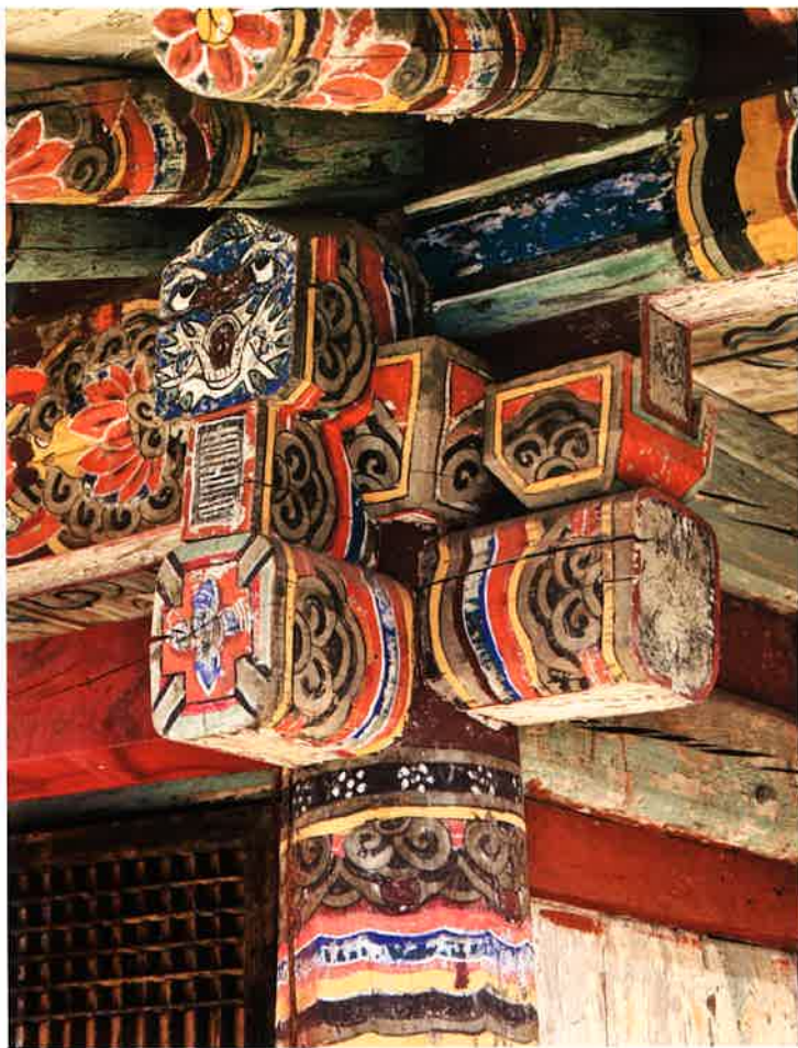
칠성각 귀포 / 七星閣 耳包 / corner brackets, Ch'ilsonggak
