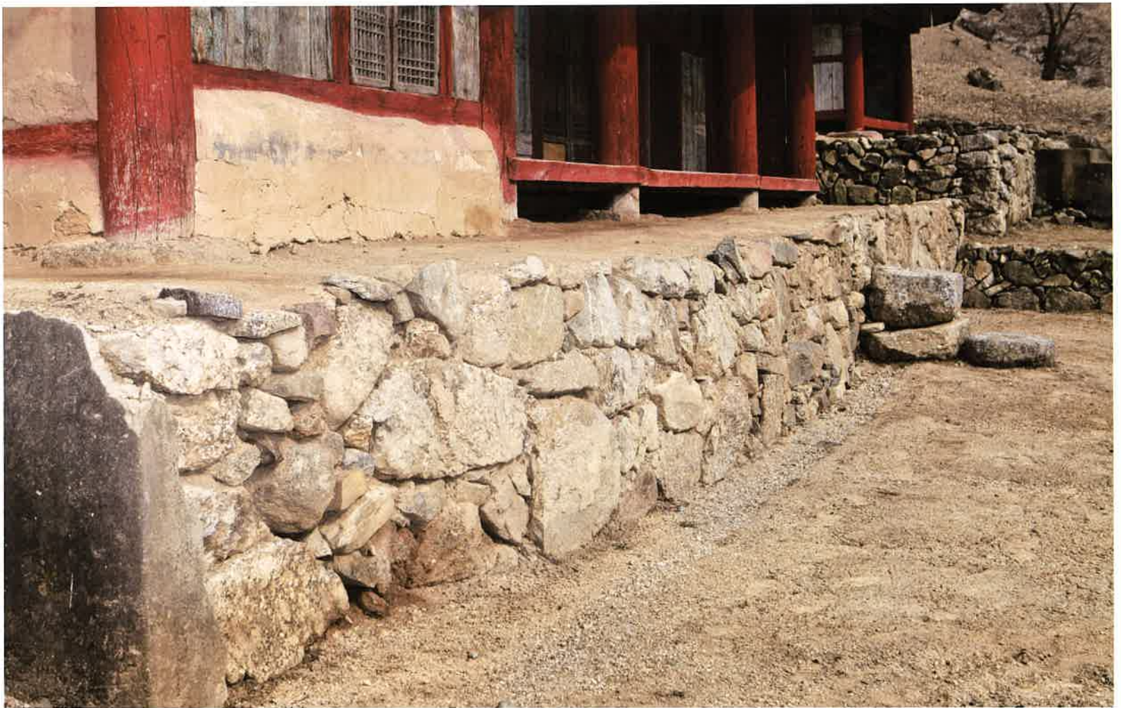
극락전 앞면 기단 / 極樂殿 前面 基壇 / front stylobate, Kūngnakjŏn hall
