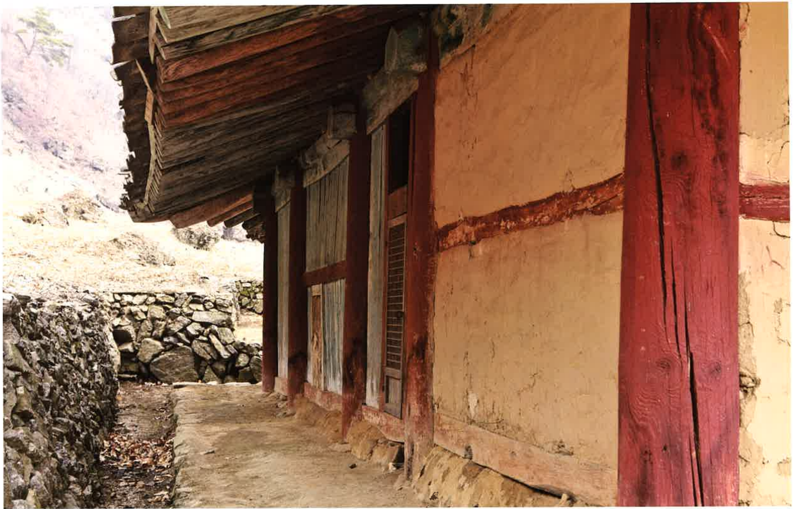
극락전 뒷면 처마와 기둥 / 極樂殿 後面 軒·平柱 / backward eaves and columns, Kūngnakjŏn hall
