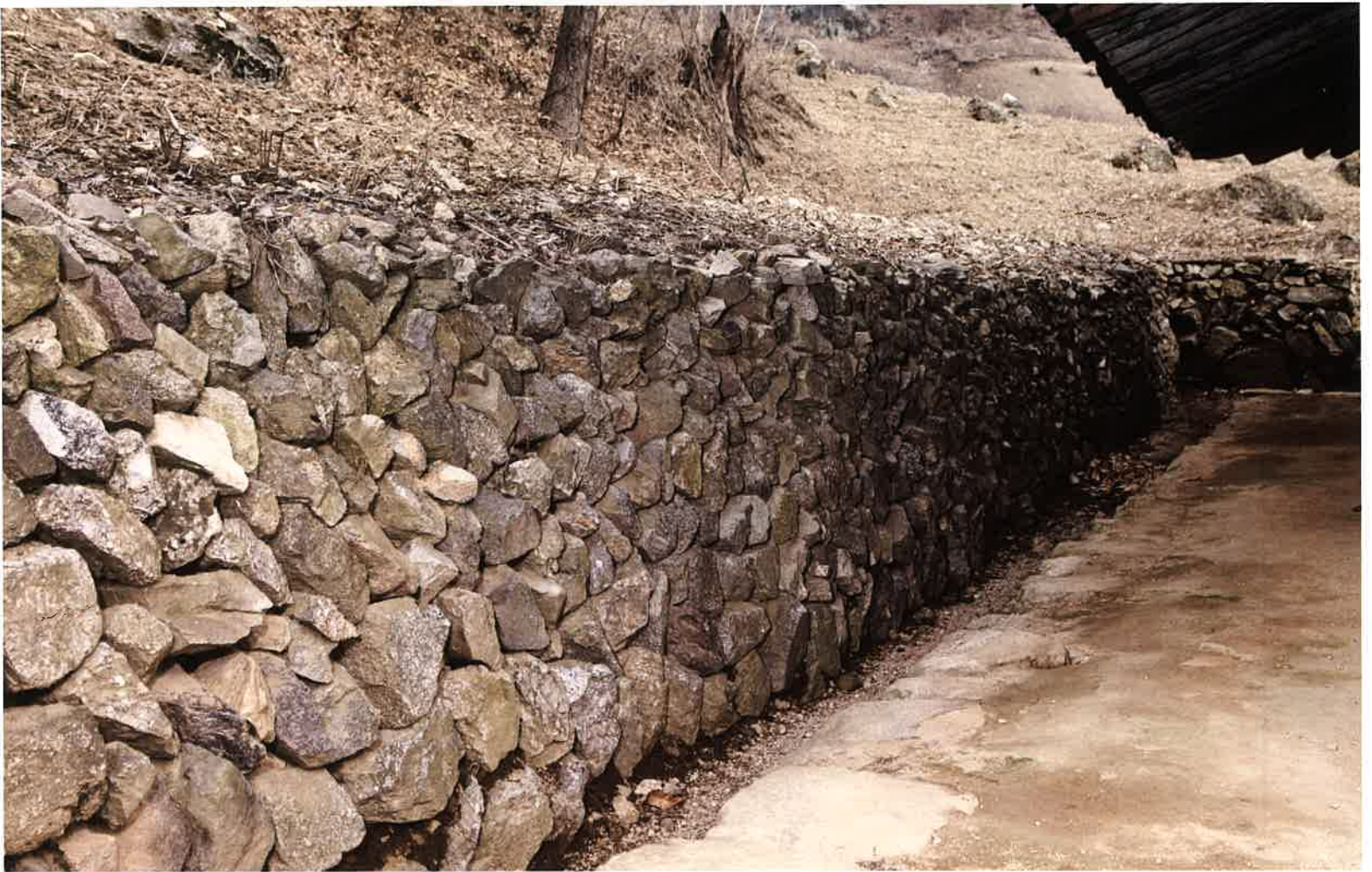
극락전 뒷면 석축 / 極樂殿 後面 石築 / backward stone works, Kūngnakjŏn hall
