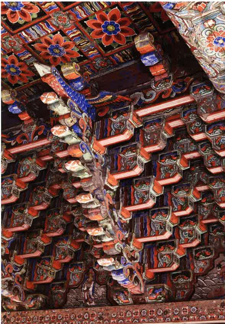
대웅전 내부 앞면 주간포 / 大雄殿 內部 前面 柱間包 brackets between front columns, Taeungjeon hall
