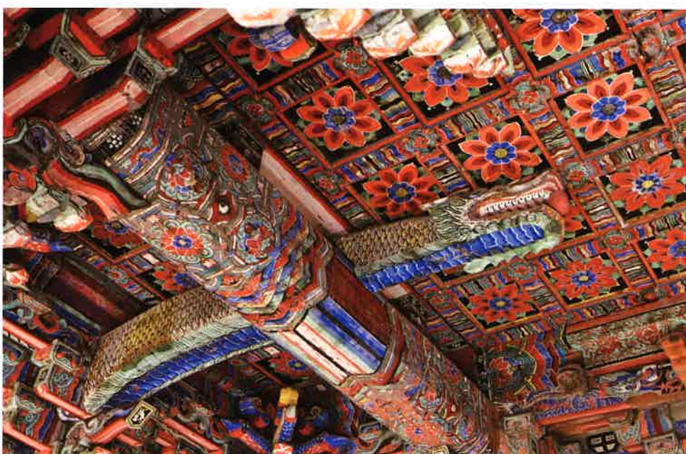
대웅전 대들보와 충량 / 大雄殿 大樑·衡樑 / main beam and measuring beam, Taeungjeon hall
