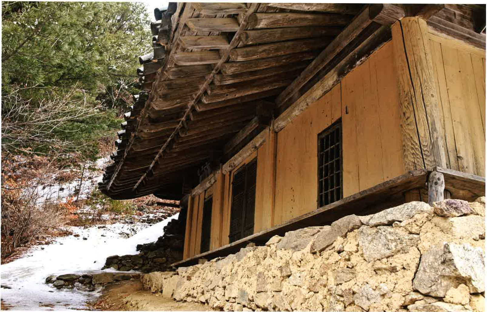
명월방 뒷면 처마와 벽체 / 明月房 後面 軒・壁體 / backward eaves and wall, Myōngwŏlbang
