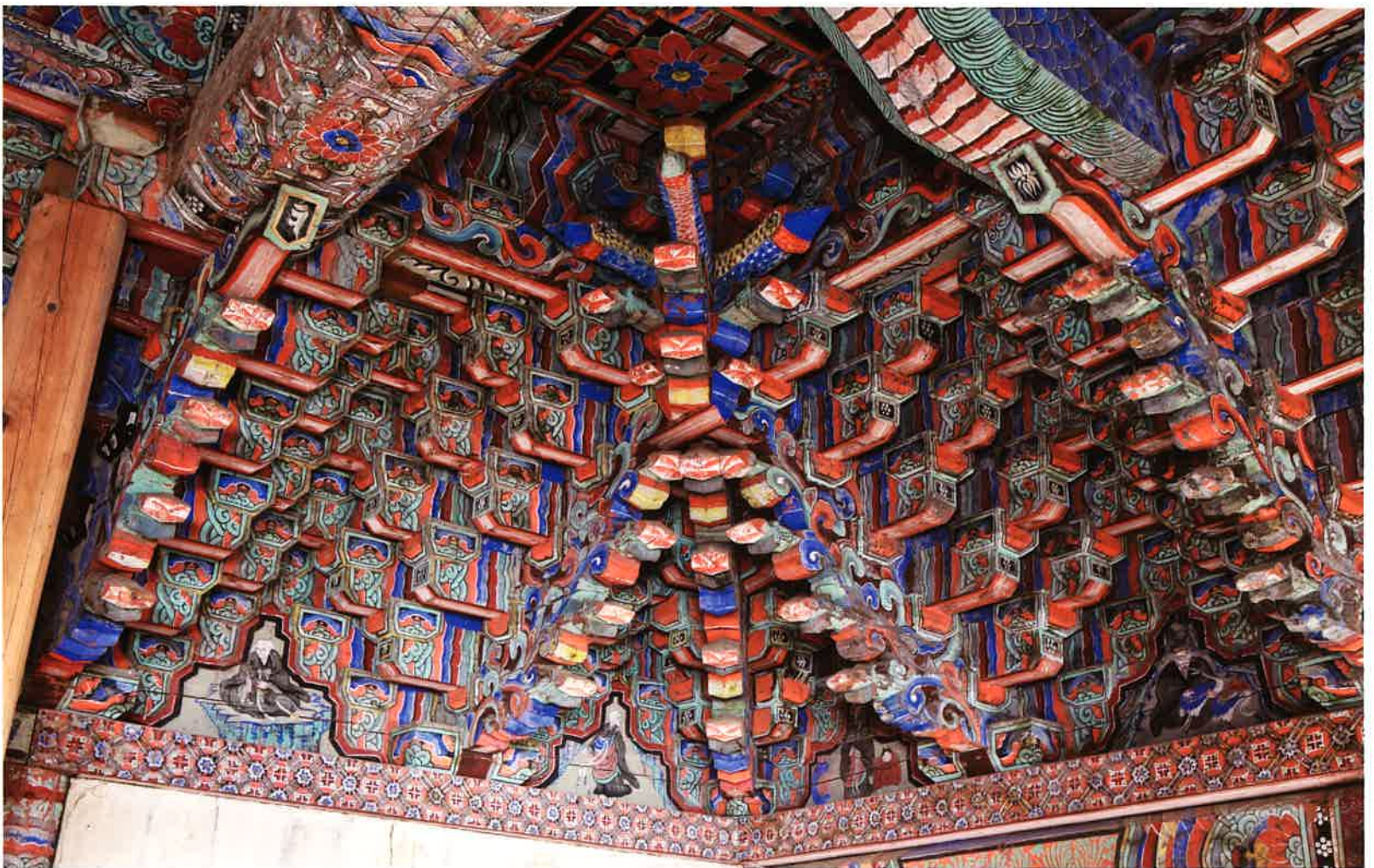
대웅전 내부 뒷면 동쪽 귀포 / 大雄殿 內部 後面 東側 耳包 / backward eastern corner brackets, Taeungjeon hall
