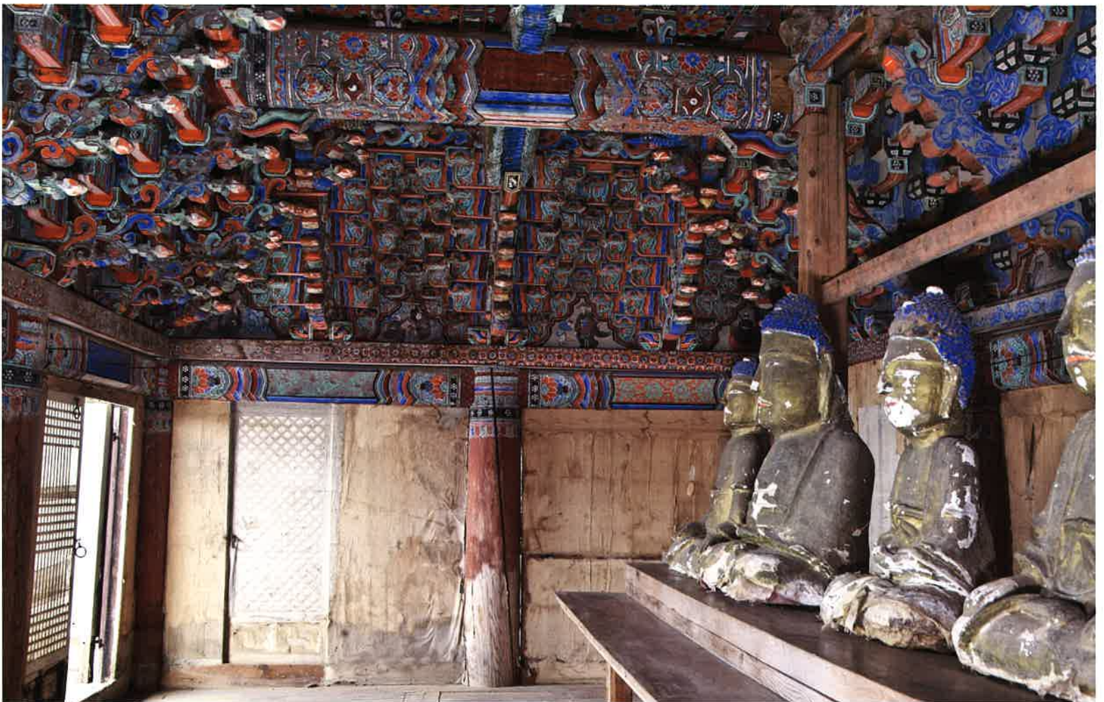
대웅전 내부 서쪽 벽체와 공포 / 大雄殿 內部 西側 壁體·棋包 / western wall and brackets, Taeungjŏn hall
