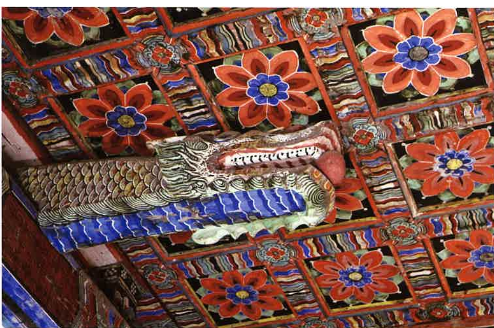
대웅전 충량 용수 / 大雄殿 衡樑 龍首 / dragon head on measuring beam, Taeungjeon hall
