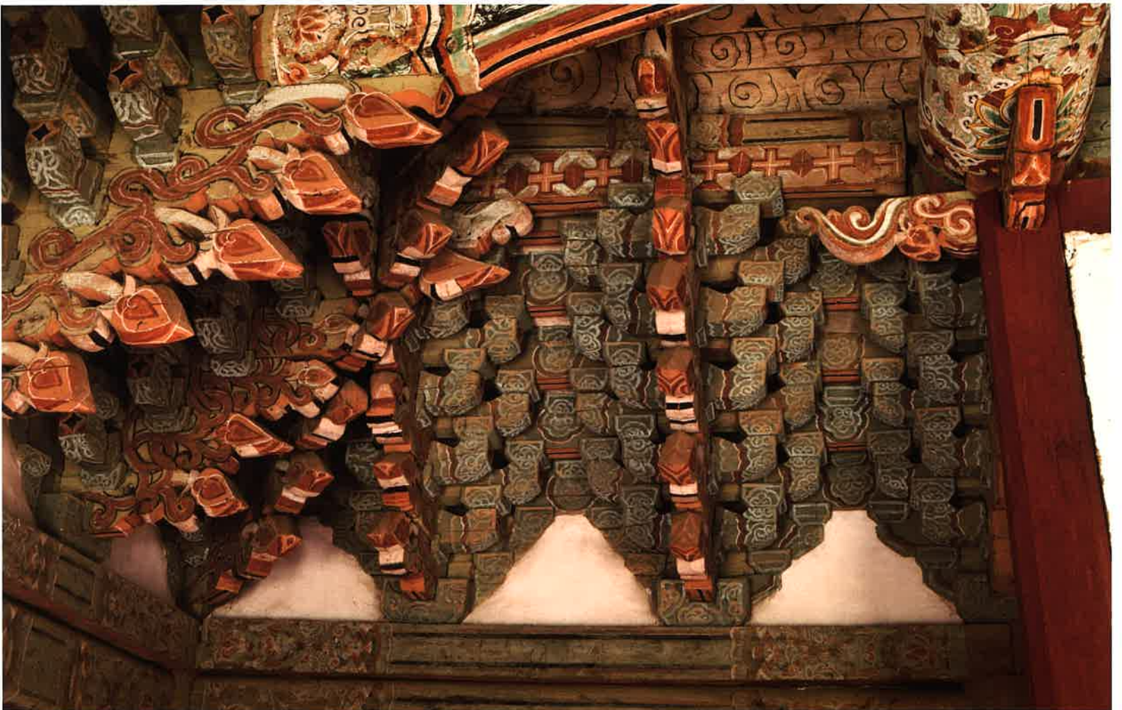
대웅전 내부 뒷면 서쪽 주간포 / 大雄殿 內部 後面 西側 柱間包 / backward western brackets between columns, Taeungjeon hall
