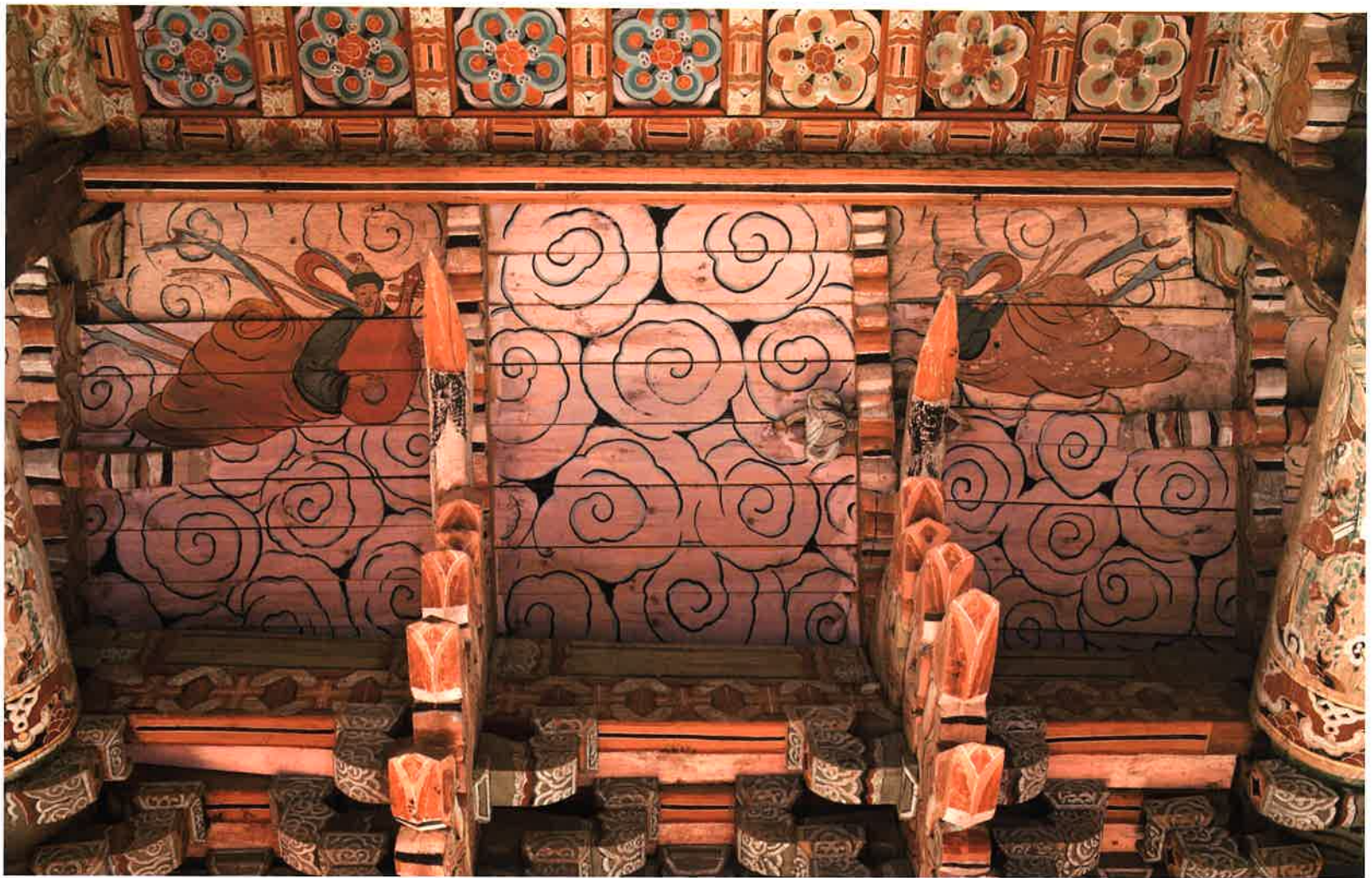
대웅전 내부 빗반자 / 大雄殿 内部 斜天障 / inclined ceiling, Taeungjeon hall
