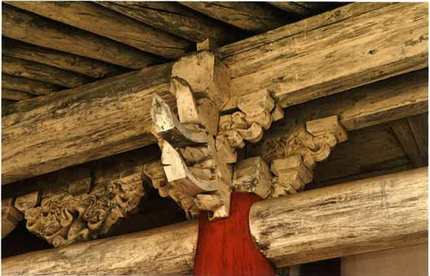
무량수전 앞면 주상포 / 無量壽殿 前面 柱上包 brackets above front columns, Muryangsujön hall
