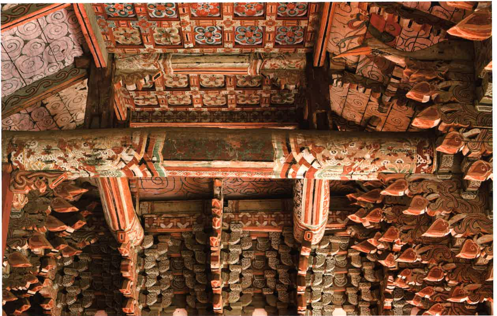
대웅전 내부 대들보와 종보 / 大雄殿 內部 大樑·宗樑 / main beam and collarbeam, Taeungjeon hall
