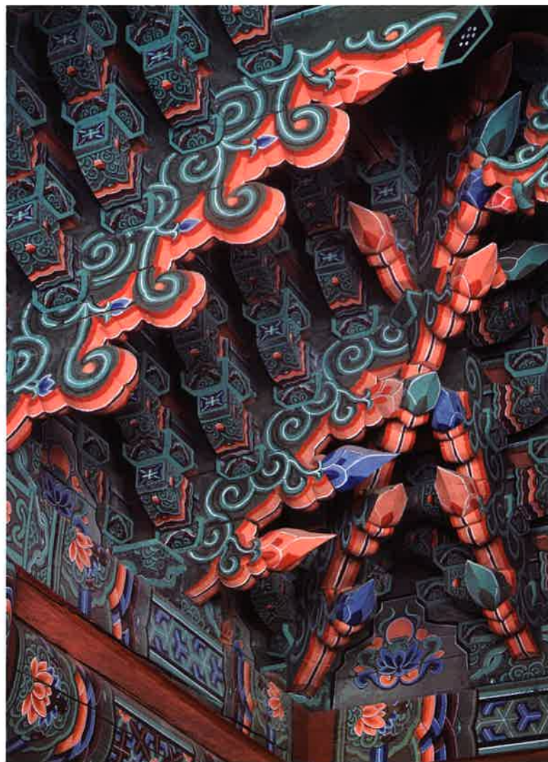
대웅전 내부 뒷면 서쪽 귀포 / 大雄殿 內部 後面 西側 耳包 backward corner brackets, Taeungjŏn hall
