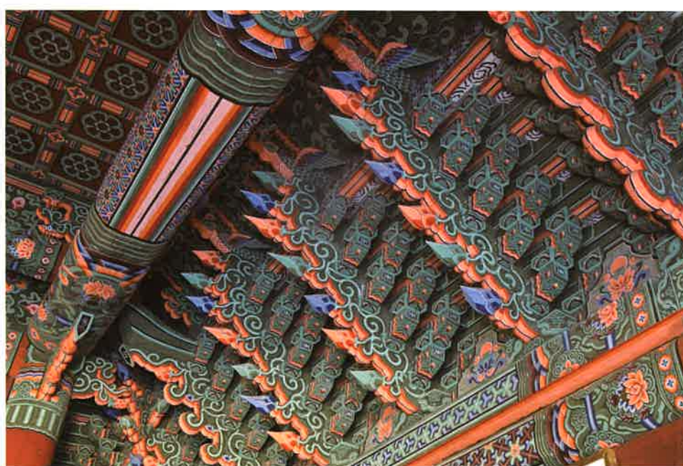
대웅전 내부 동쪽 측면 공포 / 大雄殿 内部 東側 拱包 eastern brackets, Taegungjon hall
