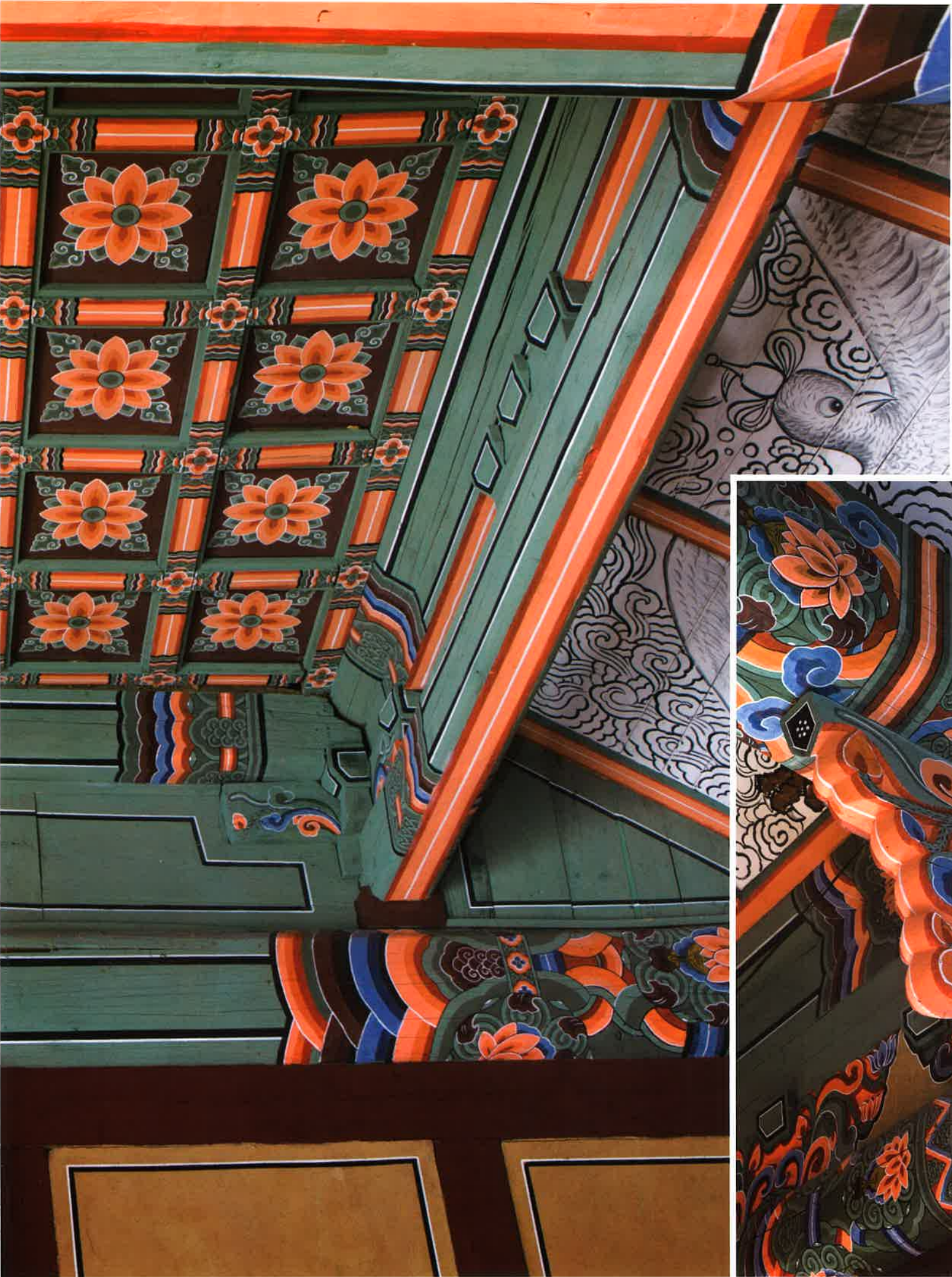
명부전 내부 남쪽 액방과 소란반자 / 冥府殿 內部 南側 額枋·格子天障 southern lintel and latticed ceiling, Myongbujon hall
