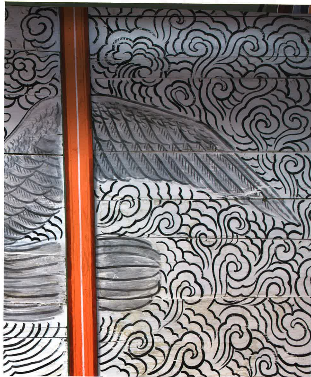
명부전 내부 빗반자 별화 2 / 冥府殿 内部 斜天障 別畫 2 attached painting 2 on inclined ceiling, Myongbujon hall
