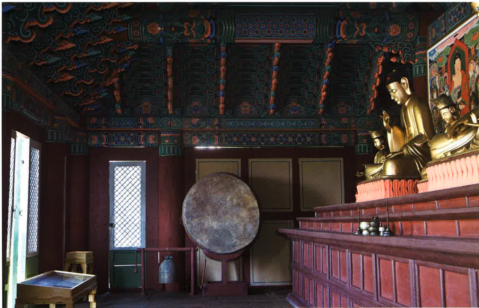
대웅전 내부 서쪽 측면 벽체 / 大雄殿 內部 西側 壁體 / western wall, Taegungjeon hall
