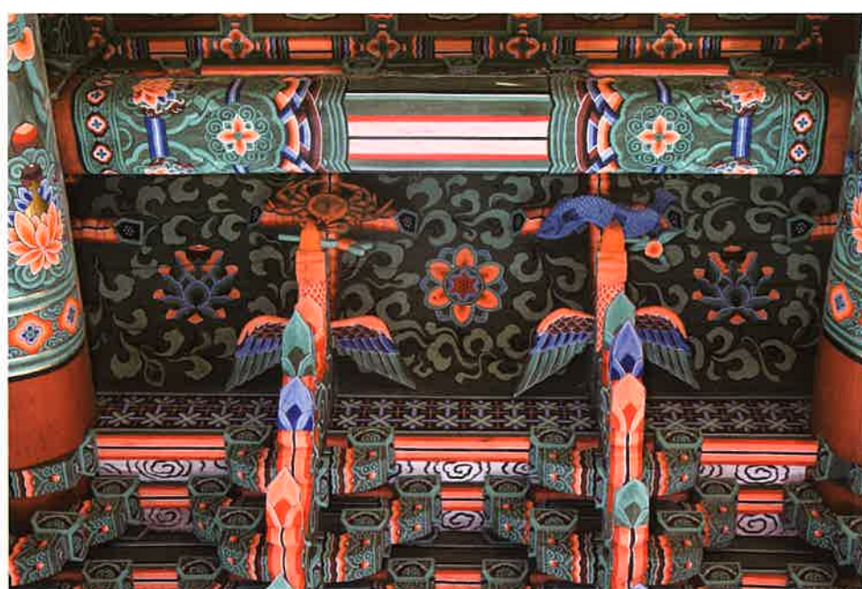
대웅전 내부 앞면 공포 / 大雄殿 内部 前面 拱包 front brackets, Taegungjon hall
