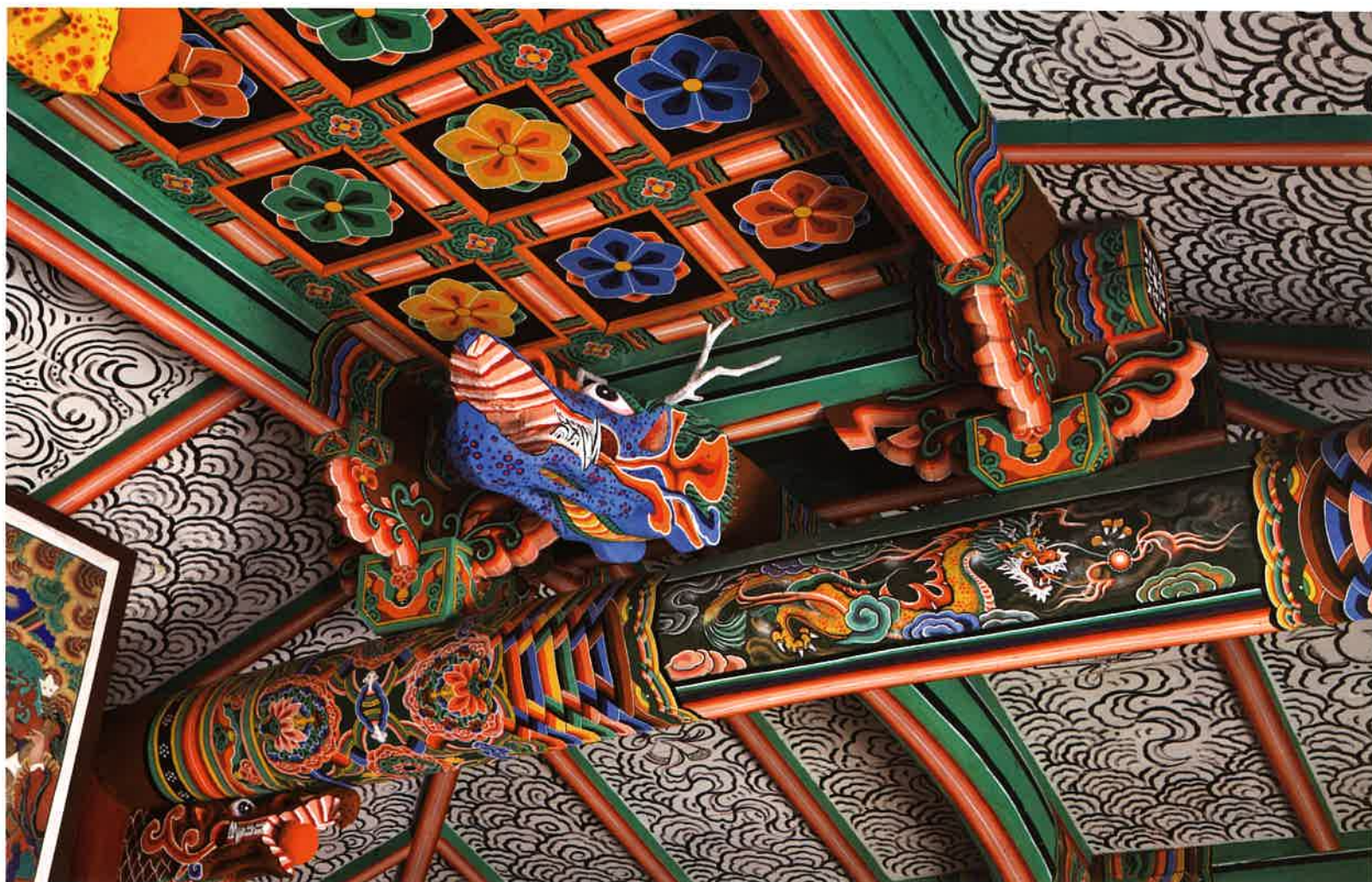
대웅전 내부 대들보와 종보 / 大雄殿 大樑·宗樑 / main beam and collarbeam, Taeungjeon hall
