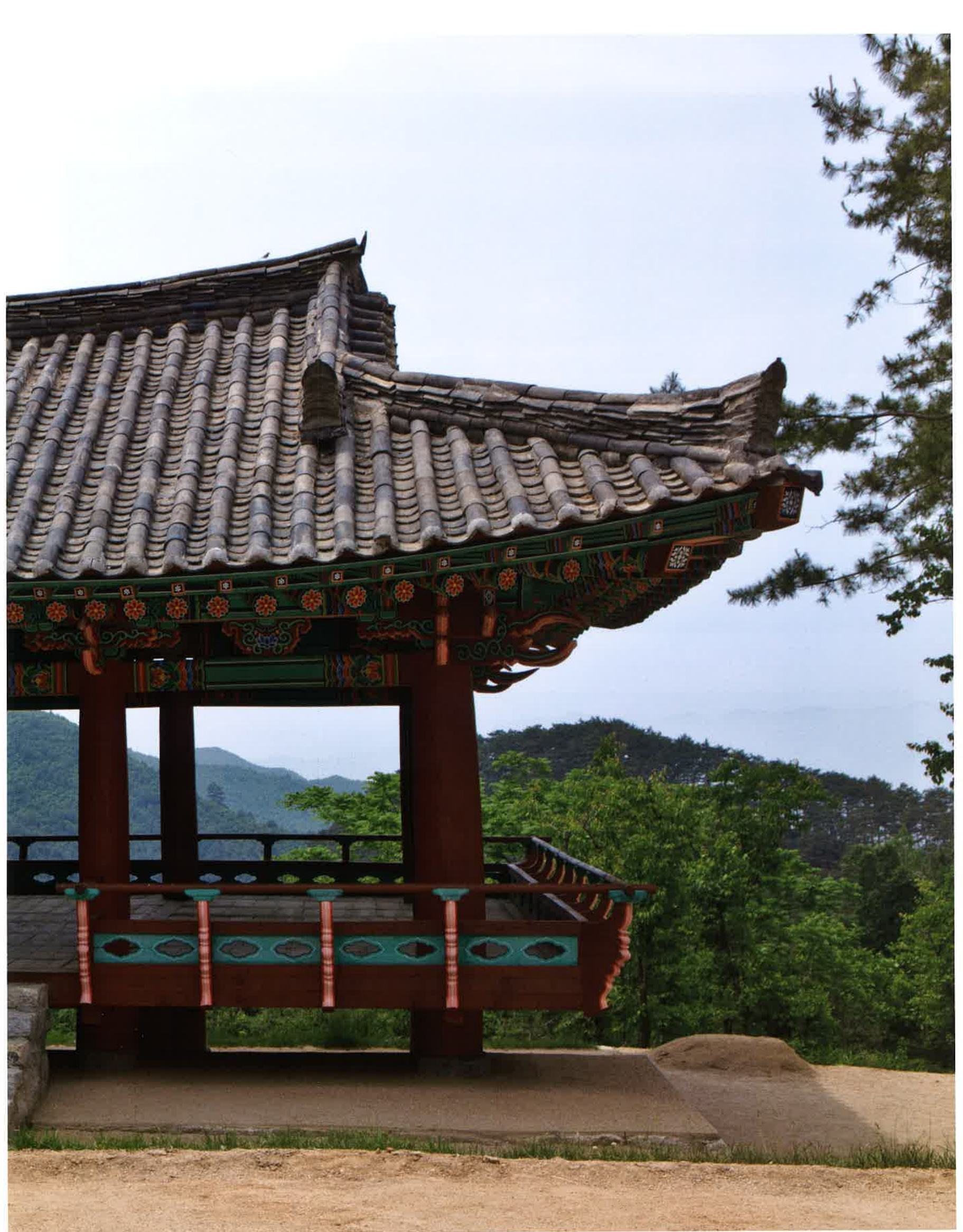
보광루 뒷면 전경 / 普光樓 後面 全景 / backward whole view, Pogwangnu
