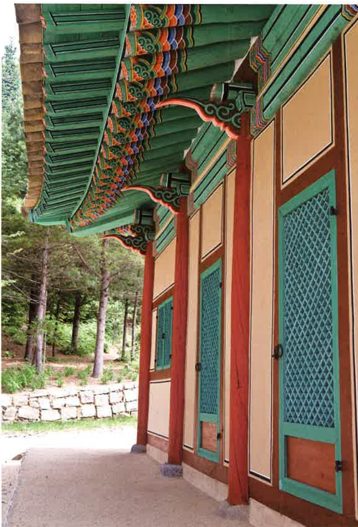
무량수각 서쪽 측면 처마와 기둥 / 無量壽閣 西側 軒·平柱 western eaves and columns, Muryangsugak hall
