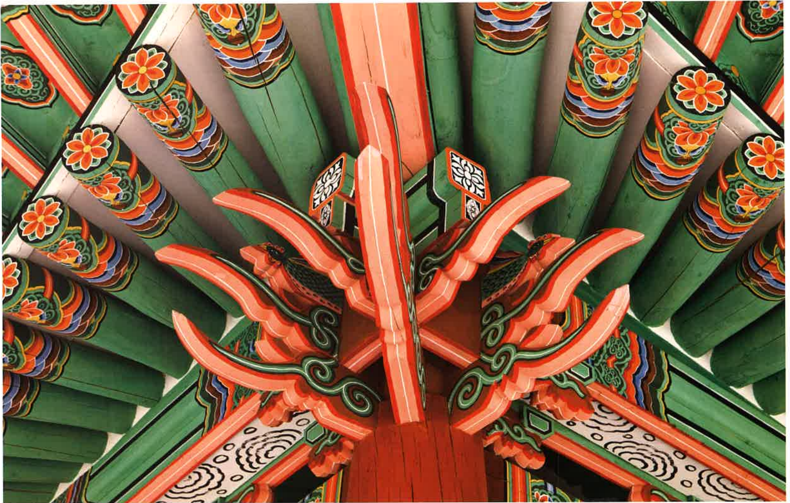
보광루 앞면 귀포 / 普光樓 前面 耳包 / front corner brackets, Pogwangnu
