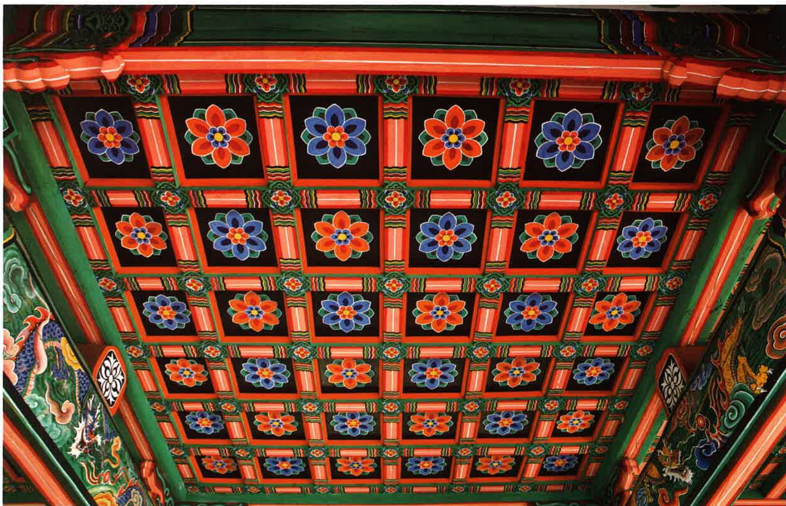
보광루 내부 소란반자 / 普光樓 格子天障 / latticed ceiling, Pogwangnu
