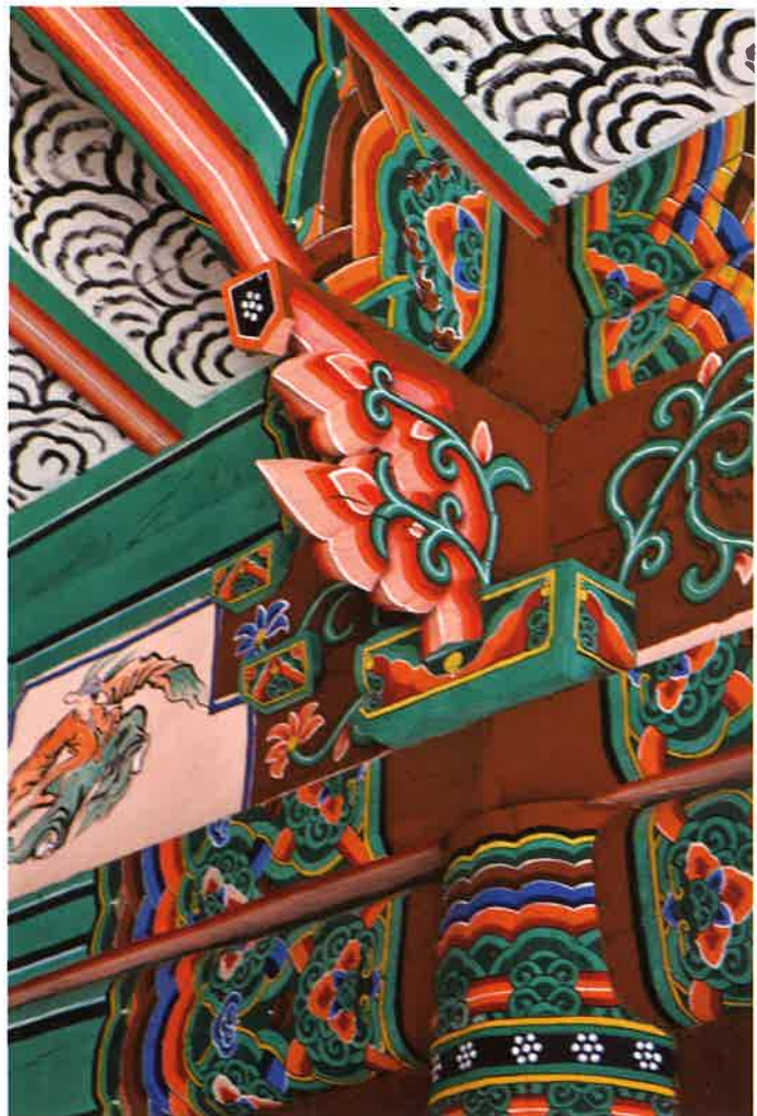
대웅전 내부 동쪽 주상포 / 大雄殿 內部 前面 柱上包 brackets above eastern columns, Taeungjön hall
