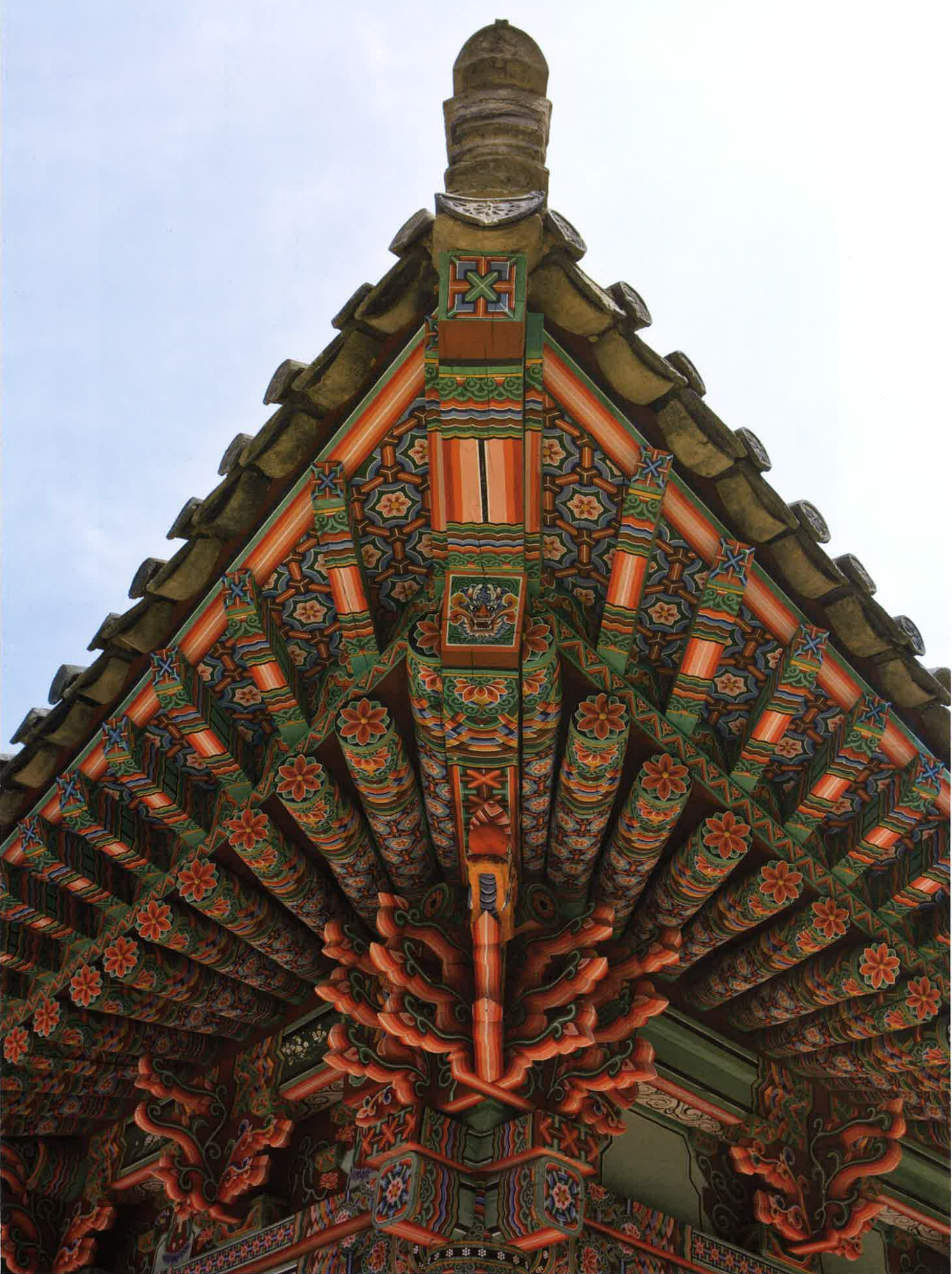
◀대웅전 앞면 기둥과 공포 / 大雄殿 前面 平柱·拱包 front columns and brackets, Taeungjŏn hall
