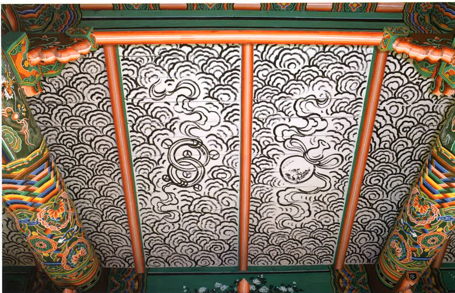
대웅전 내부 빗반자 1 / 大雄殿 斜天障 1 / inclined ceiling 1, Tacungjŏn hall
