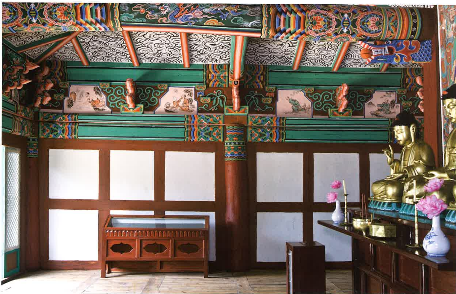
대웅전 내부 서쪽 측면 벽체 / 大雄殿 內部 西側 壁體 / western wall, Taeungjeon hall
