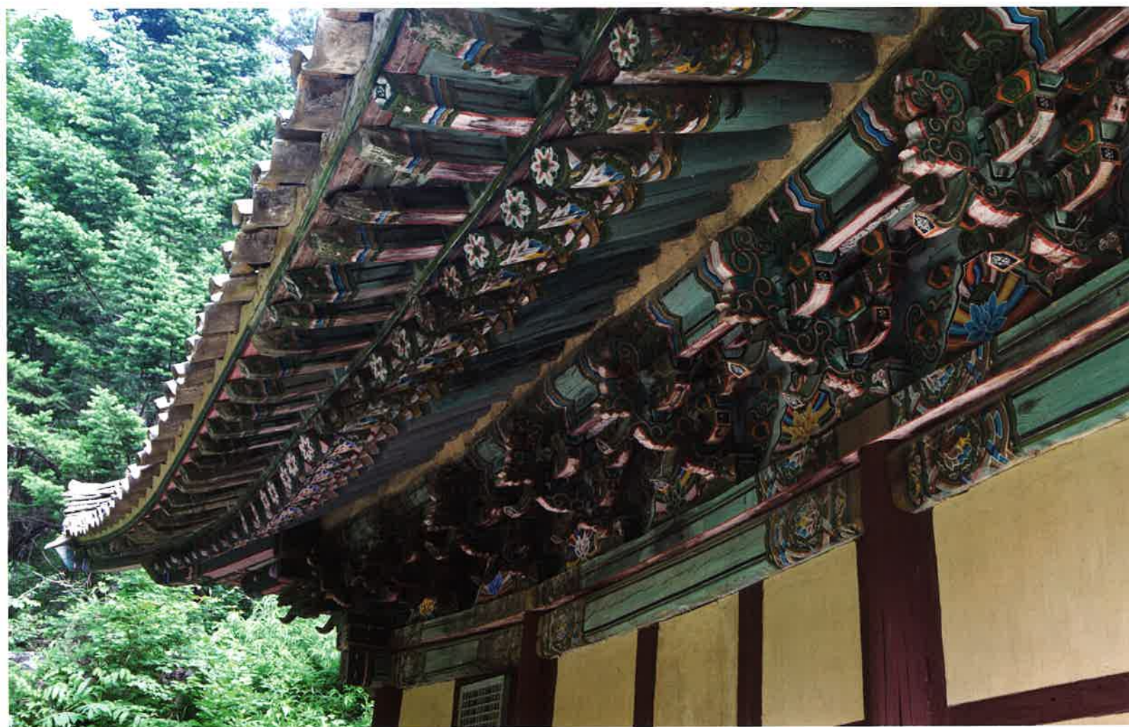
불지암 서쪽 측면 처마와 공포 / 佛地庵 西側 軒·栱包 / western eaves and brackets, Puljiam
