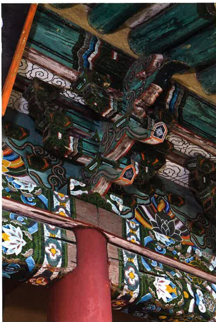
불지암 앞면 주상포 / 佛地庵 前面 柱上包 brackets above front columns, Puljiam
