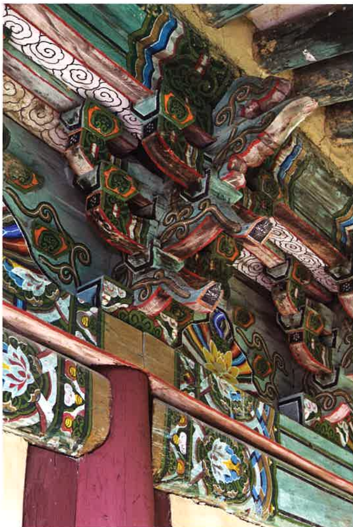
불지암 동쪽 측면 주상포 / 佛地庵 東側 柱上包 eastern brackets above columns, Puljiam
