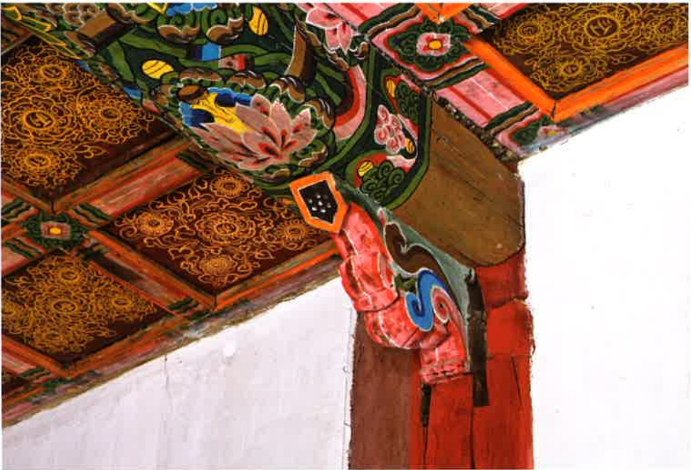
불지암 내부 주상포 / 佛地庵 內部 柱上包 / brackets above columns, Puljiam
