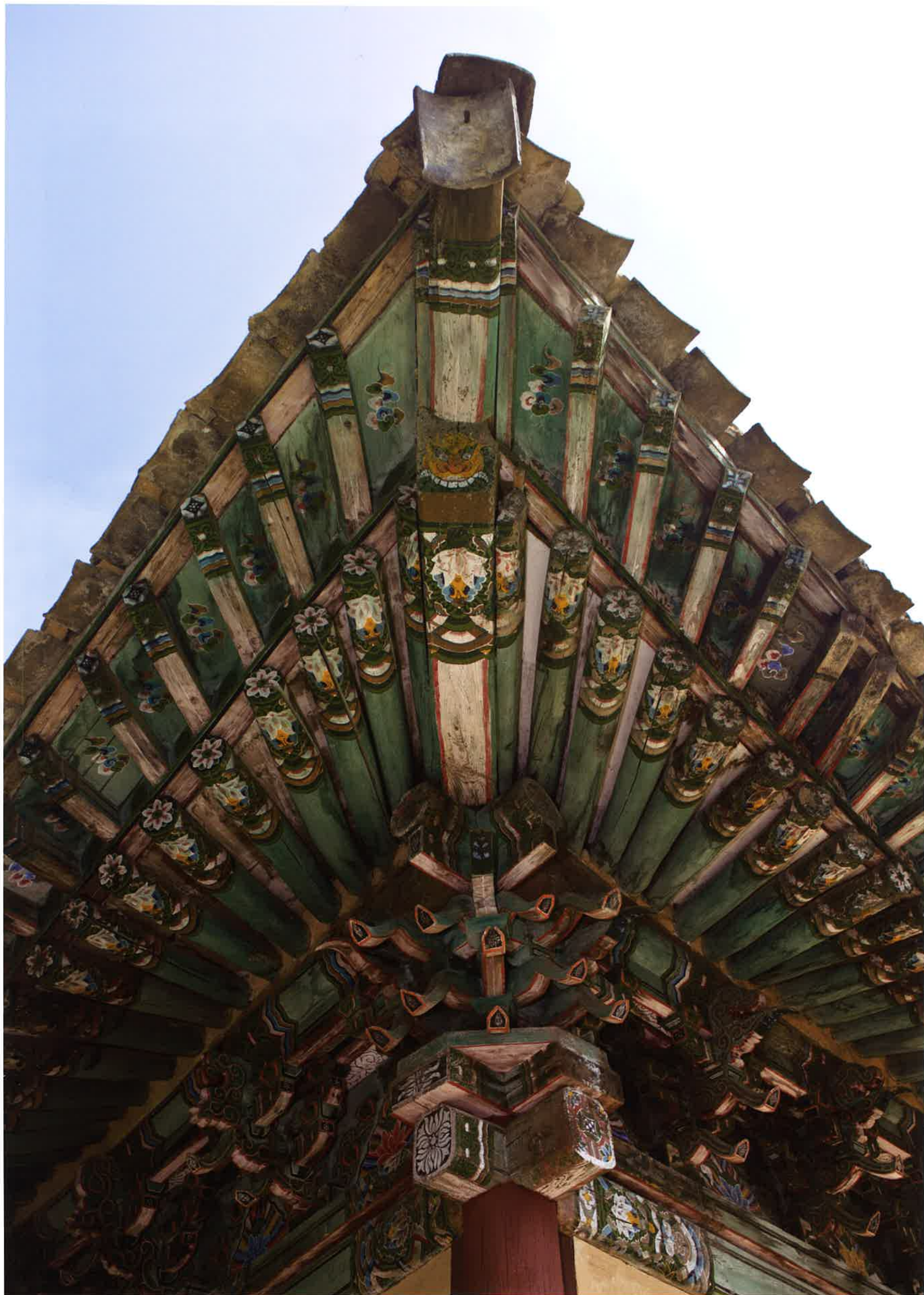
◀ 불지암 앞면 처마와 공포 / 佛地庵 全面 軒·拱包 front eaves and brackets, Pulji-temple
