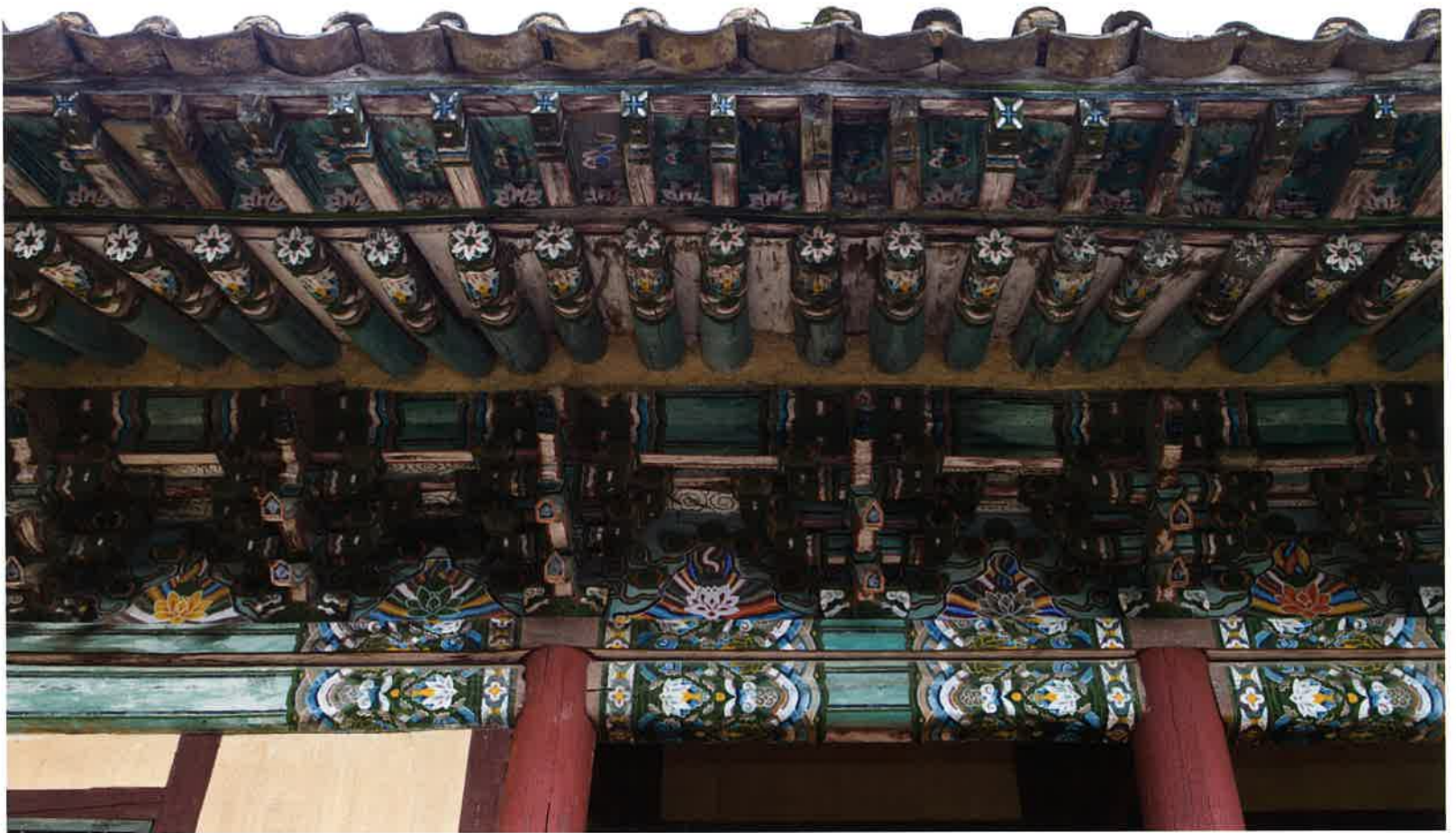
불지암 앞면 공포 / 佛地庵 全面 拱包 / front brackets, Puljiam
