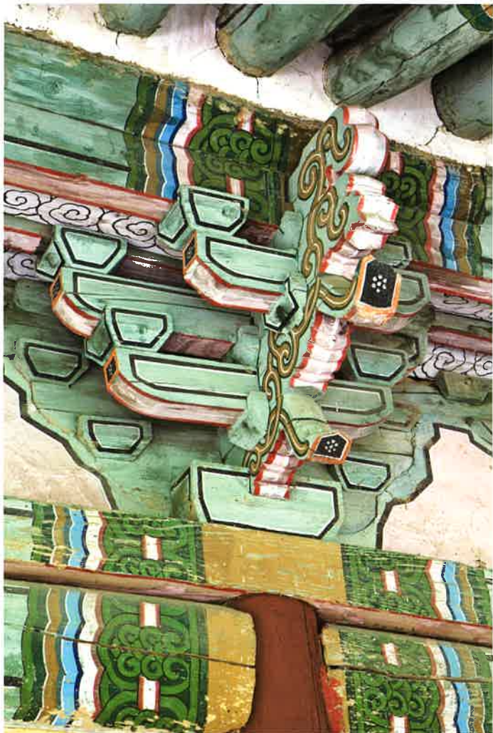
불지암 뒷면 주상포 / 佛地庵 後面 柱上包 brackets above backward columns, Puljiam
