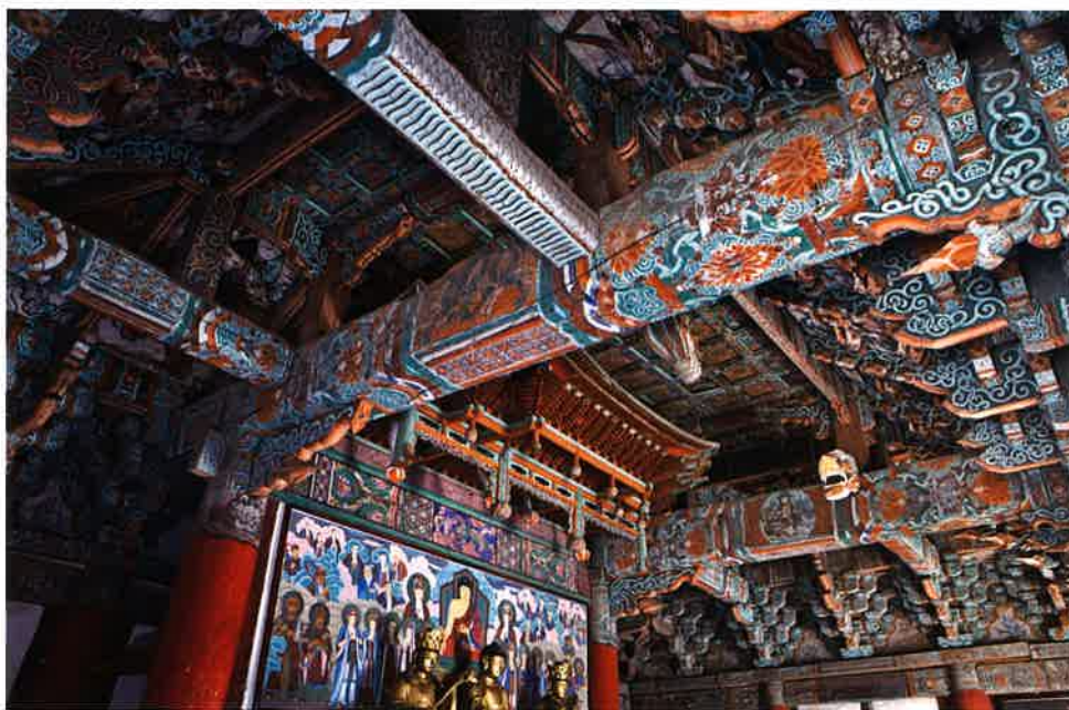
대웅전 내부 대들보와 반자 / 大雄殿 內部 大樑·天障 main beam and ceiling, Taeungjeon hall
