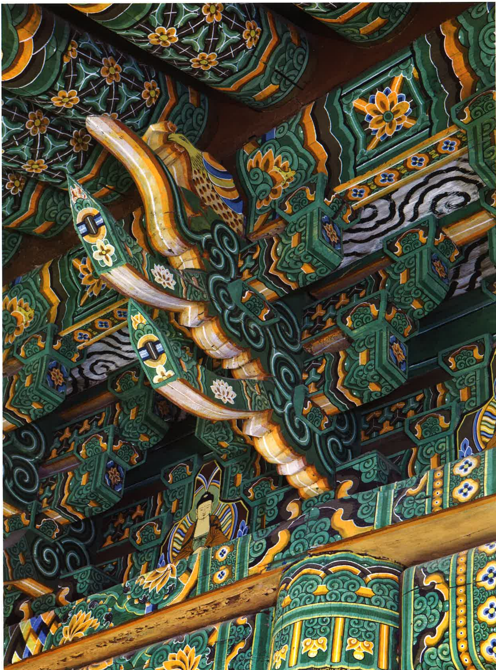
대웅전 앞면 주상포 / 大雄殿 前面 柱上包 / brackets above front columns, Taungjeon hall
