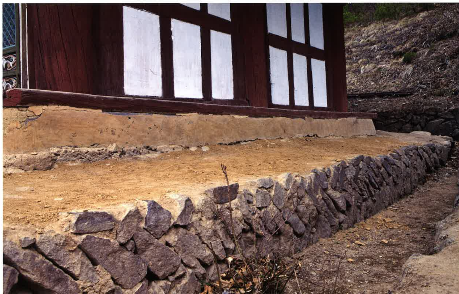
대웅전 측면 기단 / 大雄殿 側面 基壇 / side stylobate, Taegungjŏn hall
