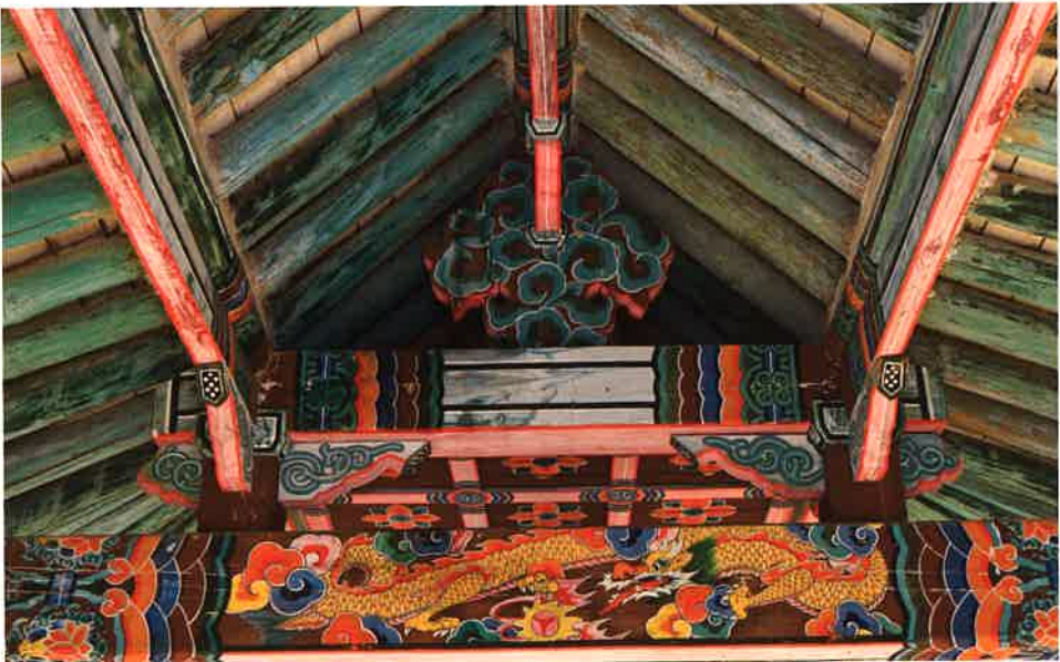
만세루 내부 대들보와 화반 / 萬歲樓 內部 大樑·花盤 / main beam and Hwaban, Manseru
