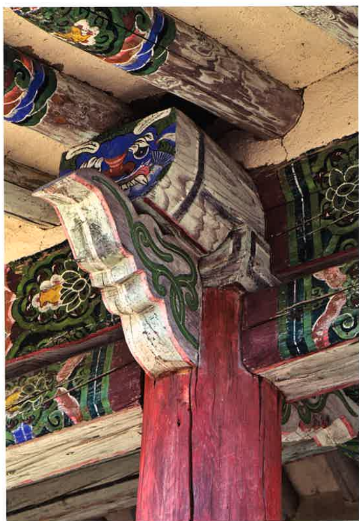
애월루 앞면 주상포 / 愛月樓 前面 柱上包 / brackets above front columns, Aewöllu
