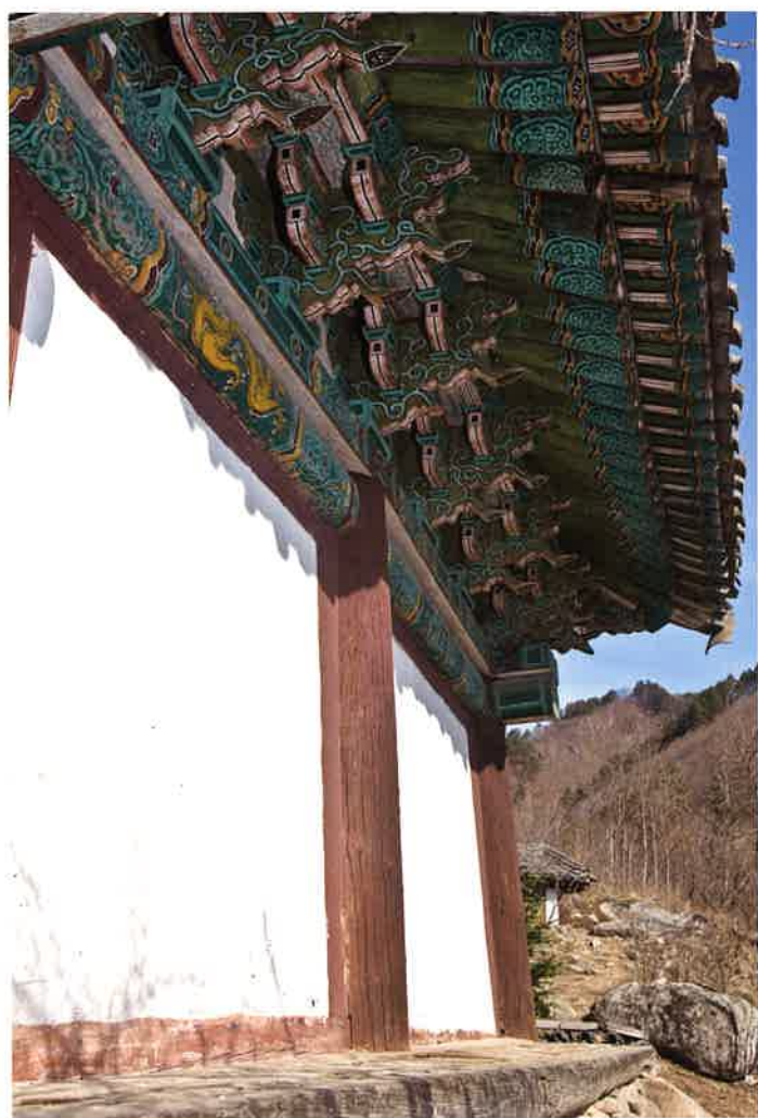
대웅전 동쪽 측면 처마와 공포 / 大雄殿 東側 軒·栱包 eastern side eaves and brackets, Taeungjön hall
