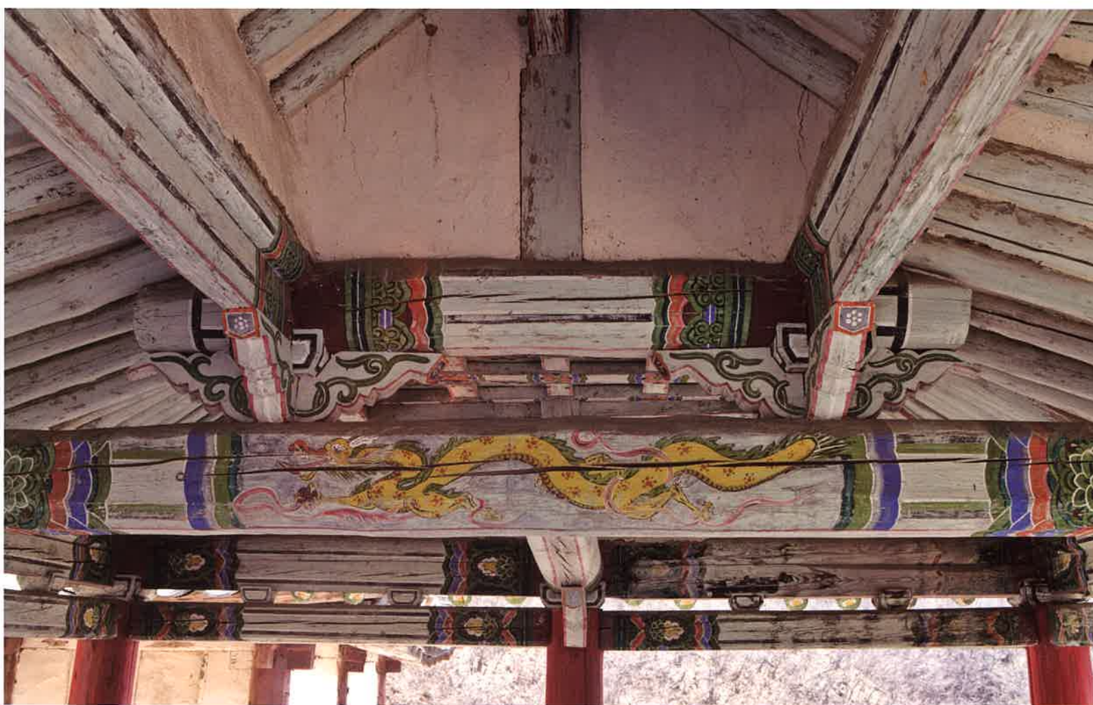
애월루 내부 대들보와 종보 / 愛月樓 內部 大樑·宗樑 / main beam and supporting beam, Aewöllu
