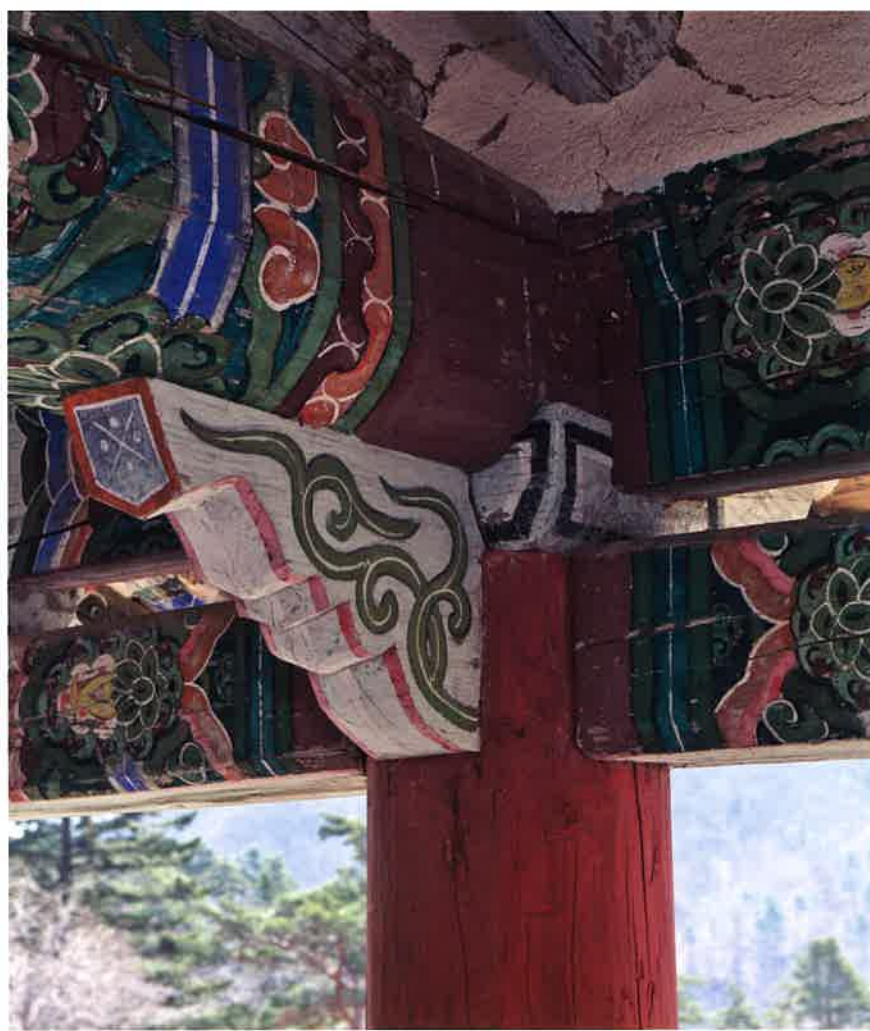
애월루 내부 주간포 / 愛月樓 內部 柱間包 / brackets between columns, Aewöllu
