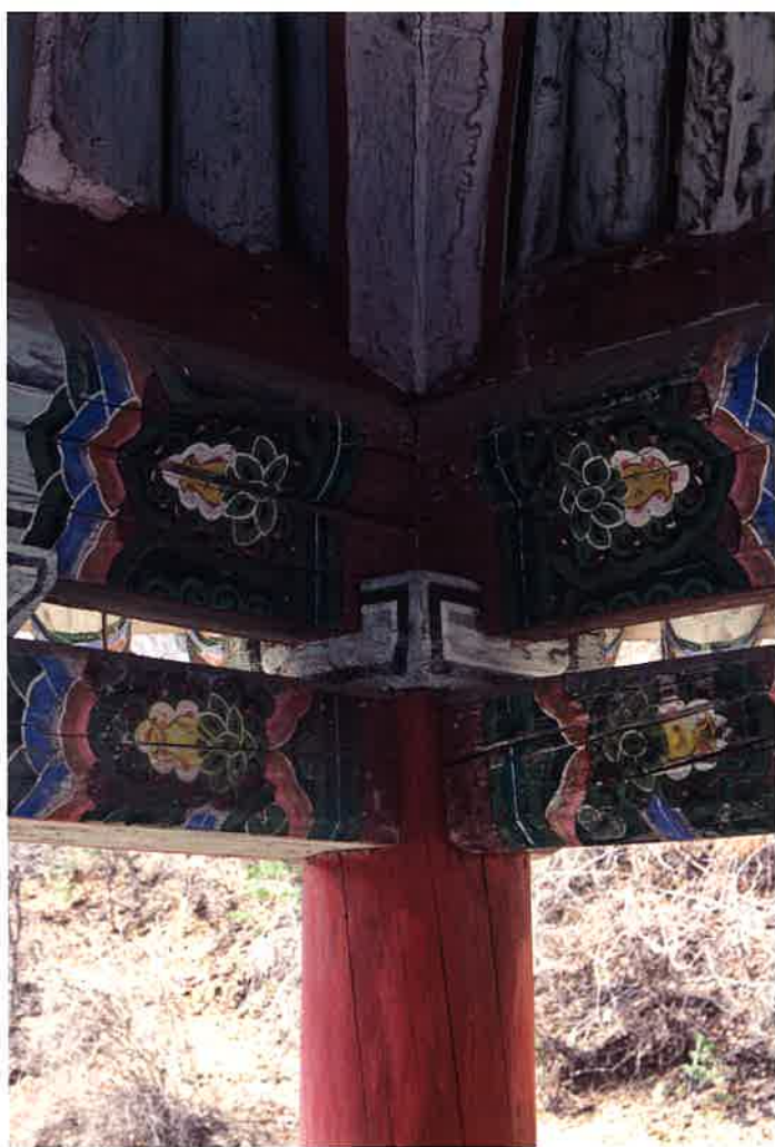
애월루 내부 귀포 / 愛月樓 內部 耳包 / corner brackets, Aewöllu
