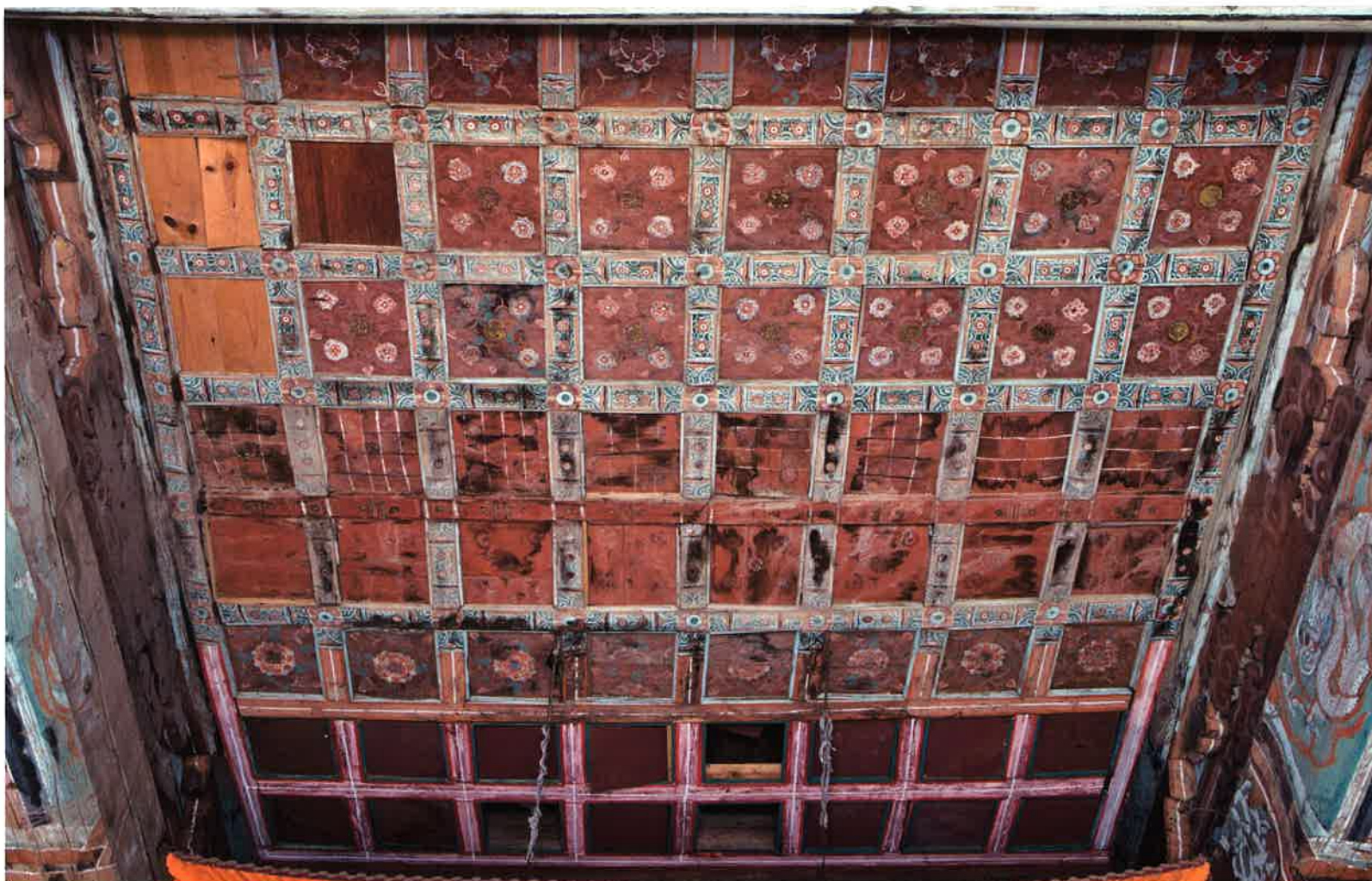
대웅전 내부 소란반자 / 大雄殿 內部 格子天障 / latticed ceiling, Taeungjeon hall
